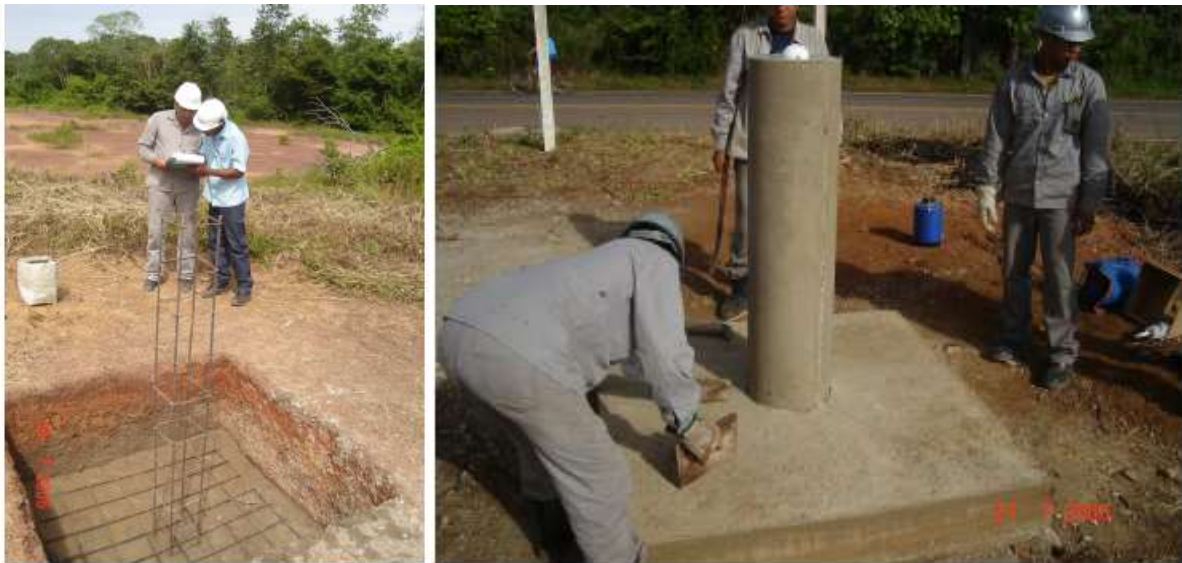
Figura 2-24 – Exemplo de correta instalação de marco geodésico. a) Ferragens das estacas e do pilar devidamente engastadas na ferragem da base. b) Exemplo do marco pronto (IBGE, 2008, adaptada pelo autor).
