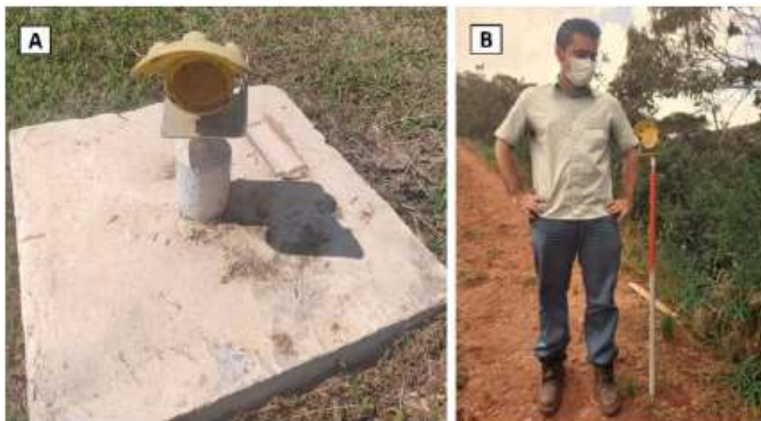
Figura 2-25 – Exemplos de condição dos prismas de monitoramento. a) Boa prática de instalação. b) instalação não indicada (Magalhães et al. , 2023).
