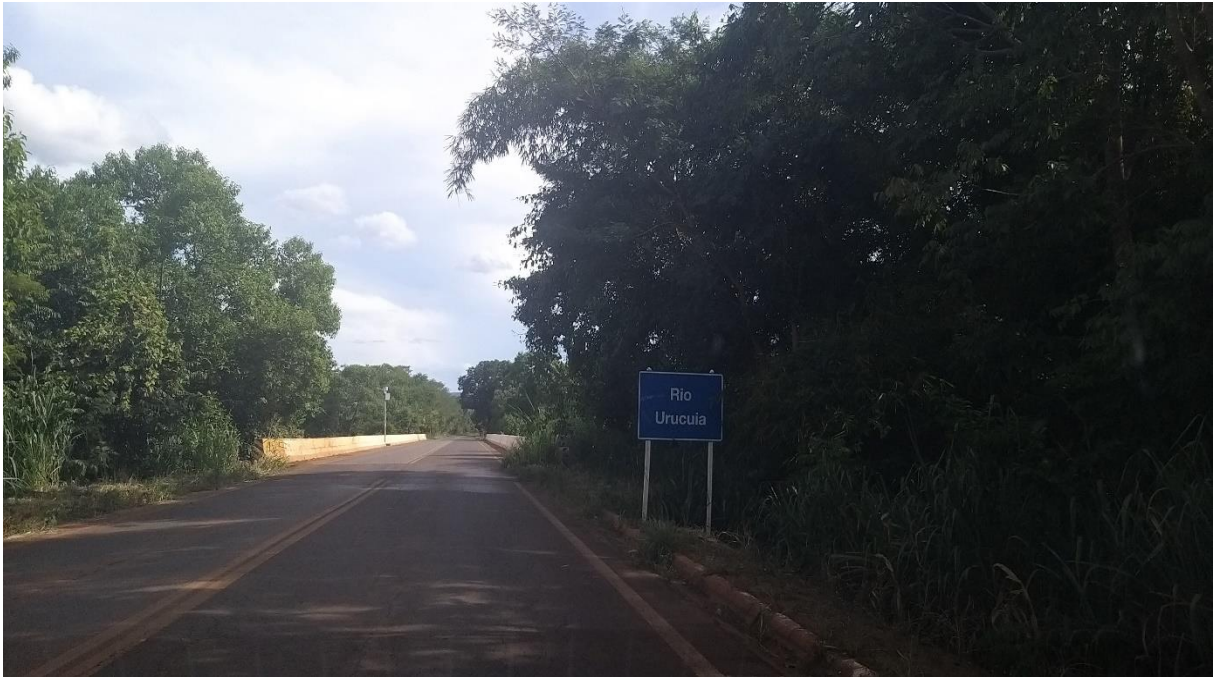
Figura 05 – Ponte sobre o Rio Urucua antes do acesso de Arinos, Minas Gerais
