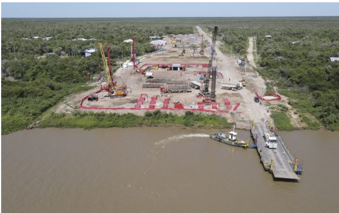
Figura 10 - Construção da ponte internacional entre Porto Murtinho e Carmelo Peralta
