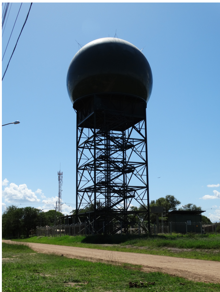
Figura 5 - Radar para controle de tráfego aéreo de baixa altitude – Porto Murtinho/MS
