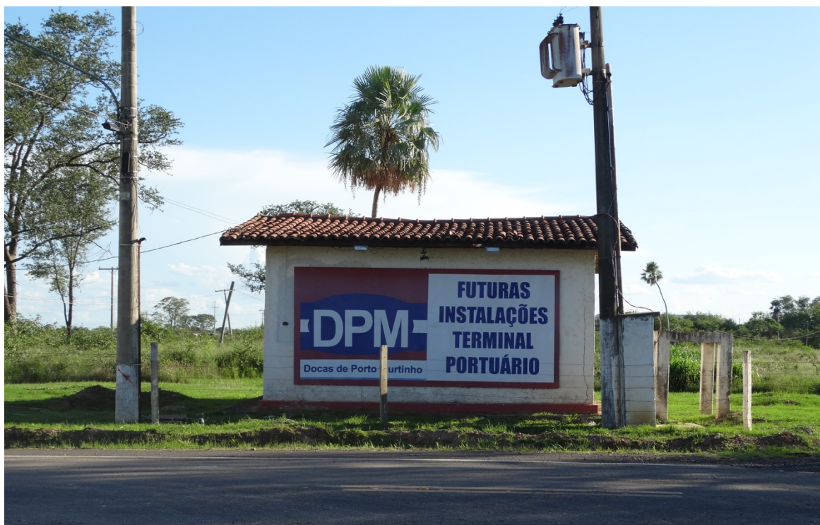
Figura 12 - Área destinada à construção do da DPM – Porto Murtinho
