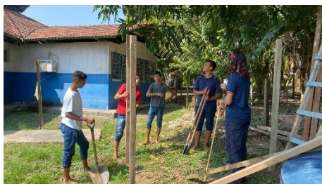
Figura 21 - Processo de construção do Simulador de chuva III
