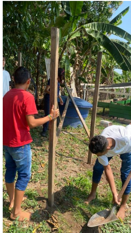
Figura 22 - Processo de construção do Simulador de chuva II
