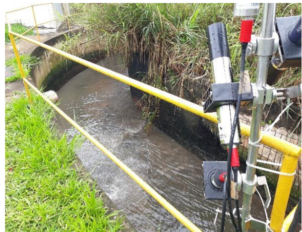
Figura 27 – Visada do radiômetro na galeria de águas pluviais. O tubo de saída da ETE aparece logo a jusante na margem esquerda da galeria (cor branca).
