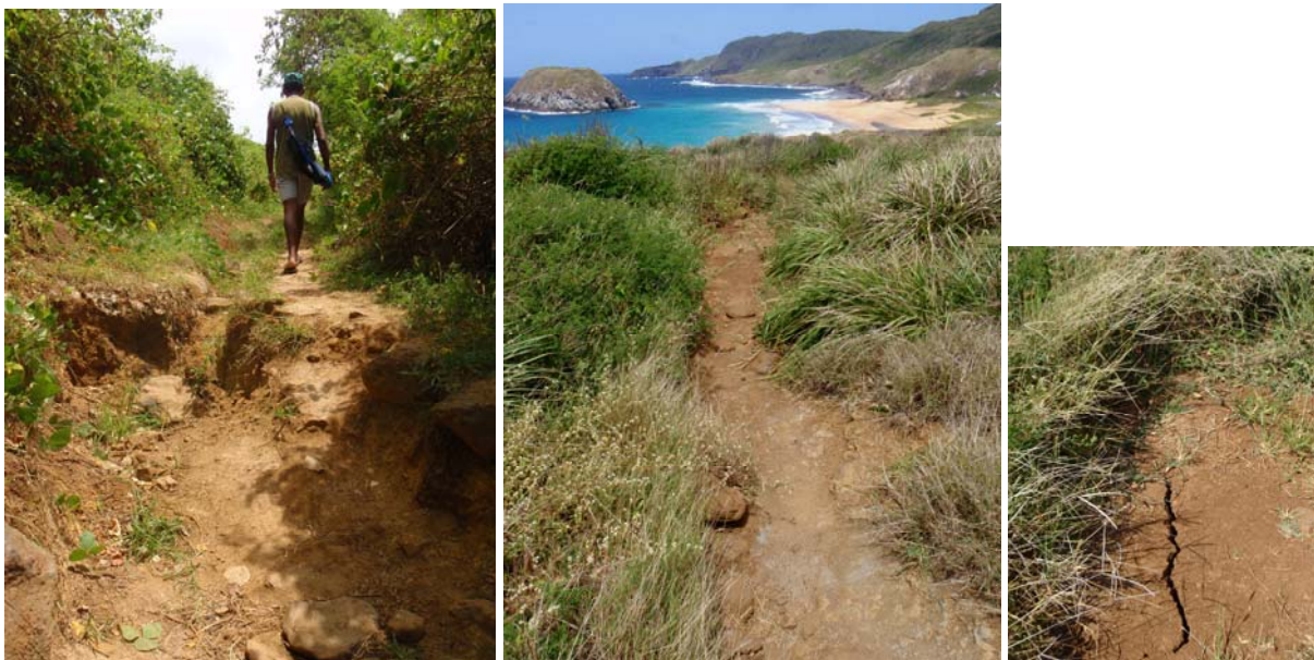
Fotografias 2.23, 2.24, 2.25 - Processos erosivos e o comprometimento da estrutura das trilhas: à esquerda, trilha para a Praia do Atalaia; centro e direita, trilha da praia do Leão.
