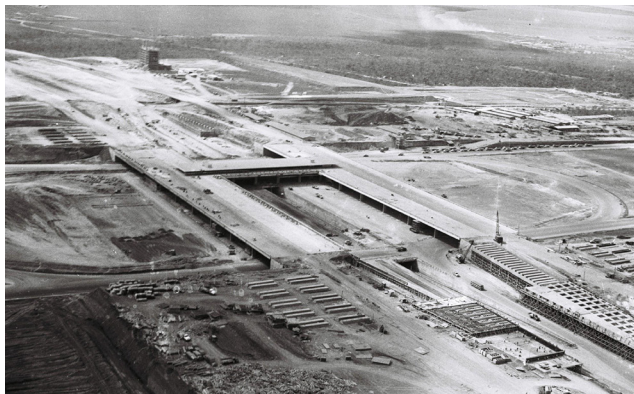
Imagem 2. Operações de terraplanagem na construção da Rodoviária do Plano Piloto de Brasília
