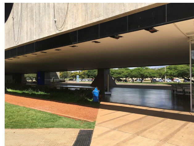
Imagem 4. Pilotis e estacionamento-parque no Centro Cultural Banco do Brasil em Brasília, evidenciando estratégias de ajardinamento
