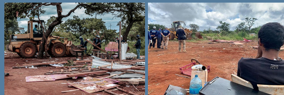
Figura 63: Derrubada das casas e escola pela operação. Foto: Scarlett Rocha
