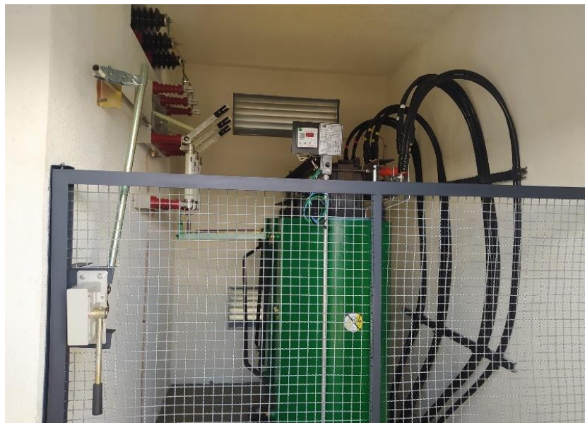
Figura 4.25. Segundo particionamento - Transformador 1 e seus componentes.
