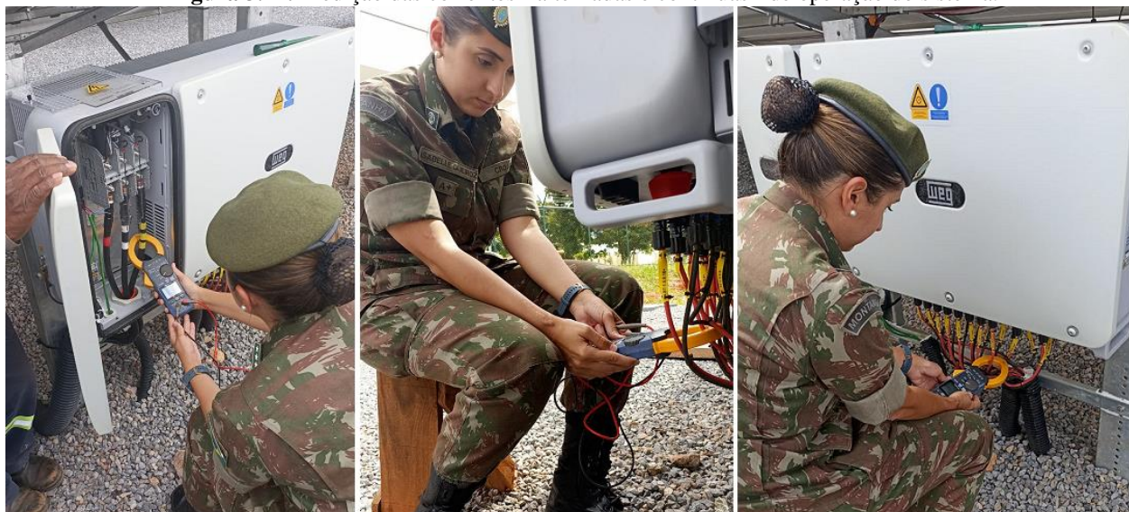
Figura 3.12. Medição das correntes - alternadas e contínuas - de operação do sistema.
