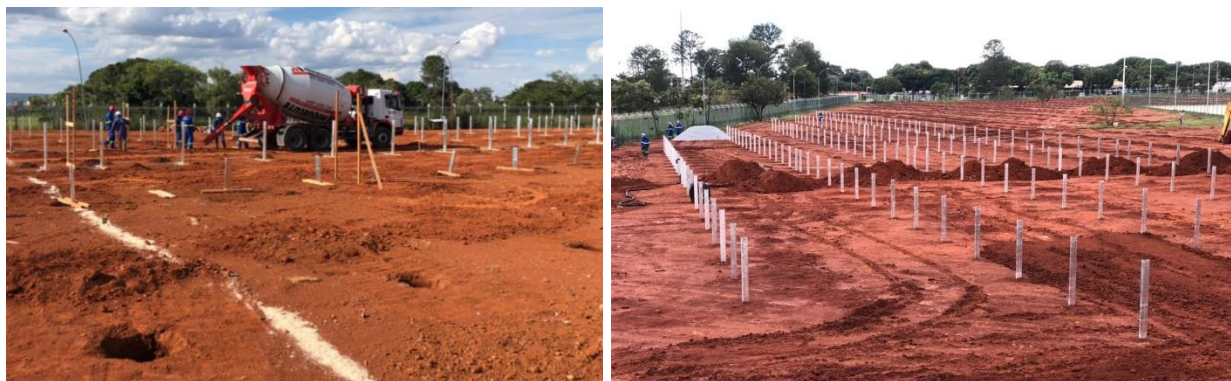
Figura 4.10. Concretagem da estrutura de suporte dos módulos FV.
