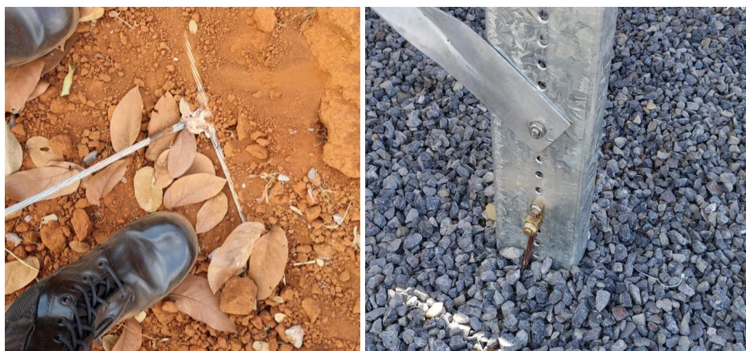
Figura 4.19. Conexões da malha de aterramento.
