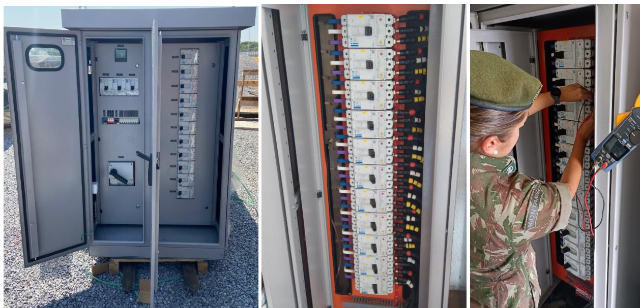
Figura 4.24. Instalação dos QGBT.
