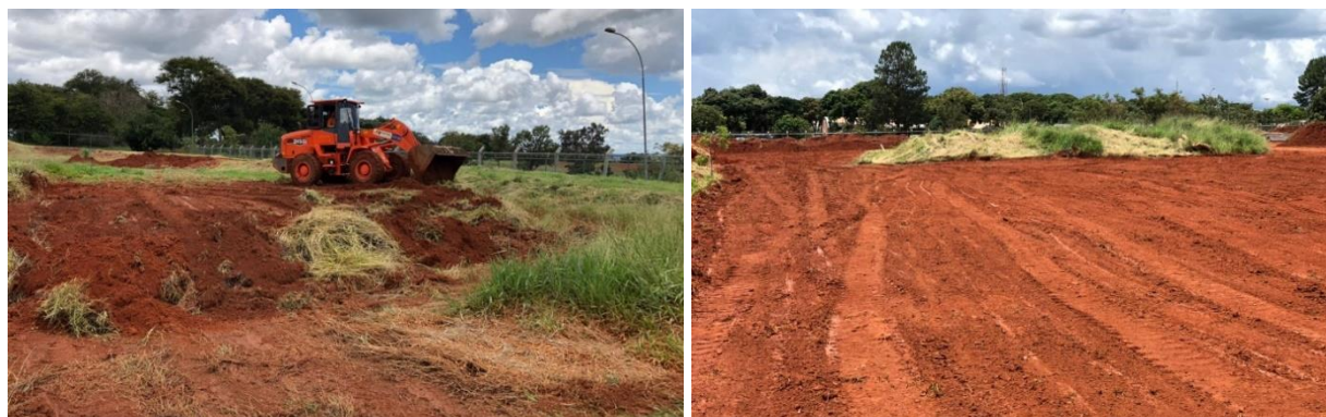
Figura 4.8. Remoção de camada vegetal.
