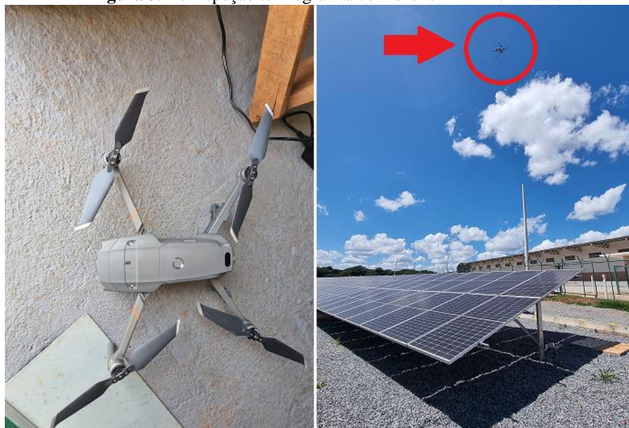
Figura 3.14. Inspeção termográfica com drone FLIR DJI Mavic 2.
