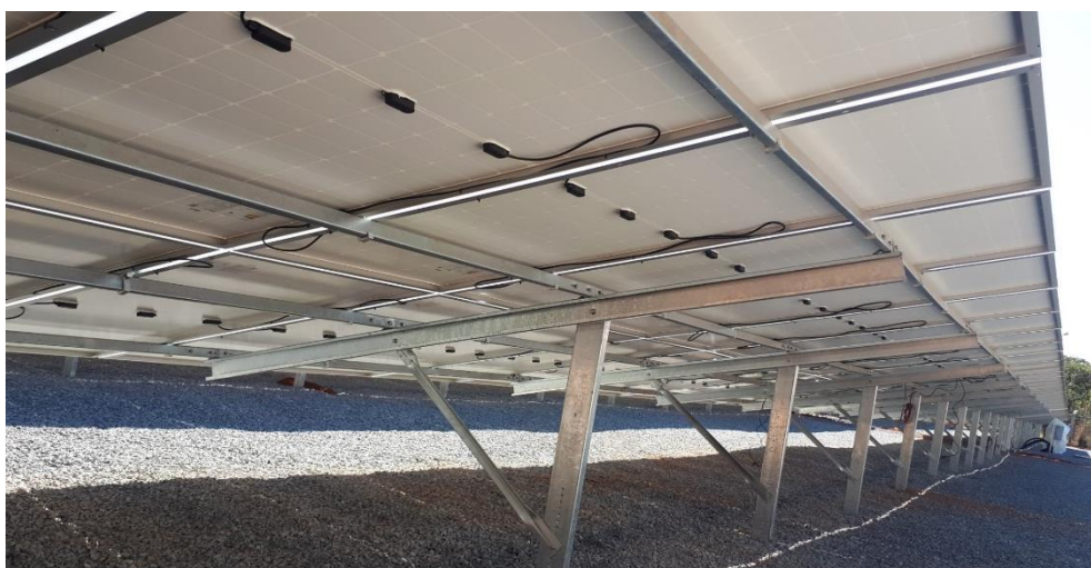
Figura 4.13. Montagem das séries fotovoltaicas.
