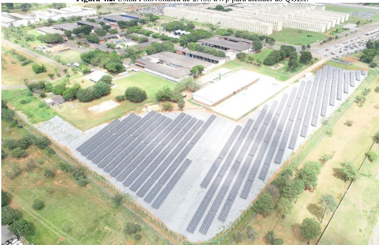
Figura 4.2. Usina Fotovoltaica de 2.408 kWp para atender ao QGEx.
