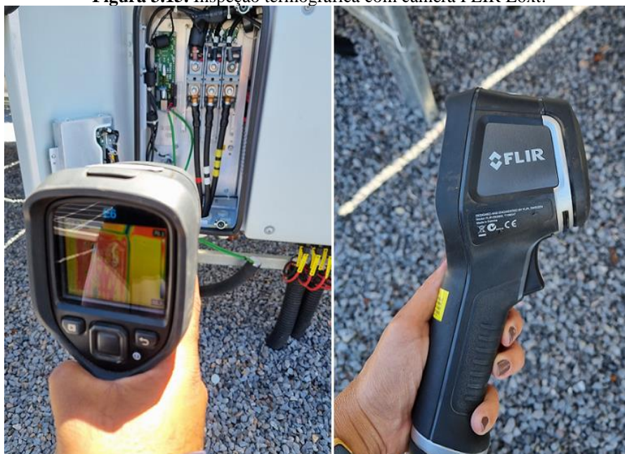
Figura 3.15. Inspeção termográfica com câmera FLIR E6xt.
