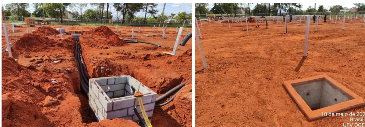
Figura 4.11. Escavação das valas e fixação das caixas de passagem.
