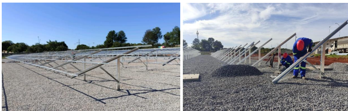
Figura 4.12. Aplicação de camada de brita.
