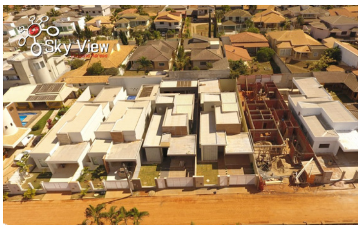
Figura 6.12 – Construção de casa
