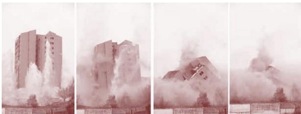
Figura 2.5 – Edifício Liberdade no instante do colapso (COURI et al , 2013)
