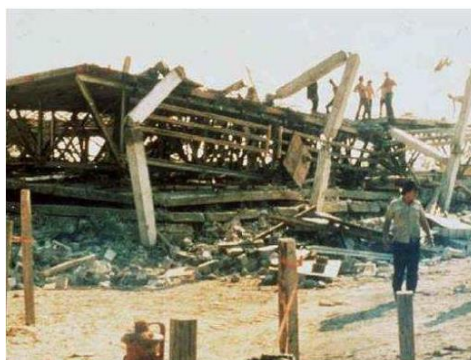
Figura 2.4 – Harbour Condominium após o colapso progressivo (KUKORLO, 2009)
