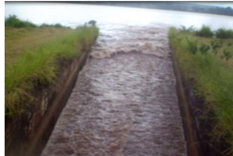
Figura 4.28. Encontro das águas da galeria de drenagem da estação C.O. UnB com o Lago Paranoá.
