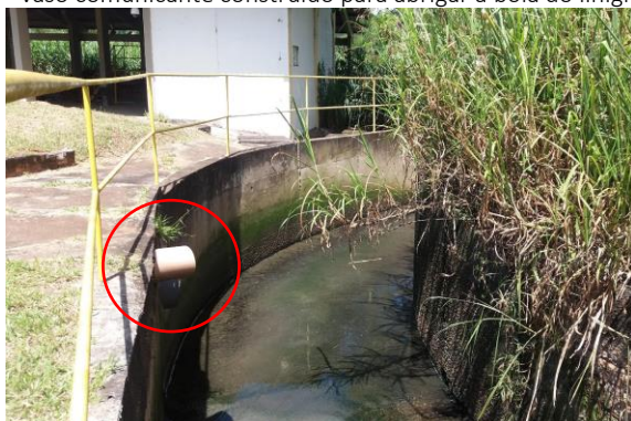
Figura 4.31. Curva imediatamente a jusante da estação, detalhe para o lançamento do efluente da ETE.
