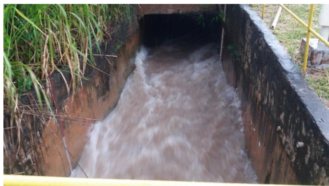
Figura 5.4. Passagem da onda de cheia na galeria de drenagem pluvial da estação RF I.
