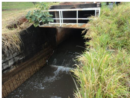
Figura 4.21. Exutório da galeria de drenagem da estação C.O. UnB.
