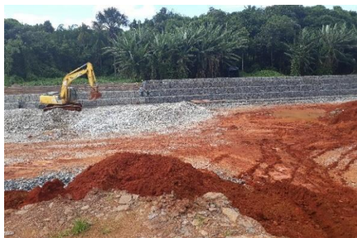
Figura 5.32. Obras de uma bacia de detenção no VP.
