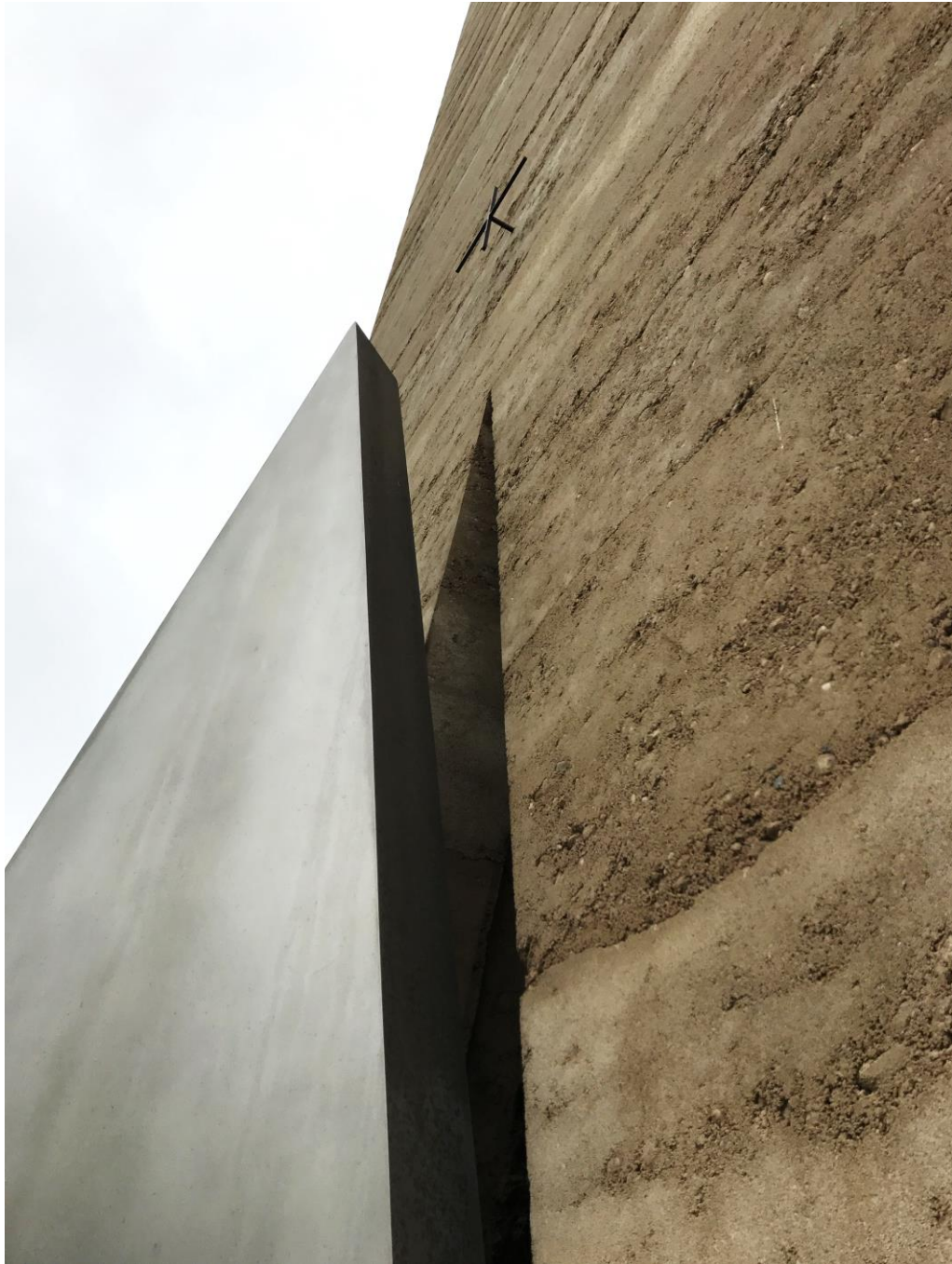
(Porta triangular e materialidade da face externa)
