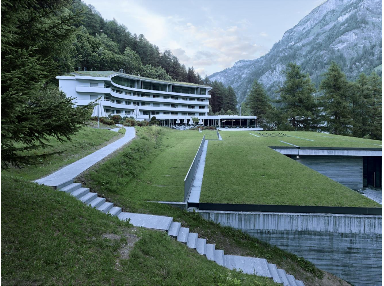
(Lajes de cobertura das Termas recobertas por vegetação)
