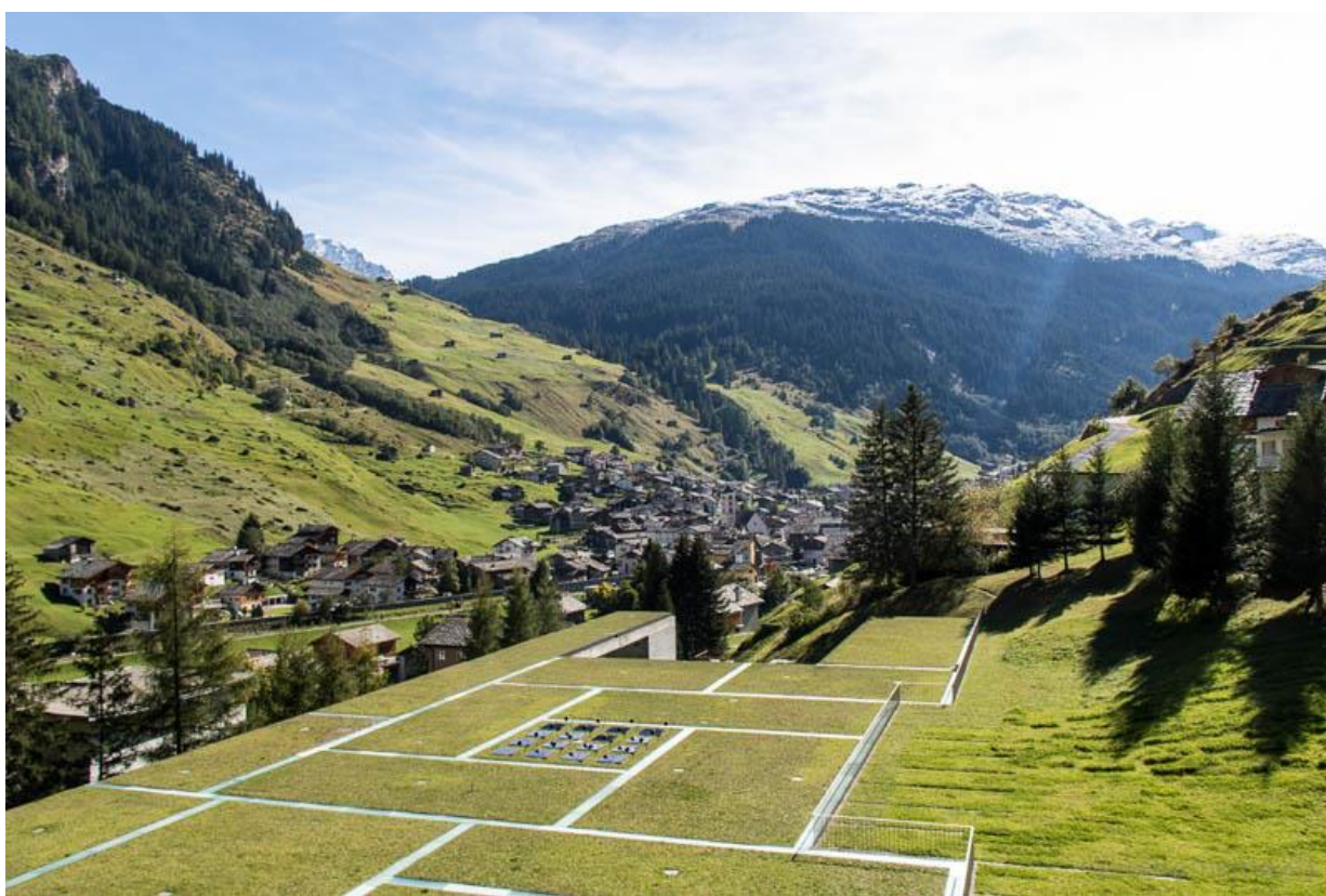
(Vista geral do lugar de implantação e da cobertura das Termas)
