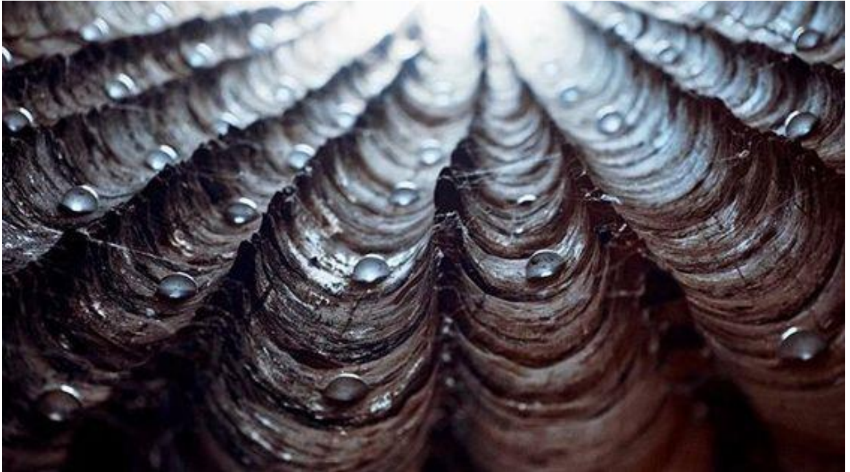
(Textura interna das paredes da Capela)
