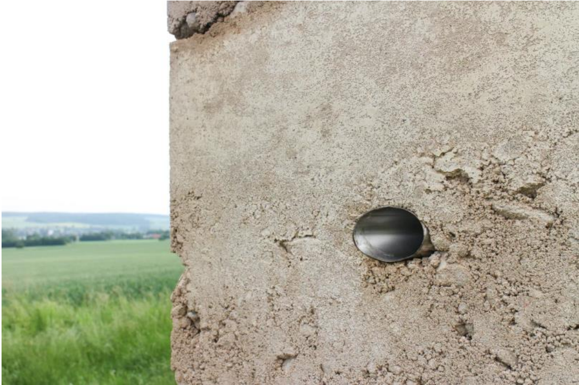
(Detalhe do tubo metálico no aglomerado)
