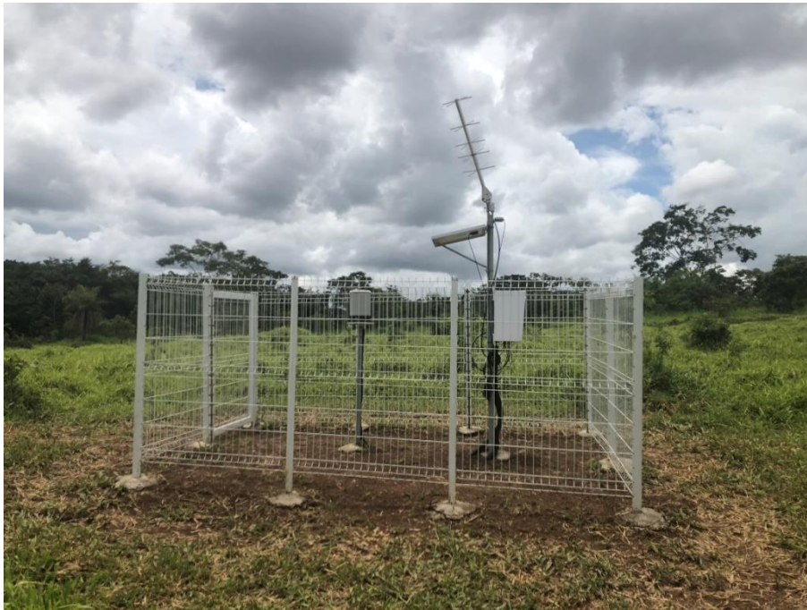
Figura 31. Estação meteorológica e sistema de transmissão de dados na UH rio Jardim. (Fev/2020) – 15°58'22,95" / 47°24'28,94".
