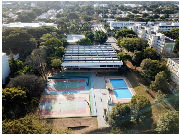
Figura 7 – Vista aérea da Escola Parque 308 Sul
