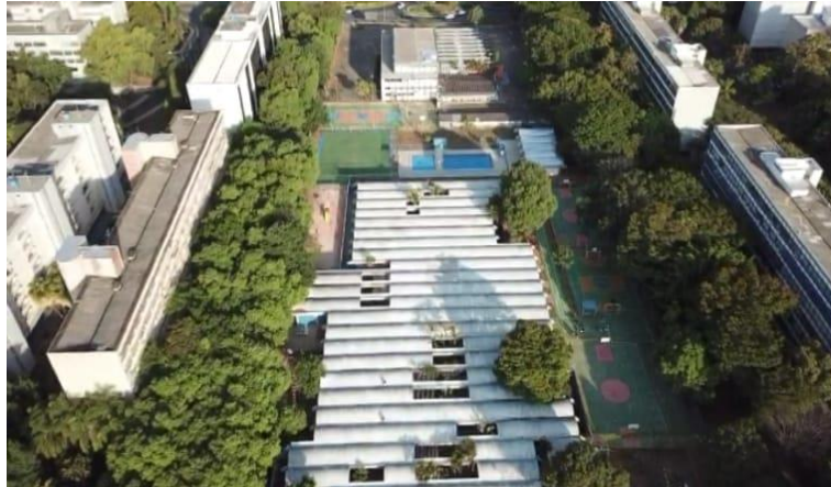
Figura 10 – Vista aérea da Escola Parque 313/314 Sul
