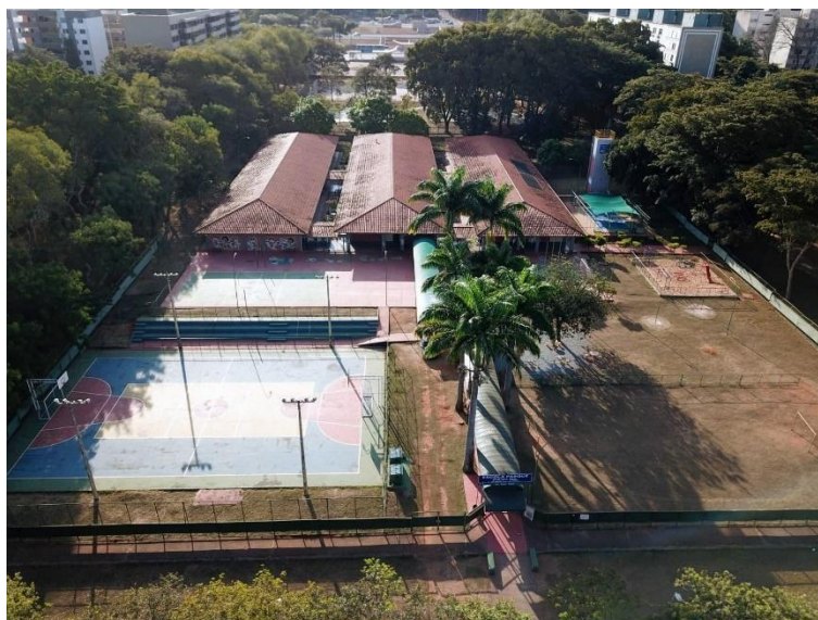
Figura 15 – Vista aérea da Escola Parque 210/211 Sul
