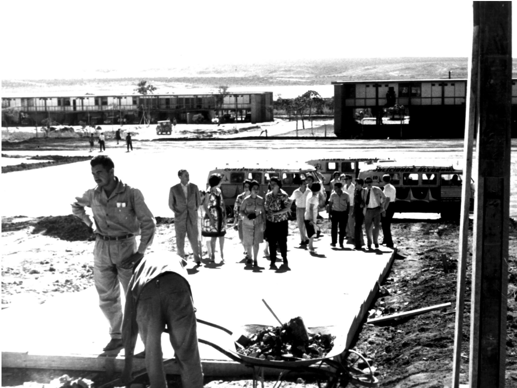
Figura 4: Oca em construção
