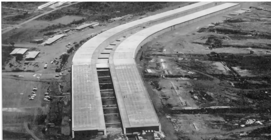
Figura 15: Instituto Central de Artes em construção
