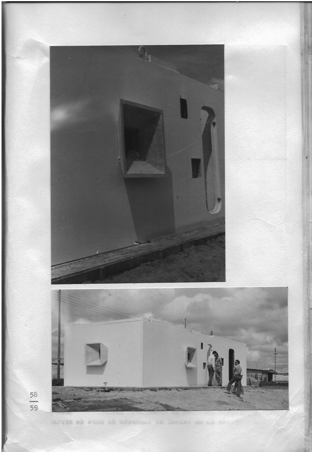
Figura 20: Construção do Protótipo Residencial
