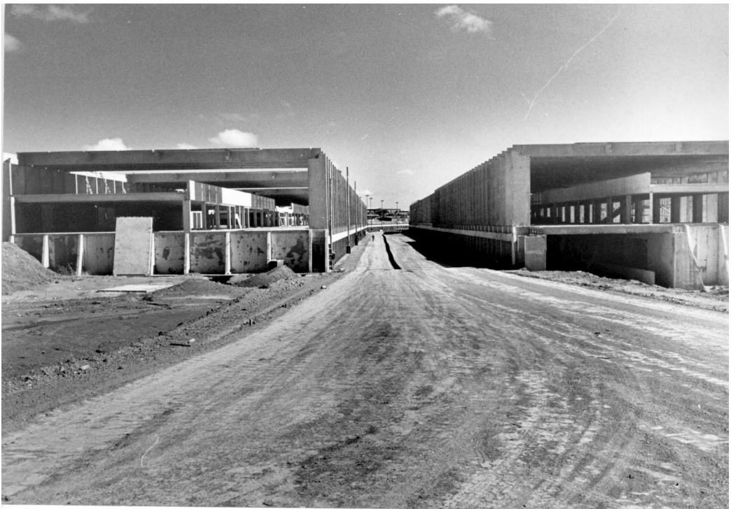
Figura 14: Instituto Central de Artes em obras
