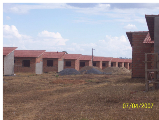
Figura 4.4: Conjunto habitacional Associação Habitacional Morar Bem, em Goiânia (GO), financiado com o Fundo de Desenvolvimento Social
