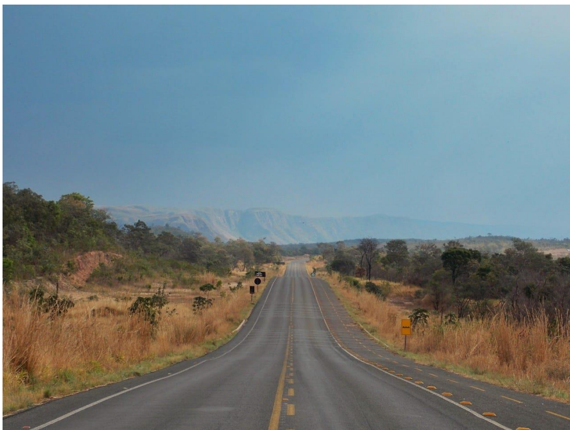
Apêndice 8 - Vista da rodovia estadual GO-239.
