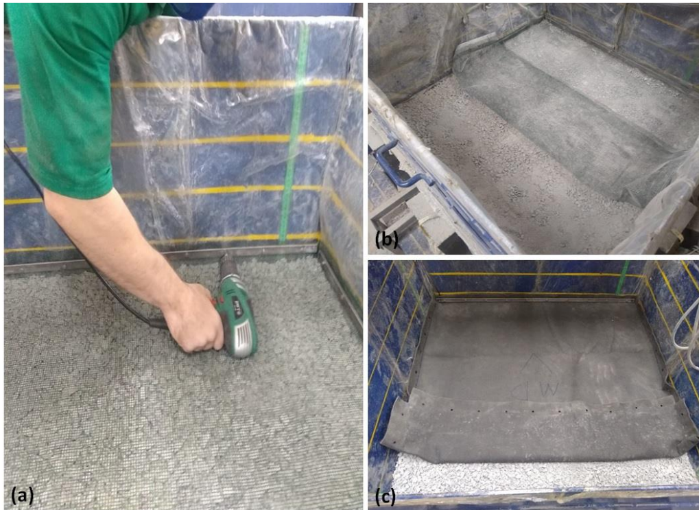
Figura 3.18 – Instalação da 2ª camada de reforço: (a) Fixação das hastas metálicas; (b) Microgrid e (c) Geotêxtil Não-Tecido.
