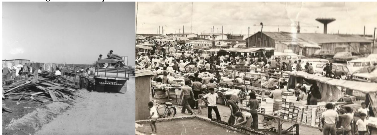
Figura 1 - Demolição de barracos e transferência dos moradores / centro de Ceilândia
