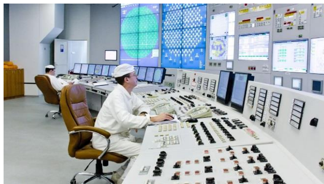
Figura 33 - Painel de controle de Usina Nuclear. Fonte: Google Imagens
