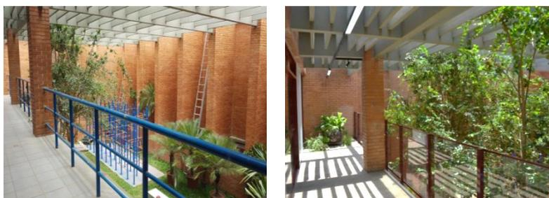
**Figuras 419 e 420.** No segundo andar, o pergolado fica ainda mais perceptível. Um corredor forma um mezanino de circulação, protegido por uma cobertura envidraçada e que dá acesso às salas multiusos. Do alto é possível avistar ainda a vegetação que alcança a estrutura, mantendo-se no nível do observador. Fotografias próprias do autor, 2017.
