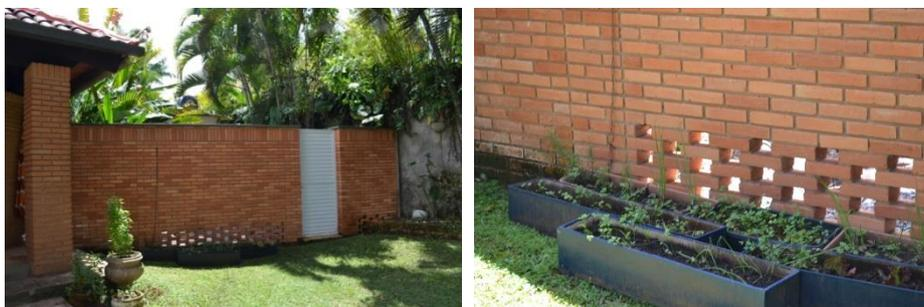
**Figuras 294 e 295.** Em uma das reformas, o muro que criou o jardim de inverno e dá privacidade ao solário do quarto de casal também foi feito em tijolos aparentes, seguindo a mesma linguagem da casa. Na borda de cima, peças na vertical compõem toda a faixa superior do muro, interrompido somente pela porta de acesso. Em baixo, vãos de tijolos garantem a ventilação por meio da abertura entre os blocos. Fotografia própria do autor, 2019.
