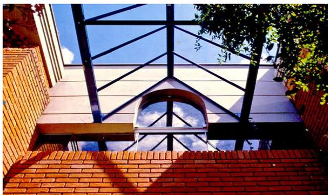
**Figura 185.** A cobertura em duas águas com proteção de vidro. A estrutura percorre toda a entrada da casa até a parede frisada, feita em concreto aparente. Logo abaixo, o detalhe da janela serliana – um recurso arquitetônico neoclássico que combina um arco de volta perfeita com vãos retos, repousa sobre a parede de tijolos e vidro. José Galbinski, 1988.
