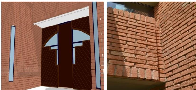
**Figuras 276 e 277.** A laje à mostra e a pele de tijolos como revestimento. Sobre a varanda, tijolos em pé formam uma espécie de moldura na parte superior e também na borda inferior da parede, onde encontramos também peças recuadas, criando um espaçamento em baixo relevo entre o volume projetado e a parede do quarto logo acima. Maquete eletrônica feitas pelo autor, 2021. Fotografia própria do autor, 2019.
