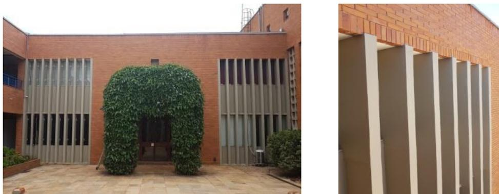
**Figuras 526 e 527.** Os frisos de concreto formando os brises da sala multiuso. Fotografias próprias do autor, 2017.
