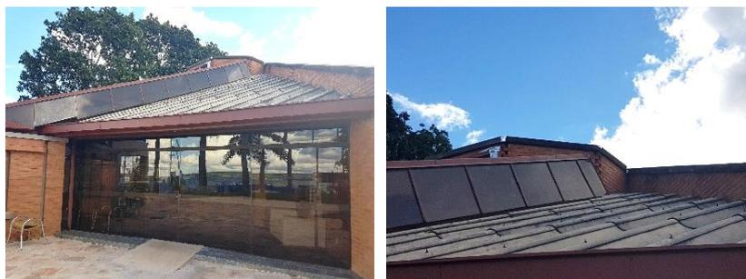
**Figuras 136 e 137.** Vista de uma das empenas da cobertura. Na imagem é possível verificar o shed metálico se abrindo para o exterior. Depois, o sentido das telhas, deslocadas  $67,5^\circ$  no plano horizontal e  $9^\circ 78'$  no sentido vertical, segundo os estudos do arquiteto. Fotografias próprias do autor, 2019.
