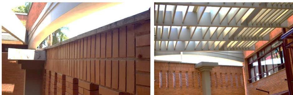
**Figuras 498 e 499.** Internamente, o pilarete que sustenta a parede também se projeta do muro. Sobre ele, o arquiteto utilizou um capitel escalonado, buscando uma releitura clássica para o ambiente. Fotografias próprias do autor, 2017.
