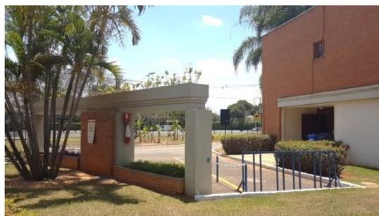
**Figura 525.** A viga curva da central de gás se apoia sutilmente sobre os pilares, também em concreto à vista. Abaixo, duas floreiras de tijolos resguardam a parede central feita do mesmo material. A entrada da área de serviços e a arquitrave formando a viga superior. Naquela parede encontramos: tijolos, concreto e alvenaria tradicional, um manifesto da mescla de materiais utilizada pelo arquiteto. Fotografia própria do autor, 2017.
