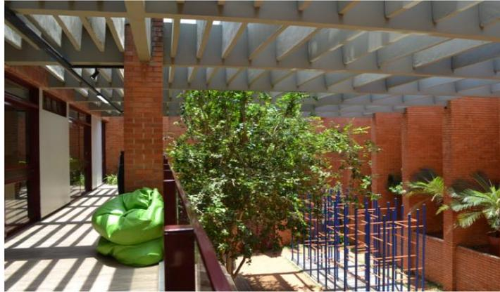
**Figura 348.** Afastadas propositadamente umas das outras, a distância entre os brises obedecem a uma medida calculada em razão da inclinação da incidência solar ao longo do dia, cuja variação faz com os raios solares não adentrem no recinto – apenas no jardim externo. Com isso, o desconforto térmico na biblioteca é amenizado graças à disposição calculada das peças do pergolado. Fotografia própria do autor, 2017.
