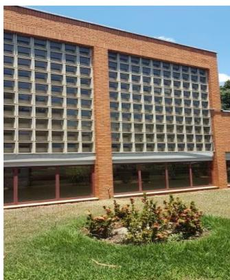
**Figura 514.** Vista da fachada interna do pátio, tendo os cobogós como elementos estéticos e funcionais, servindo de vedação do espaço interno: entrada de luz e ventilação naturais. Fotografia própria do autor, 2019.
