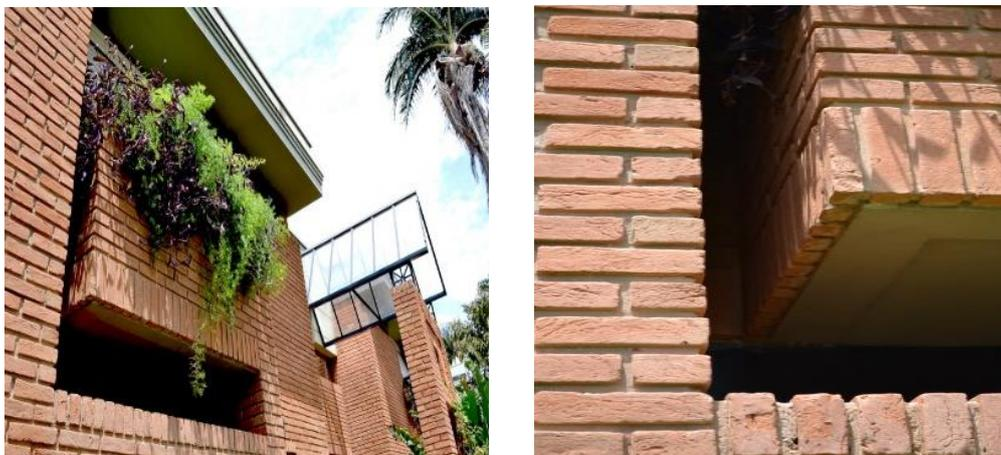
**Figuras 281 e 282.** O volume das jardineiras parece “flutuar” na fachada. Recuada da parede lateral, suas bases também são elevadas e não tocam os fundos. Elas são estruturadas apenas por uma de suas laterais, e os rasgos fazem com que se projetem da parede. Fotografias próprias do autor, 2019.
