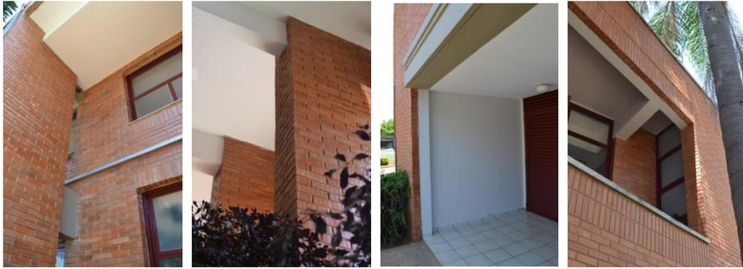
**Figuras 479, 480, 481 e 482.** Flagrantes da estrutura convencional aflorada. Por fora, o tijolo teve o papel de revestimento, envolvendo os pilares e as paredes, em favor do gosto preferido pelo arquiteto. Fotografias próprias do autor, 2019.
