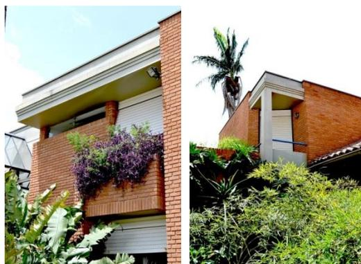
**Figuras 239 e 240.** As jardineiras em balanço são elementos fundamentais para a organização dos volumes da fachada. Os banheiros são ventilados e iluminados por janelas basculantes que ficam na parte superior da alvenaria de tijolos e recebem a proteção da viga frisada. Os cantos dos quartos abrigam uma varanda coberta, com vista privilegiada para o jardim e a área de lazer. Fotografias próprias do autor, 2019.
