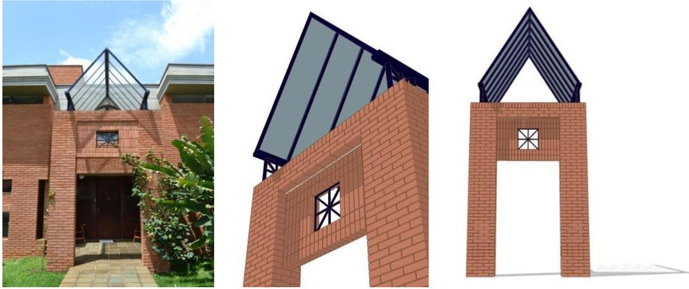
**Figuras 272, 273 e 274.** As propriedades físicas do pórtico da entrada principal e as variações no uso do tijolo. Elementos em diferentes alinhamentos marcam as reentrâncias, demarcando o sombreamento. Fotografia própria do autor, 2019. Maquetes eletrônicas feitas pelo autor, 2021.
