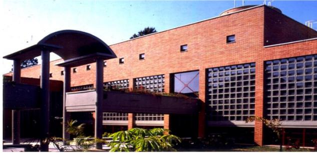
**Figura 335.** Elementos estruturantes em concreto aparente, rodeados pelas paredes de tijolos. A mistura de materiais denota a variedade de acabamento do prédio. O pórtico sustenta duas grandes coberturas que servem de floreiras e protegem a calçada de ligação entre os blocos. A caixa de concreto adentra o interior do edifício, tendo com anteparo, um grande painel envidraçado, demarcando uma das entradas laterais. José Galbinski, 1991.
