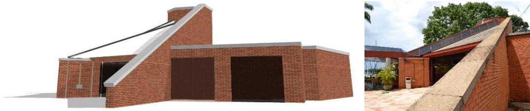
**Figuras 155 e 156.** Estruturas de concreto emolduram toda a porção superior do Pavilhão da Náutica. Maquete eletrônica feita pelo autor; Fotografia própria do autor, 2019.
