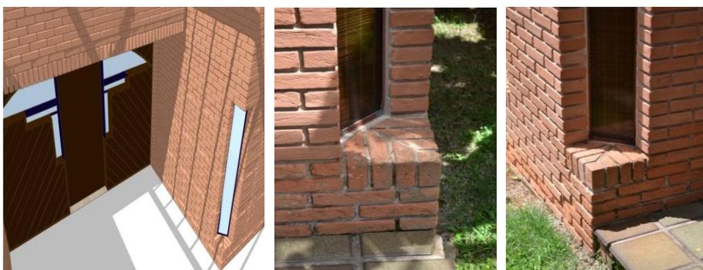
**Figuras 278, 279 e 280.** O rasgo na quina das paredes facilita a iluminação no interior da casa. Num requadro feito de tijolos em 45°, as peças foram dispostas uma com as outras, e o tijolo foi recortado no centro das peças e no sentido em que avança para a parede, configurando o que chamamos de “RowLock”. Maquete eletrônica feita pelo autor, 2021. Fotografias próprias do autor, 2019.
