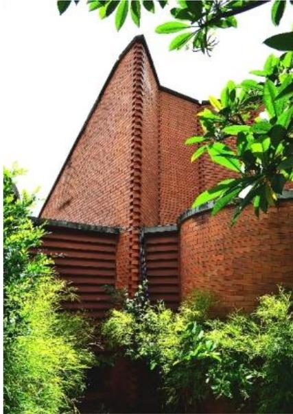
**Figura 143.** Fachada posterior do Restaurante, numa demonstração da composição da alvenaria facetada de tijolos. Fotografia própria do autor, 2019.
