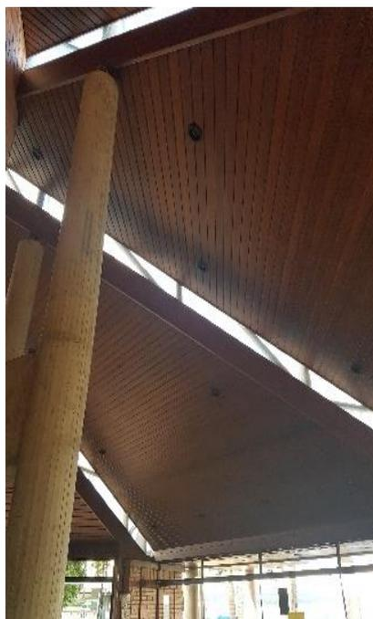
**Figura 134.** Os “rasgos” na cobertura. Iluminação natural por meio dos sheds existentes entre os planos do telhado. Fotografia própria do autor, 2019.
