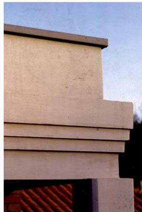
**Figura 190.** A arquitrave frisada, construída em concreto aparente e em diferentes níveis de altura, destoa do paredão de tijolos avermelhados, cujo lintel repousa sutilmente sobre a coluna. Originária da arquitetura clássica, o capitel do pilar, propositalmente, não recebeu nenhum acabamento clássico, apenas serve de apoio à viga. José Galbinski, 1988.
