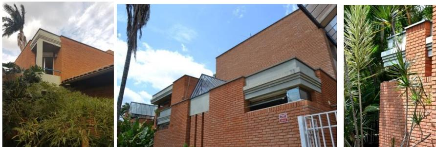
**Figuras 263, 264 e 265.** As paredes de tijolos se revezam entre as estruturas de concreto aparente, formadas pelas vigas, pilares e lajes. A interrupção do arranjo de tijolo cria a ancoragem das arestas, e a interpretação dos planos resumem o movimento e a regressão das paredes avermelhadas em contraste às estruturas acinzentadas. Fotografias próprias do autor, 2019.
