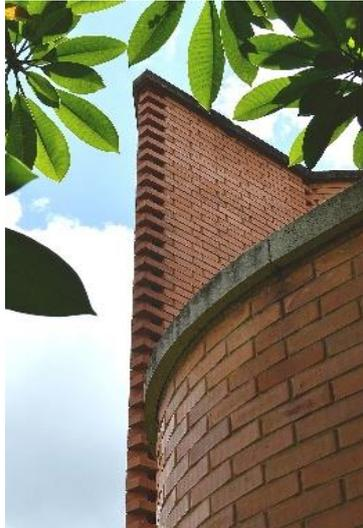
**Figura 149.** O ponto mais alto do muro, um flagrante das reentrâncias na quina do paredão e o sombreamento causado pelo desencontro e subtração das peças de tijolo. Fotografia própria do autor, 2019.
