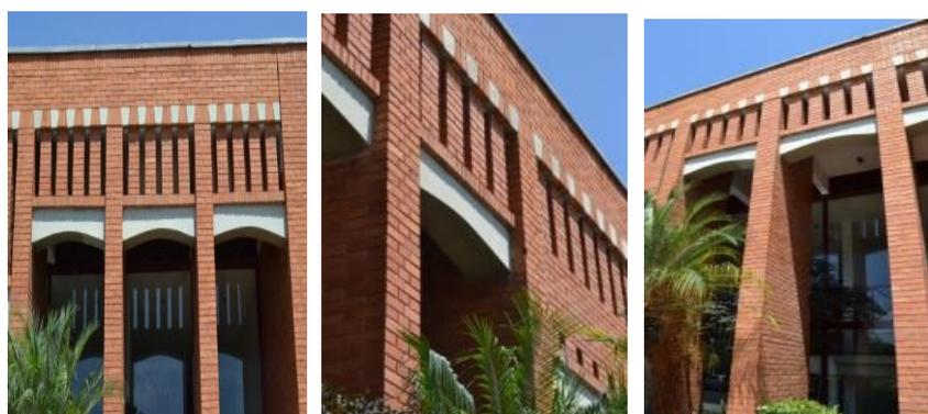
**Figuras 312, 313 e 314.** As colunatas transmitem a mensagem clássica: os espaços repousam em colunas e essas marcam as peças de concreto, formando uma espécie de aduelas<sup>146</sup>, que se revezam com os tijolos, em uma composição elegante e harmoniosa entre os blocos cerâmicos e o concreto acinzentado. Fotografias próprias do autor, 2017.
