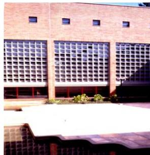
**Figura 336.** Os painéis se apoiam sobre vigas frisadas, que por sua vez, repousam sobre grandes esquadrias metálicas que permitem a visão do claustro e favorecem a passagem da iluminação natural. José Galbinski, 1991.
