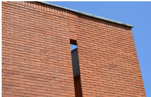
**Figura 487.** A moldura de tijolos em pé fechando os rasgos da fachada leste, um gesto sutil que quebra o movimento horizontal do muro. Fechando o conjunto, uma fileira de tijolos na mesma posição (*soldier course*) encerra a porção superior da edificação, que recebe ainda uma pingadeira em concreto aparente que se projeta sobre os tijolos. Fotografia própria do autor, 2017.
