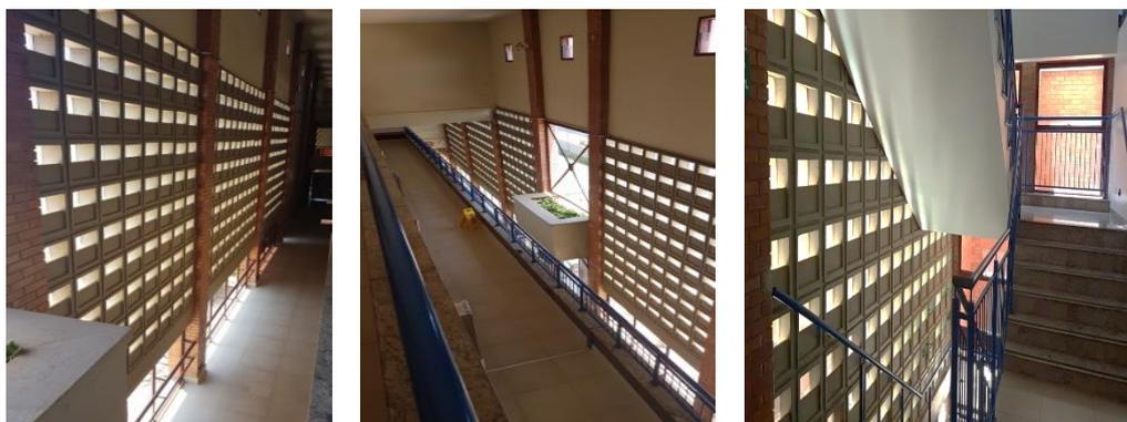
**Figuras 522, 523 e 524.** Vista do interior. Os cobogós envidraçados, dispostos em toda a área da fachada, constituem uma barreira física, mas não visual. Sua permeabilidade preserva a iluminação do recinto e também a passagem de ar para dentro da edificação, o que torna o ambiente aprazível em relação à temperatura e à iluminação natural, garantindo a qualidade térmica nos corredores e salas. Fotografias próprias do autor, 2019.
