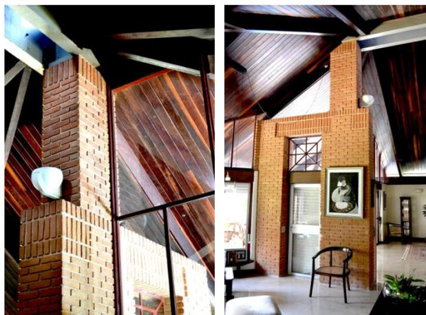
**Figuras 229 e 230.** O portal revestido de tijolos é mais um dos elementos que integra o grande salão social. O pilar avança em sentido à cobertura e a cumeeira se apoia sutilmente através das vigas de concreto, abrigando o rasgo do lanternim e deixando passar a iluminação zenital. Fotografias próprias do autor, 2019.
