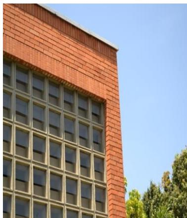
**Figuras 517, 518 e 519.** O sistema que forma os painéis: a partir do terceiro pavimento, janelas quadriculadas, em seguida, o conjunto de cobogós, apoiado sobre a viga de concreto. Encerrando o arranjo, esquadrias metálicas com vedação em vidro. Juntos, compõem a estética da fachada do pátio e a formação do mosaico do corredor. Ilustração feita pelo autor, 2021. Fotografias próprias do autor, 2019.
