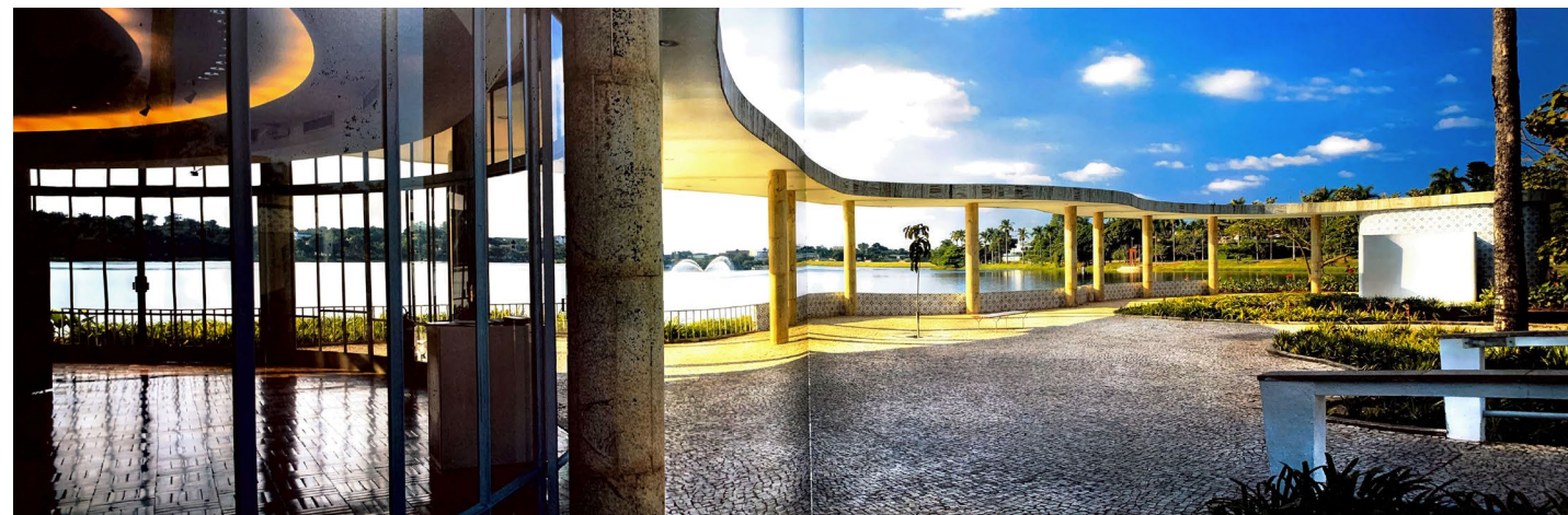
03. Nesta fotografia percebe-se o ritmo e a leveza dos pilares de sustentação da marquise curva. Contrapondo os croquis acima com esta imagem, percebe-se quanto Niemeyer valoriza a marquise nos desenhos, ocultando de certa forma os pilares. Fonte: A doce revolução de Oscar Niemeyer, 2007.
