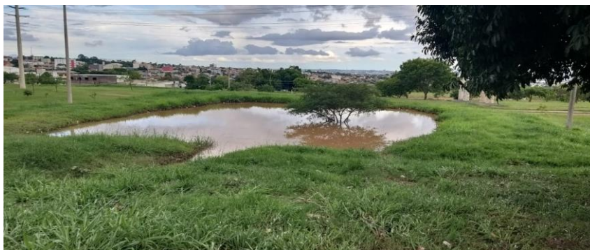
Figura 18: Poço de retenção no Taguaparque, Taguatinga-DF Fonte: acervo pessoal da autora. Data: 11/12/2020.
