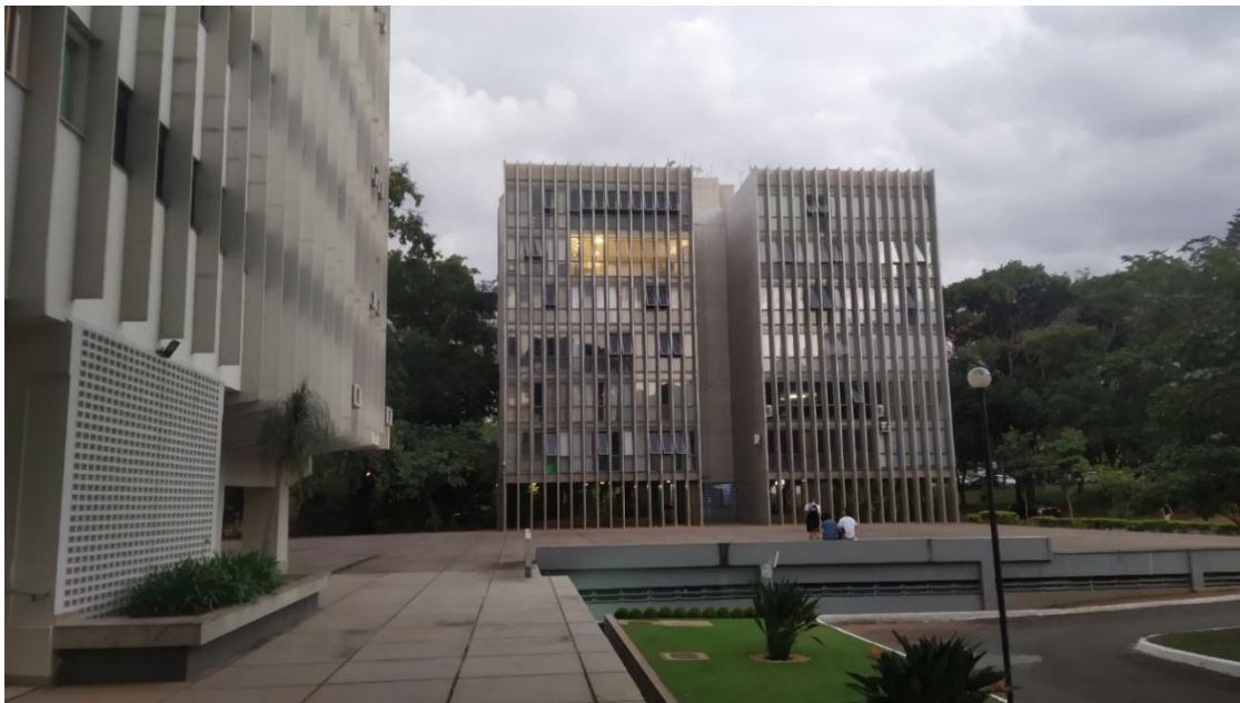
Figura 17 - Fachada sul e entorno imediato, bloco I
