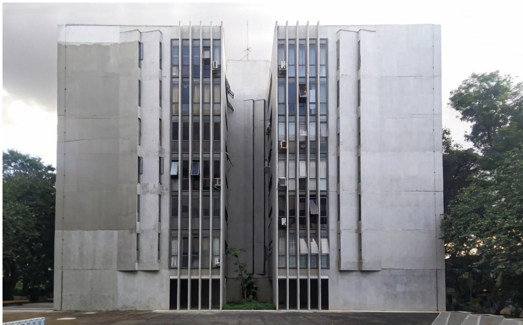
Figura 41 - Bloco G, fachada Leste.
