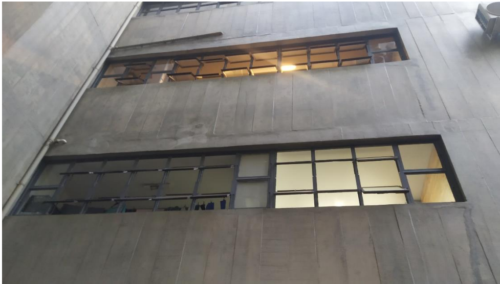
Figura 19 - Janelas basculantes, cozinha e área de serviço.
