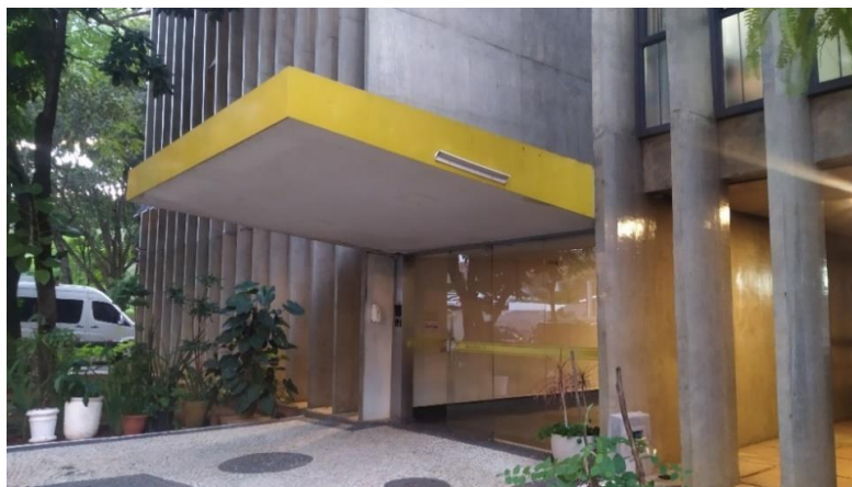
Figura 24 - Portaria, bloco I
