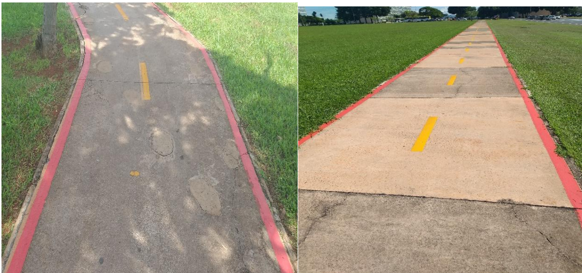
Figura 20 – Exemplo de indícios de intervenções de manutenções realizadas detectados na superfície do pavimento pela alteração de cor e textura: (a) preenchimento para vedação de pequenas aberturas e (b) placas e segmentos de maior porte com restauração completa
