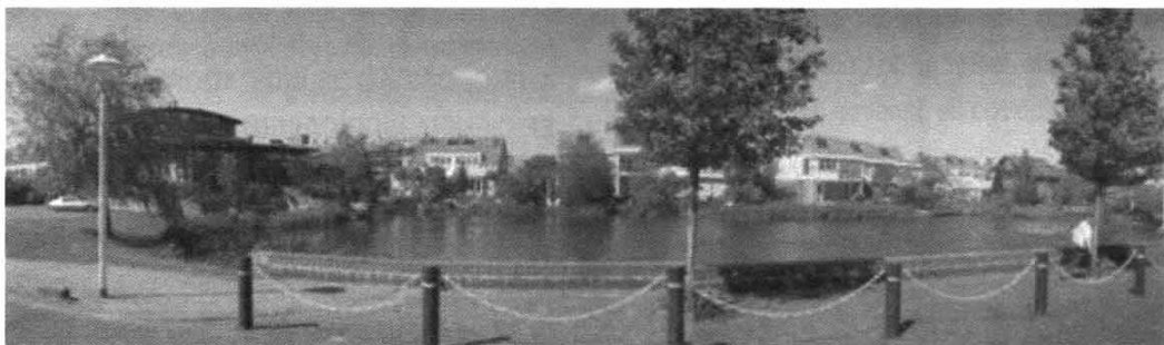
Figura 14 - Lagoa de retenção das águas pluviais – Ecolônia – Holanda (1991-1993) Fonte: Sustainable Community Design, 2007. Disponível em: http://www.arch.umanitoba.ca/vanvliet/sustainable/cases/ecolonia/eoindex.htm . Acesso em: 29/07/2005.
