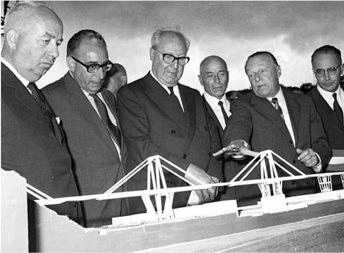
Figura 276- Apresentação da Ponte Morandi às autoridades pelo homônimo engenheiro. Fonte:EMAS, 2019
