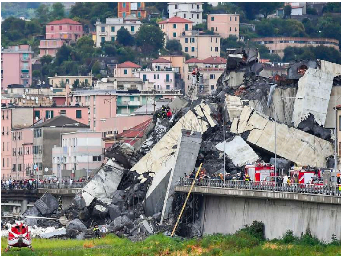
Figura 337 – Restos da infraestrutura colapsada. Fonte: Paolo Rattini/GettyImages
