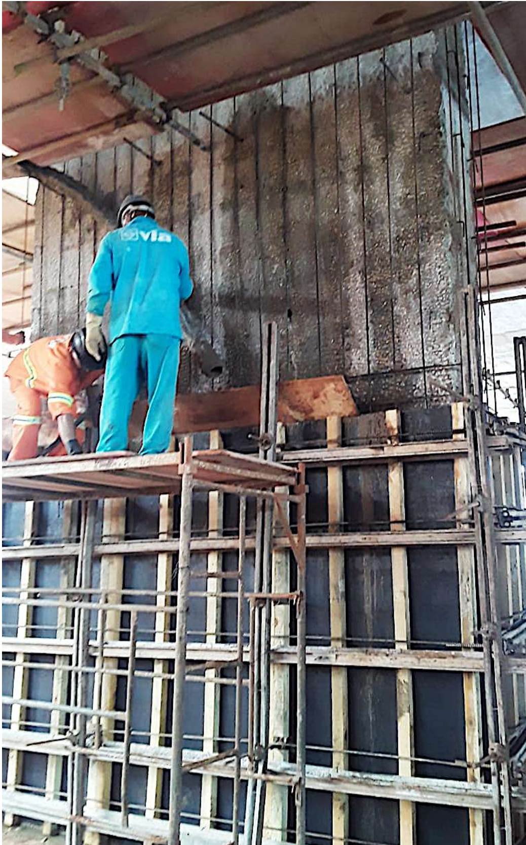
Figura 218– Colocação das formas para lançamento do concreto nos pilares da ponte do Braghetto, Brasília, DF. Fonte: autoral
