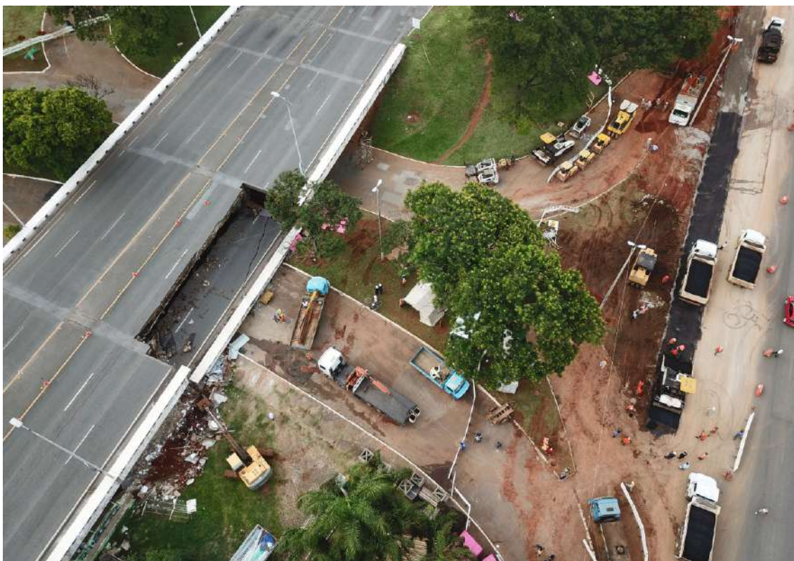
Figura 117 - Local do desabamento do Viaduto sobre a Galeria dos Estados
