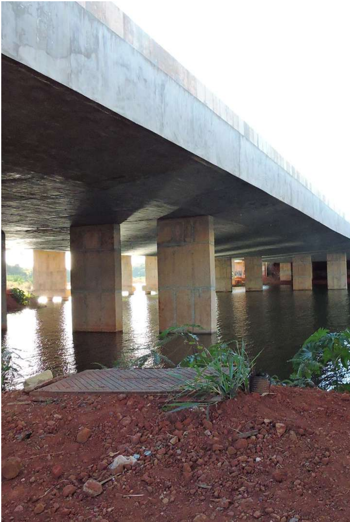
Figura 228 – Galerias laterais da ponte do Braghetto recuperadas, após processo de Retrofit, Fonte: autoral
