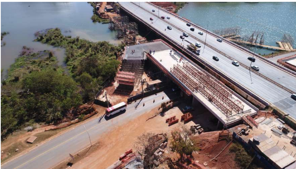
Figura 202 – Construção da OAE 06 do complexo do TTN, Brasília, DF. Fonte: DER/DF, 2018
