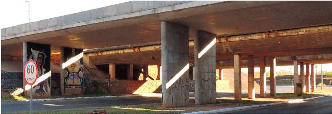
Figura 178 – Pilares novos de seção capsular e pilares existentes, quadrados. Fonte: autoral
