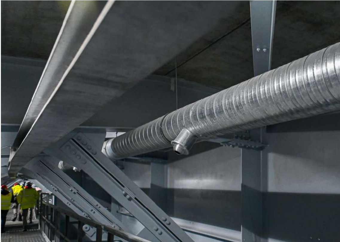
Figura 335 – Sistema de climatização interno da ponte.
