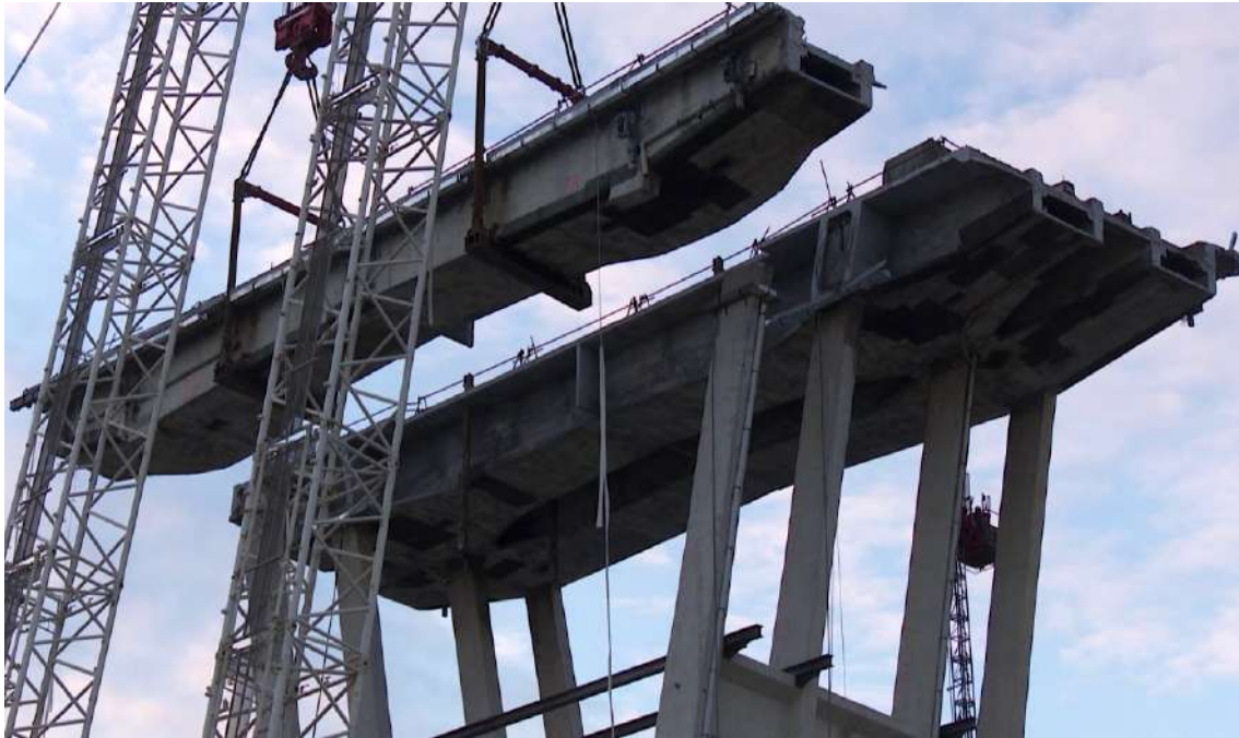
Figura 341 – Içamento e remoção dos trechos pré-moldados.
