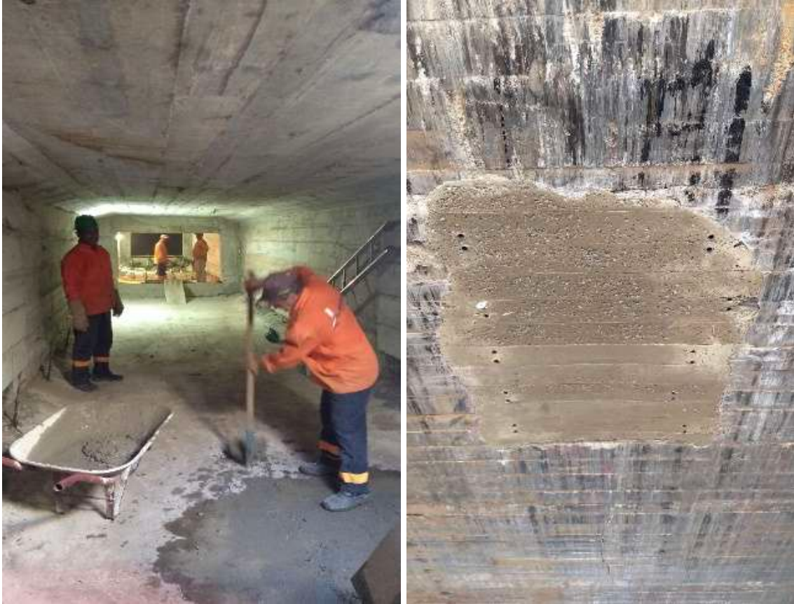
Figura 224 – Recuperação da laje inferior da ponte do Braghetto durante o processo de Retrofit, ambiente interno. Fonte: autoral
