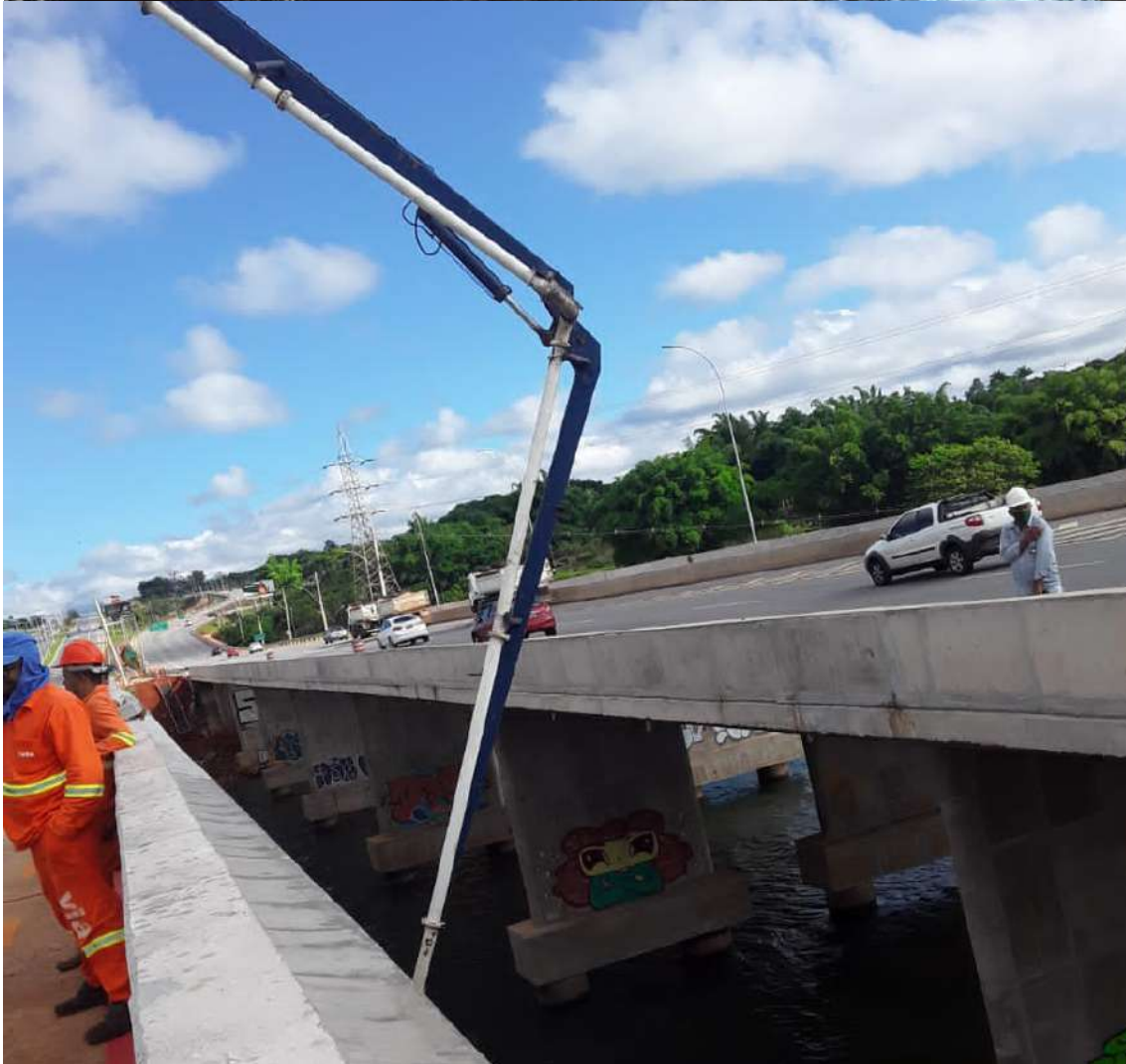
Figura 219 – Lançamento do concreto nos pilares da ponte do Braghetto e vista da OAE 06. Fonte: autoral
