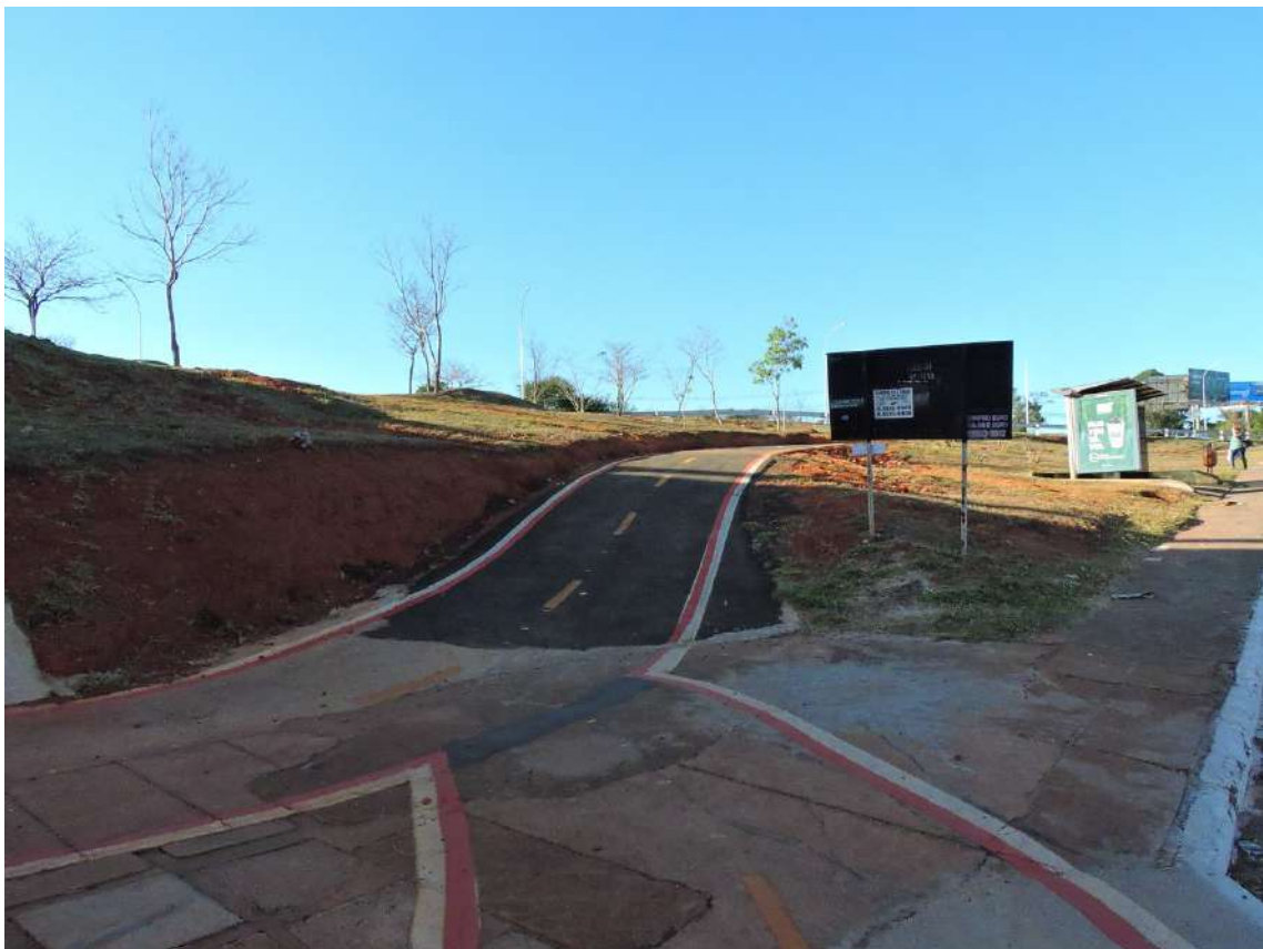
Figura 187 – Vista do trecho de ciclovia que passa pela OAE 02, TTN, Brasília, DF. Fonte: autoral
