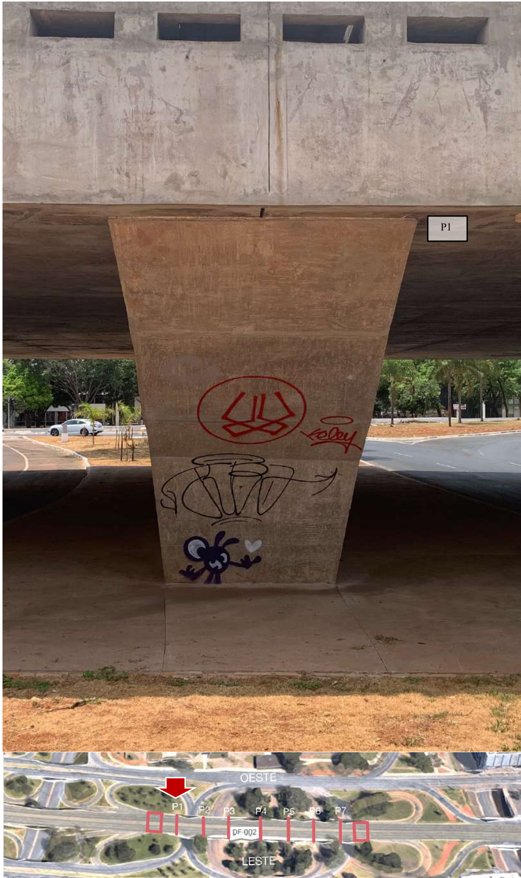
Figura 90 - Pilar 1, Lado Oeste, vista frontal. Fonte: autoral / Adaptado de Google Earth
