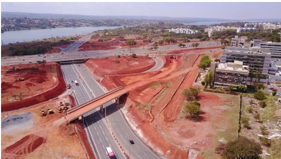
Figura 261 – Vista aérea da construção da OAE 10. Fonte: DER/DF, 2018
