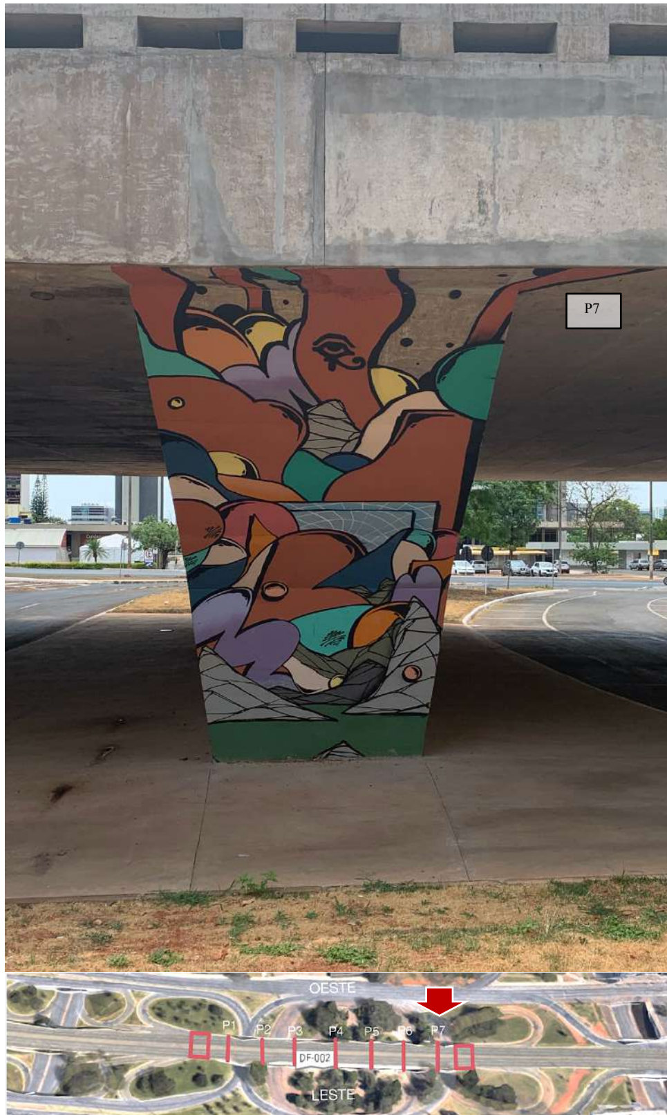
Figura 109 - Pilar 7, Lado Oeste, vista frontal. Fonte: autoral / Adaptado de Google Earth
