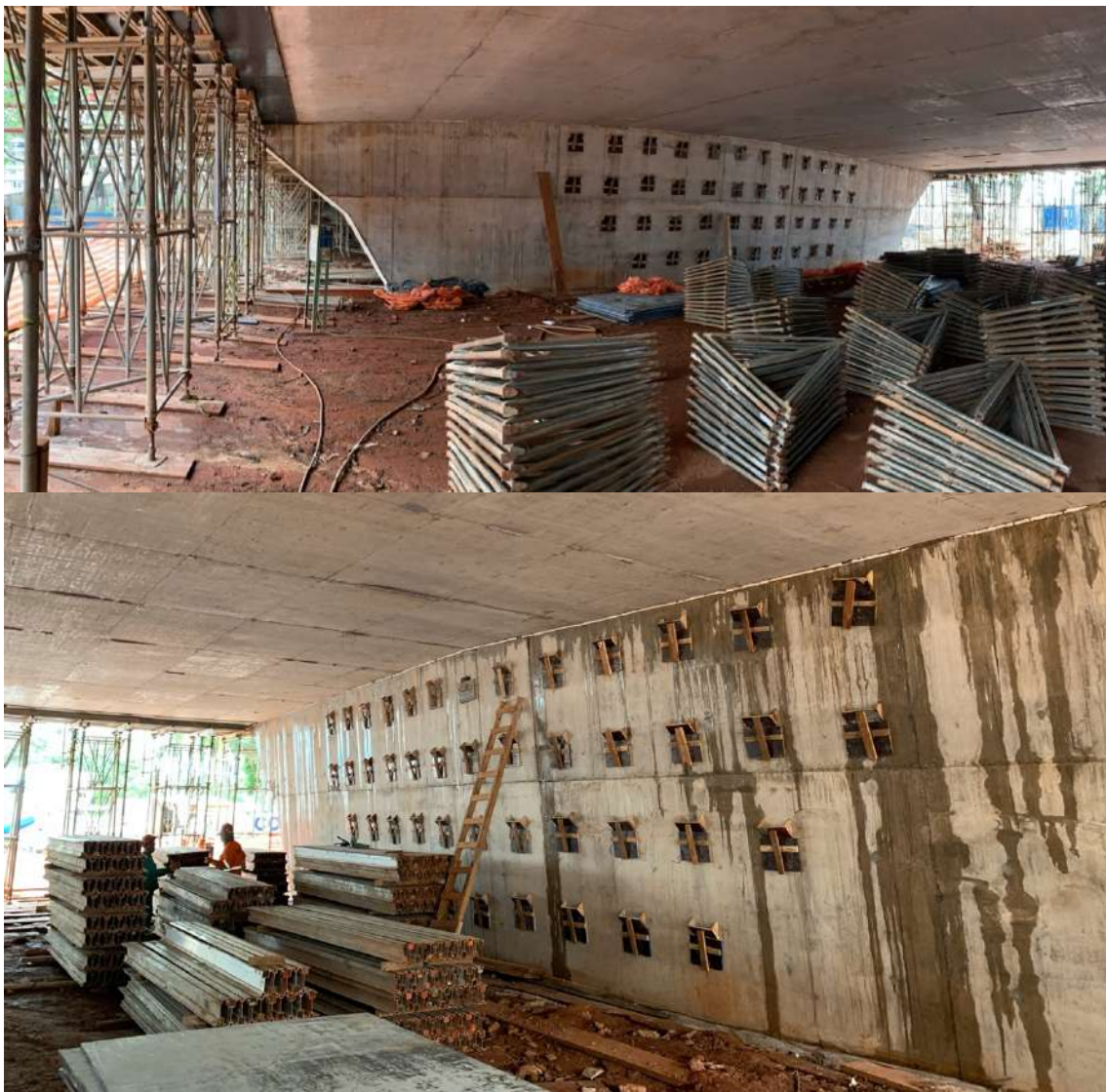
Figura 150 - Vista dos novos pilares engrenados na antiga estrutura existente. Fonte: autoral
