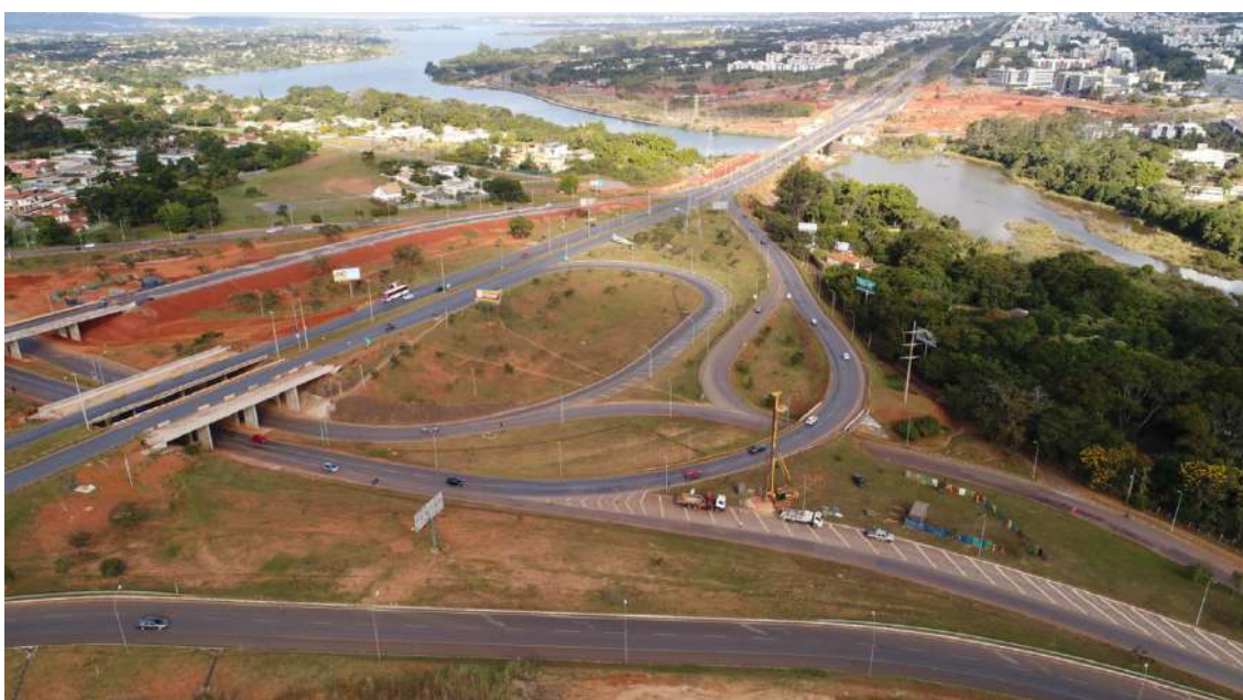
Figura 190 - Implantação das OAE's 03 e 04, mostrando a próxima OAE 02, atrás. Fonte: DER, 2018
