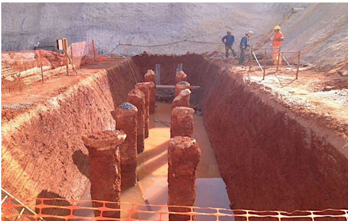
Figura 256 - Estacas com 2,00m para ser arrasada – Nível d'água aflorante. Ao fundo, mangote da bomba para secar a vala do bloco, OAE 09L, TTN, Brasília, DF. Fonte: DER/DF, 2018
