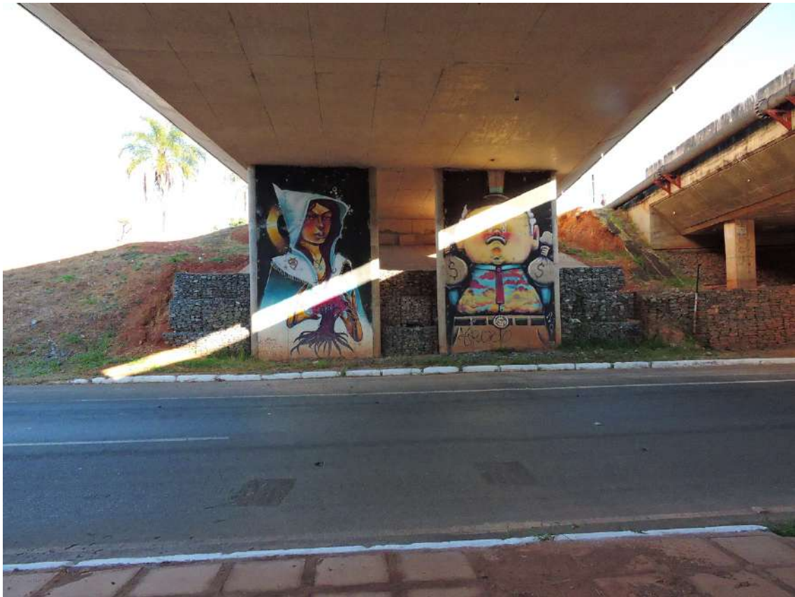
Figura 181 - Pilares novos, seção transversal capsular, OAE 1, TTN, Brasília, DF. Fonte: autoral
