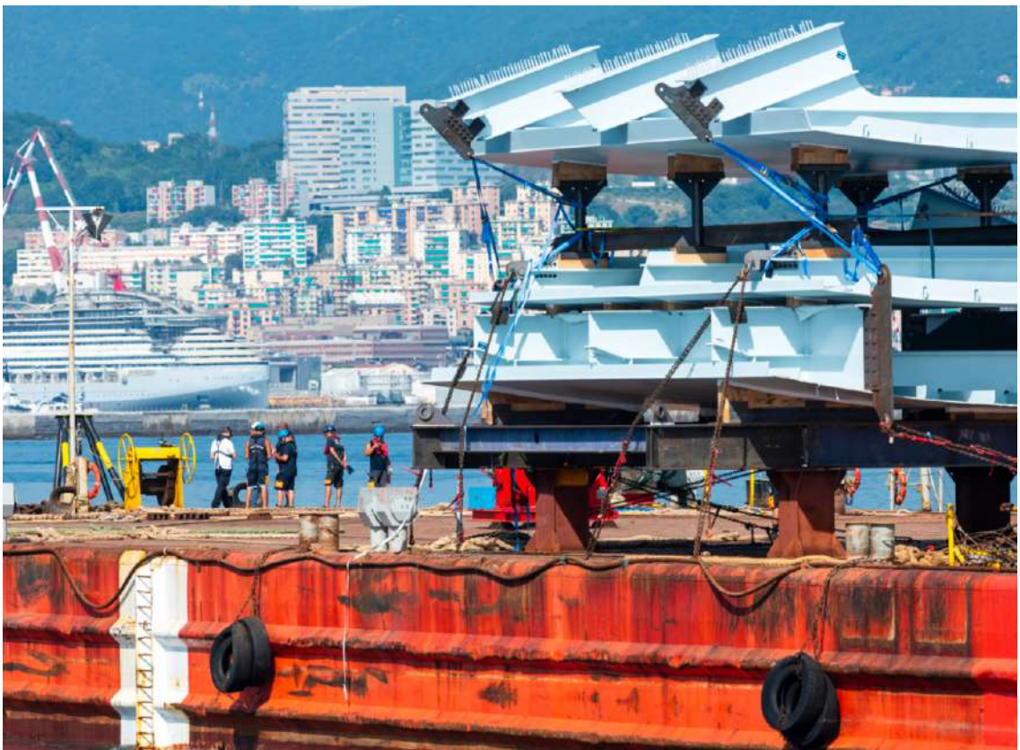
Figura 320 – Fase de transporte marítimo. Fonte: We Build
