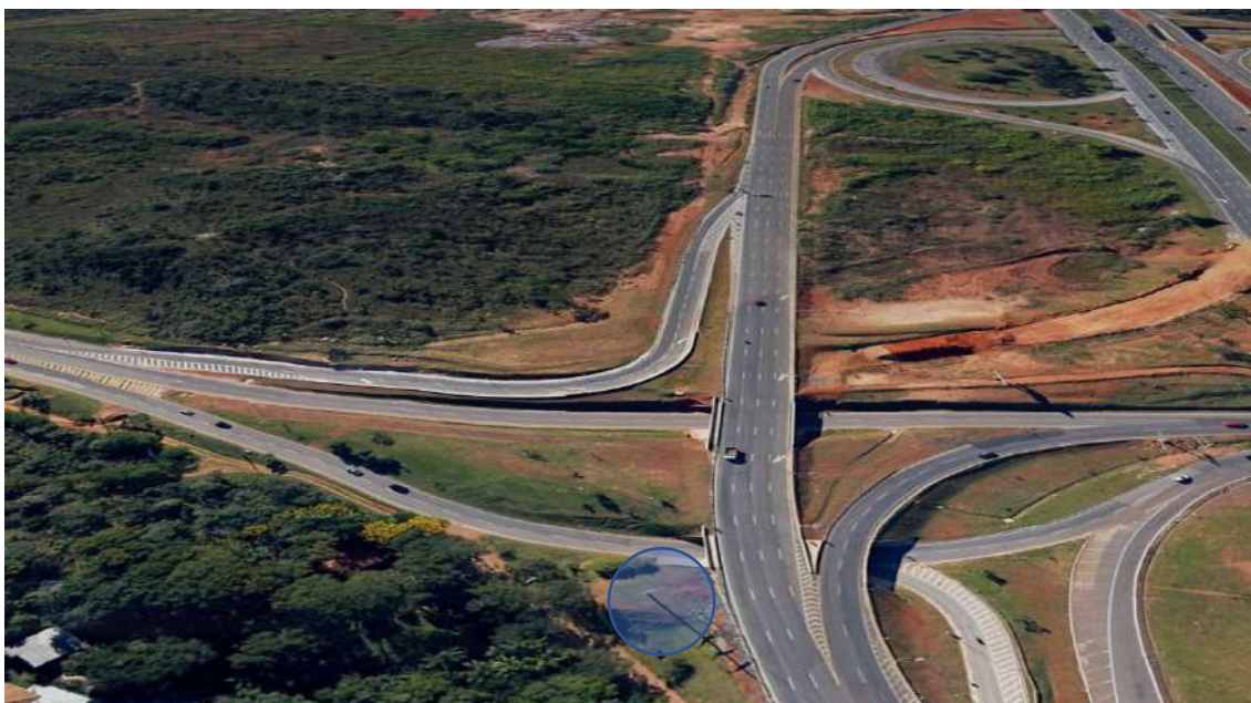
Figura 196 - OAE 05A, localização da interferência com a torre de alta tensão da CEB, Brasília, DF. Fonte: Google Earth
