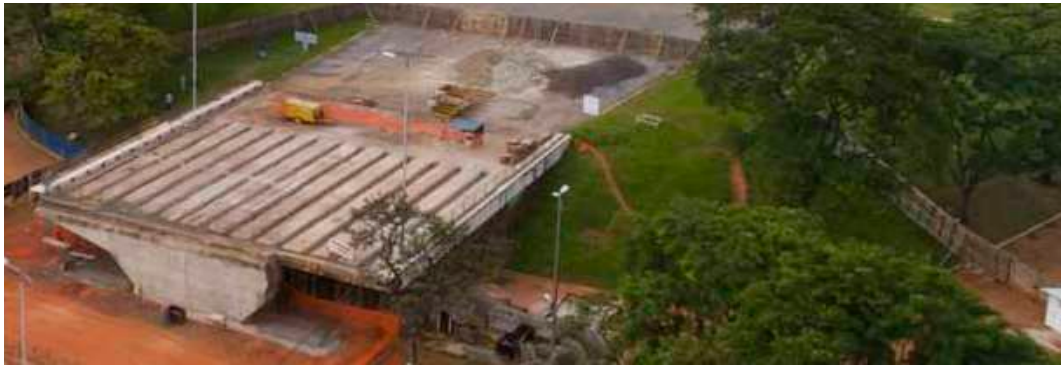
Figura 147 - Demolição da laje 7.
