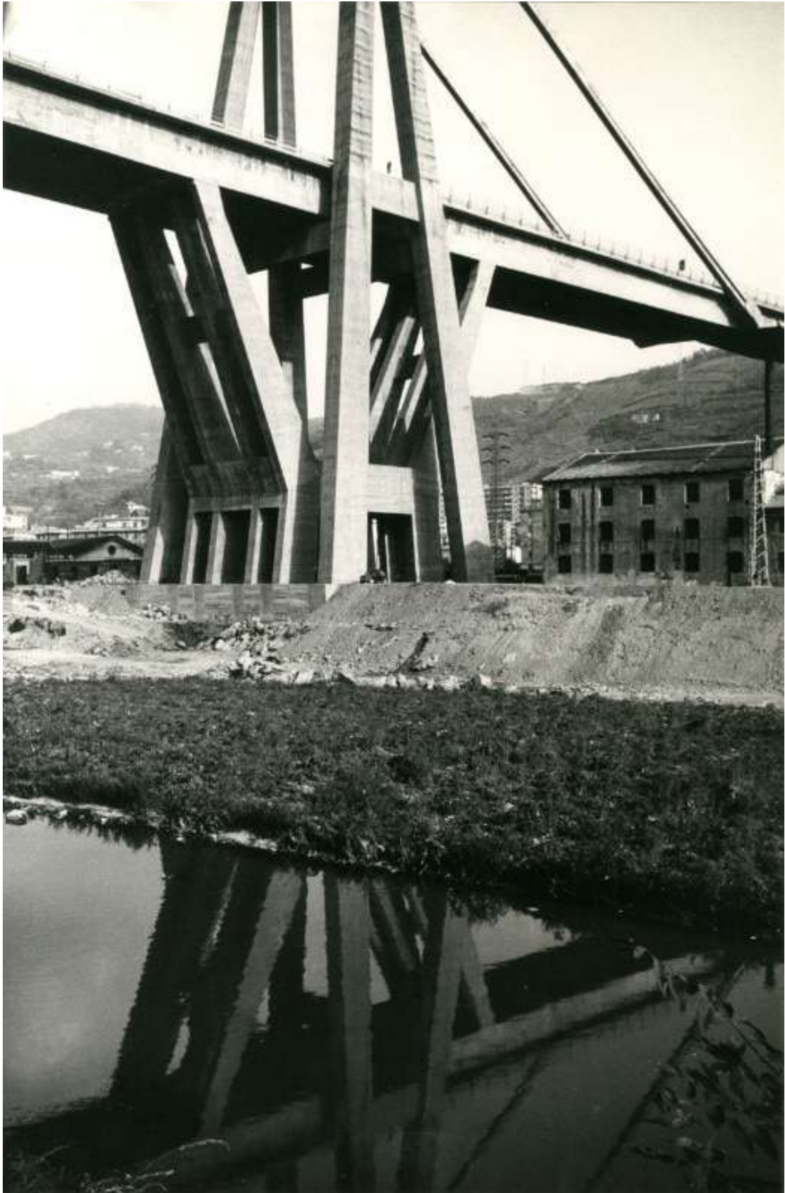
Figura 282 – Vista debaixo da Ponte. Fonte: Arno Hammacher
