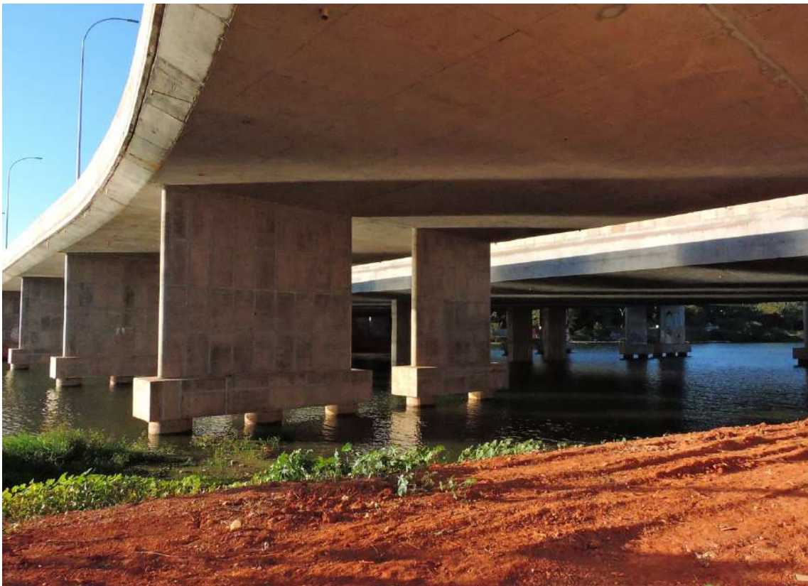
Figura 237 – Vista da laje inferior e dos pilares da OAE 07, complexo do TTN, Brasília, DF. Fonte: autoral
