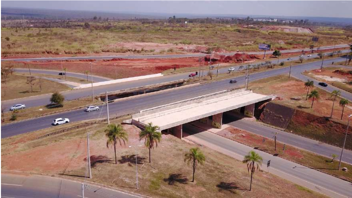
Figura 175 – Implantação da OAE 01, adjacente à dois viadutos existentes, Trevo de Triagem Norte, Brasília, DF. Fonte: DER/DF, 2018
