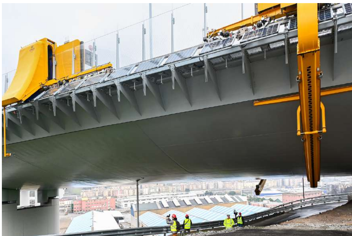
Figura 330 – Sistema fotovoltaico. Fonte: C.R.G.
