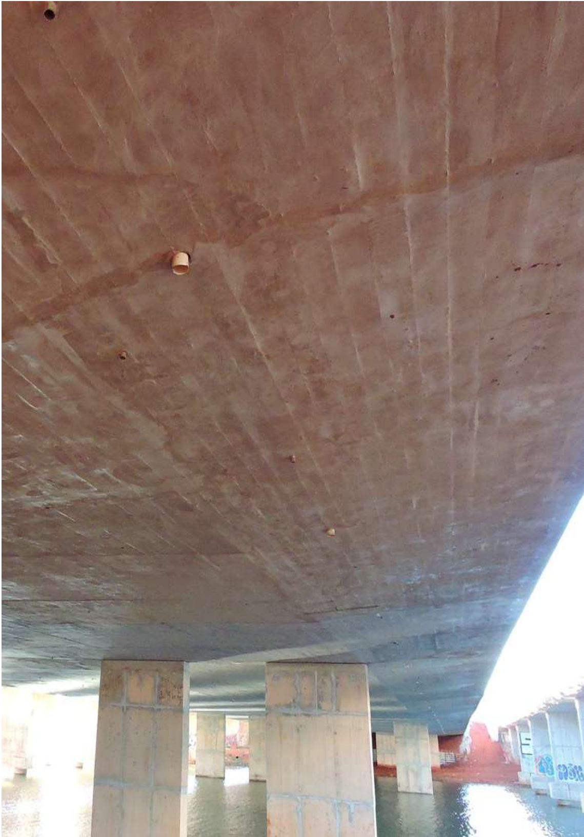
Figura 226 – Laje inferior recuperada e pilares reforçados, após processo de Retrofit, Fonte: autoral
