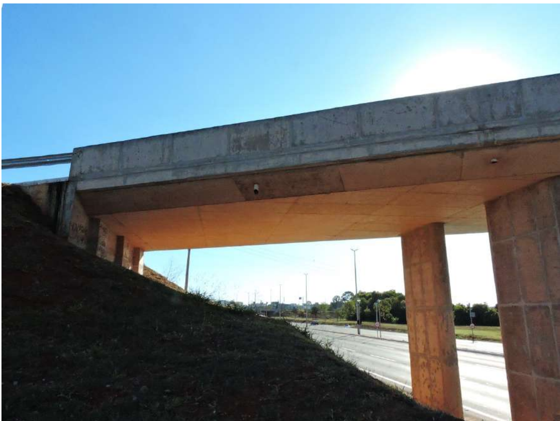
Figura 246 – Detalhe mostrando os buzinotes de escoamento / drenagem das águas pluviais, OAE 08, TTN, Brasília, DF. Fonte: DER/DF, 2018
