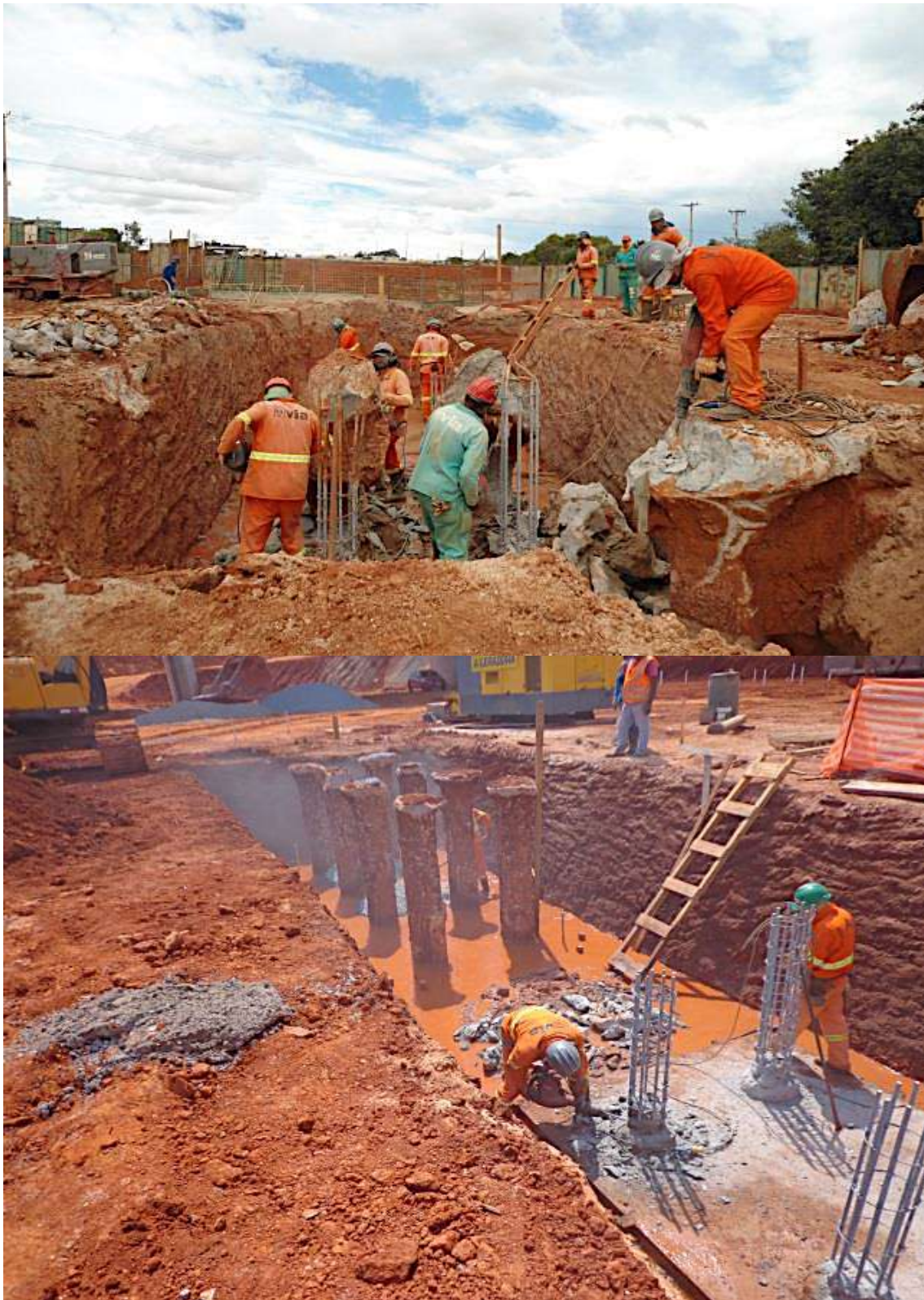
Figura 259 - Estacas com 2,00m para ser arrasada – Nível d'água aflorante. Ao fundo, mangote da bomba para secar a vala do bloco, OAE 09C, TTN, Brasília, DF. Fonte: DER/DF, 2018
