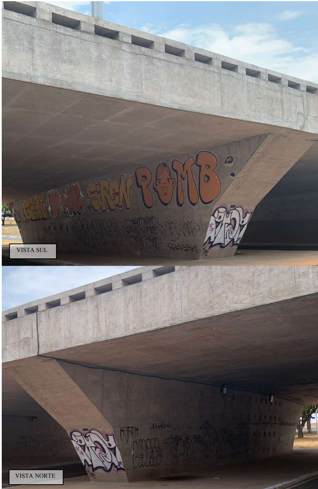
Figura 108 - Pilar 7, vistas sul e norte. Fonte: autoral
