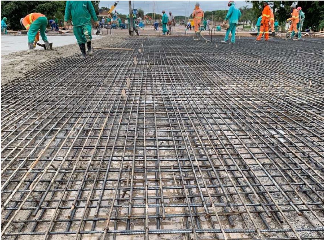
Figura 157 - Armaduras passivas pré-moldadas e bainhas para protensão das longarinas de concreto. Fonte autoral
