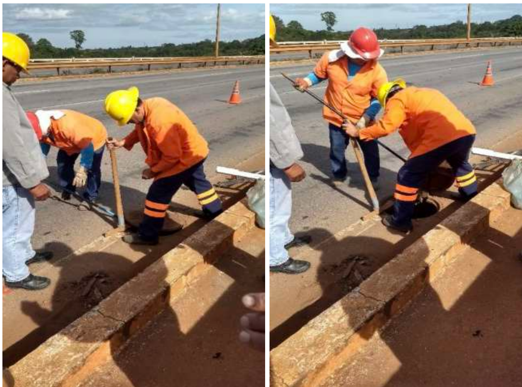
Figura 229 – Operários atuando na desobstrução dos drenos e buzinetes de águas pluviais. Fonte: DER/DF
