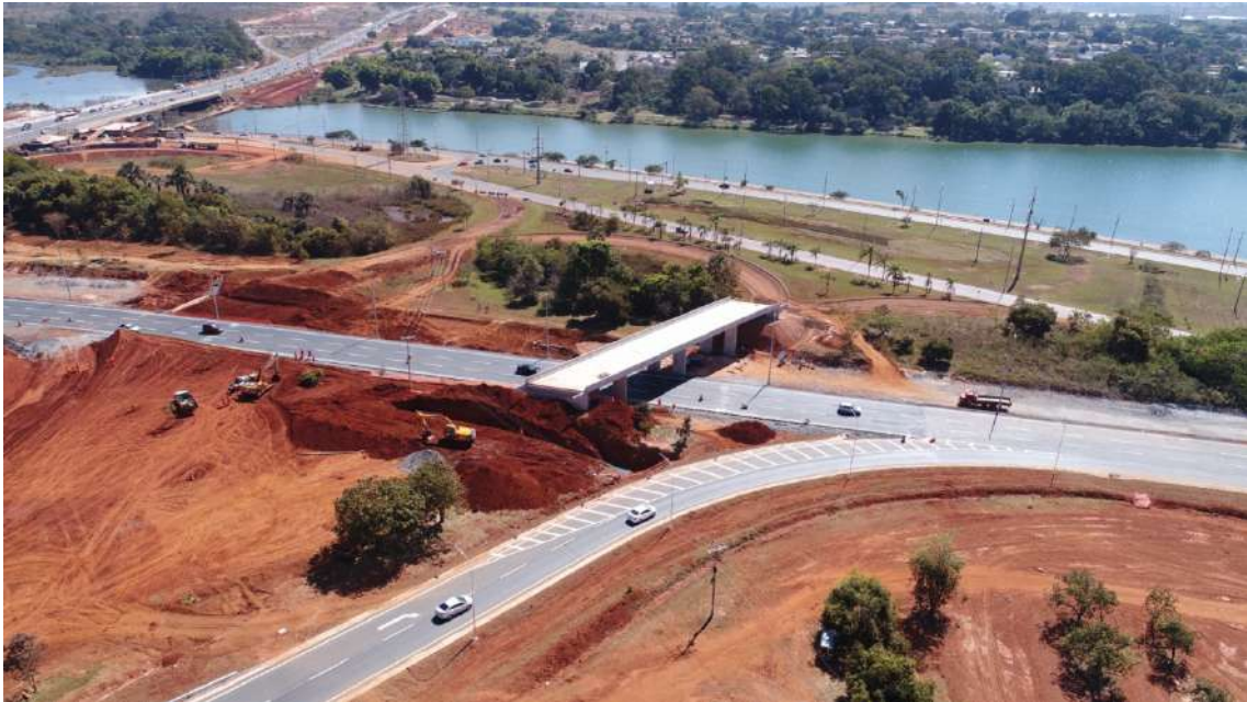
Figura 245 – Vista aérea da construção da OAE 08. Fonte: DER/DF, 2018
