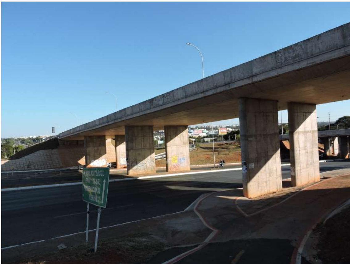
Figura 185 – Vista leste da OAE 02, TTN, Brasília, DF. Fonte: autoral
