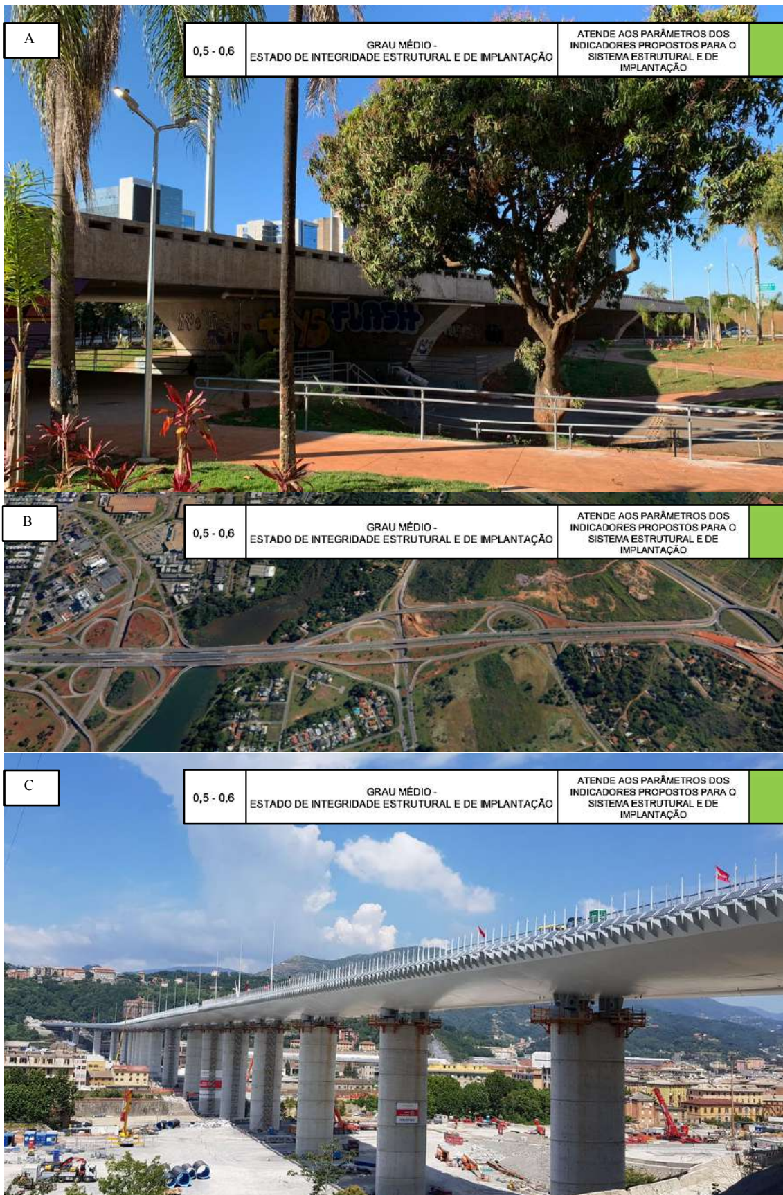
Figura 352 – A. Viaduto sobre a galeria dos Estados. B. Trevo de Triagem Norte. C. Ponte San Giorgio. Fonte: autoral, adaptada de Google earth e FSNews
