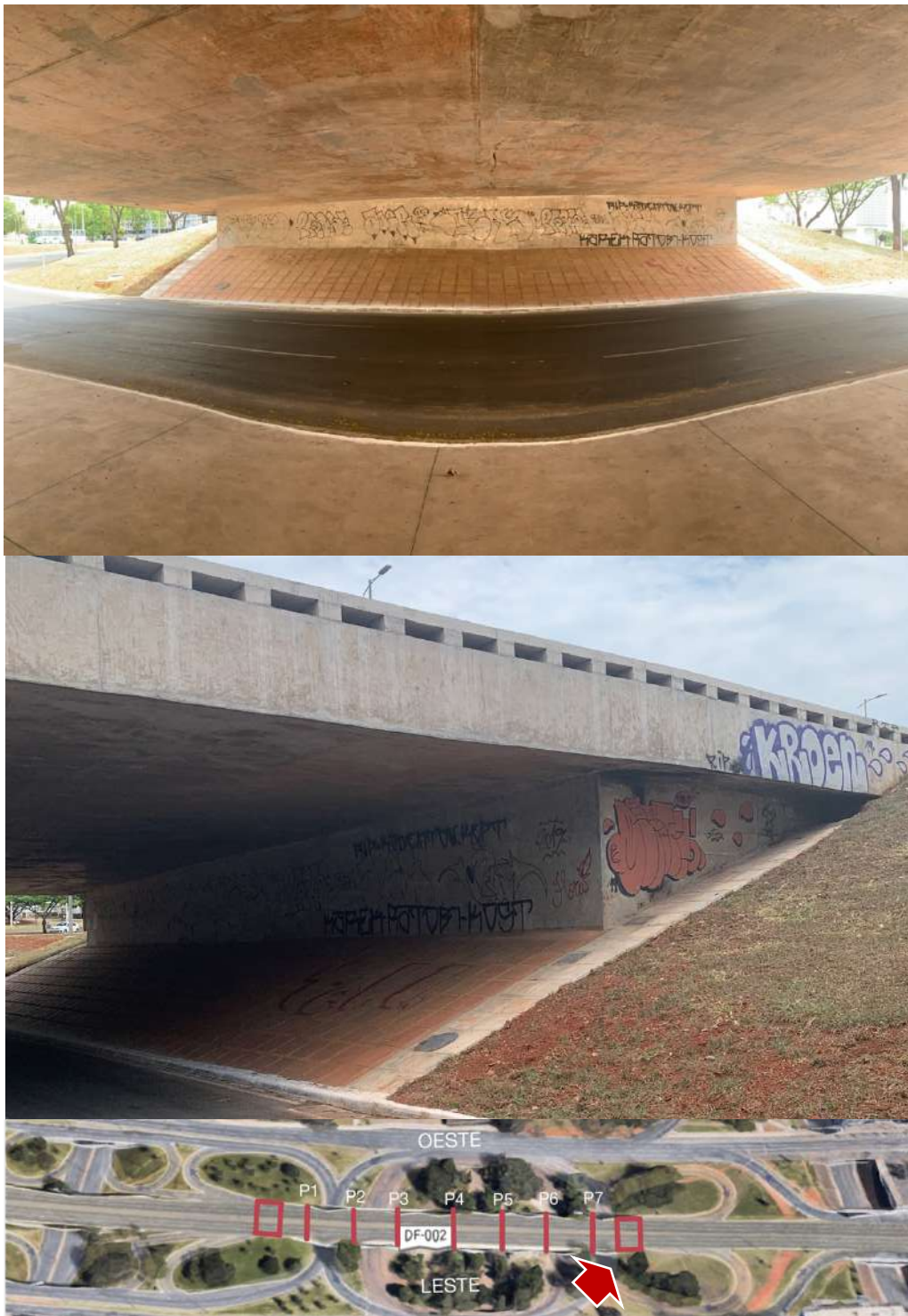
Figura 110 - Cortina de contenção norte. Fonte: autoral / Adaptado de Google Earth
