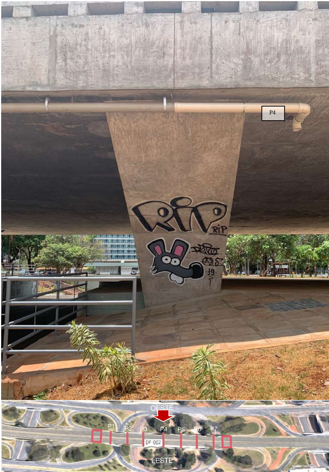
Figura 99 - Pilar 4, Lado Oeste, vista frontal. Fonte: autoral / Adaptado de Google Earth
