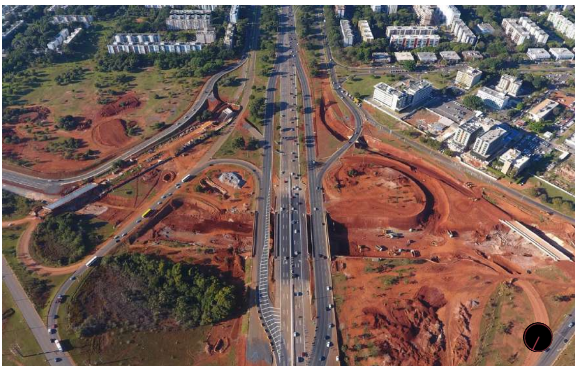
Figura 165 Vista aérea do trecho norte do Trevo de Triagem Norte em fase de obra. Fonte: Gabriel Jabur
