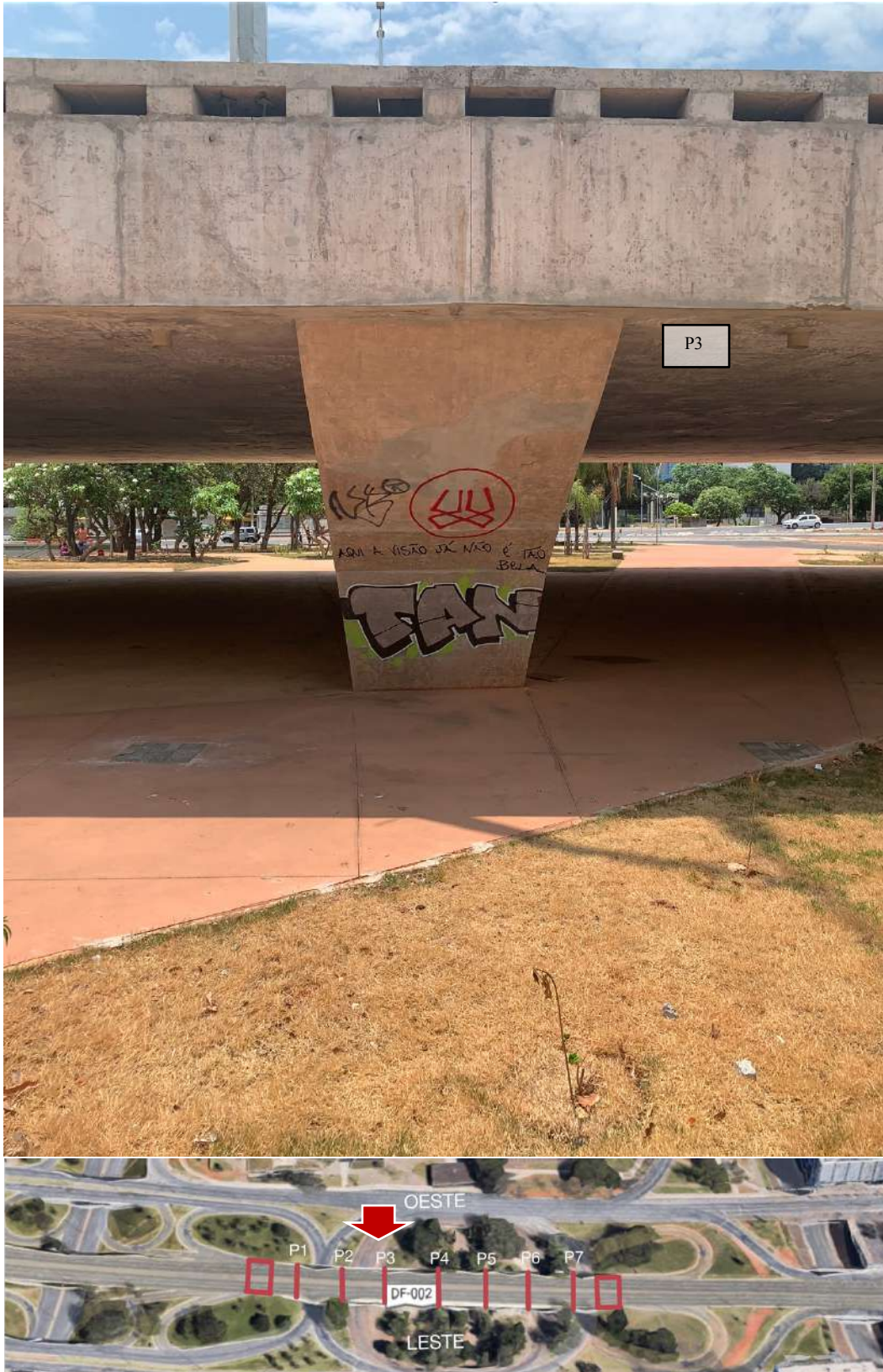
Figura 96 - Pilar 3, Lado Oeste, vista frontal. Fonte: autoral / Adaptado de Google Earth
