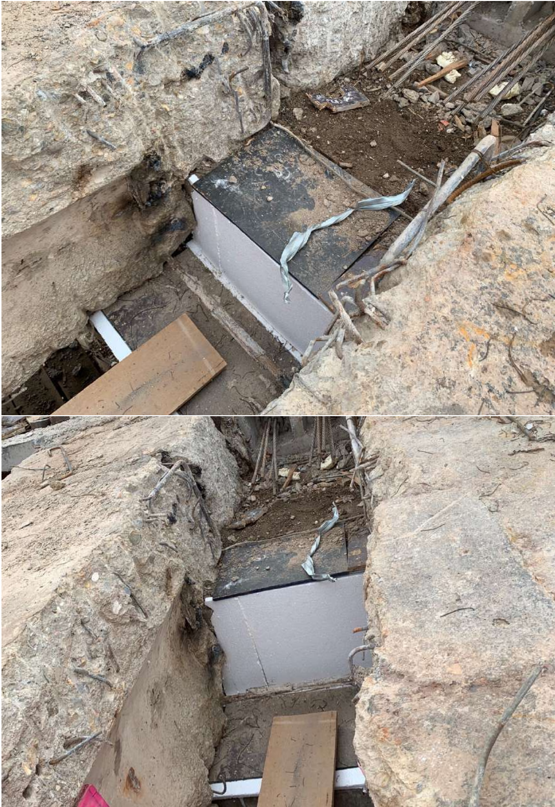
Figura 155 - Apoio das novas vigas protendidas sobre os pilares em asa delta. Fonte: autoral
