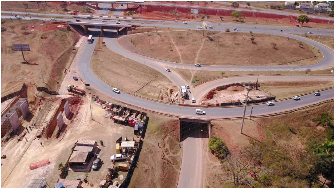
Figura 193 – Canteiro de obra da OAE 05, TTN, Brasília, DF. Fonte: DER, 2018
