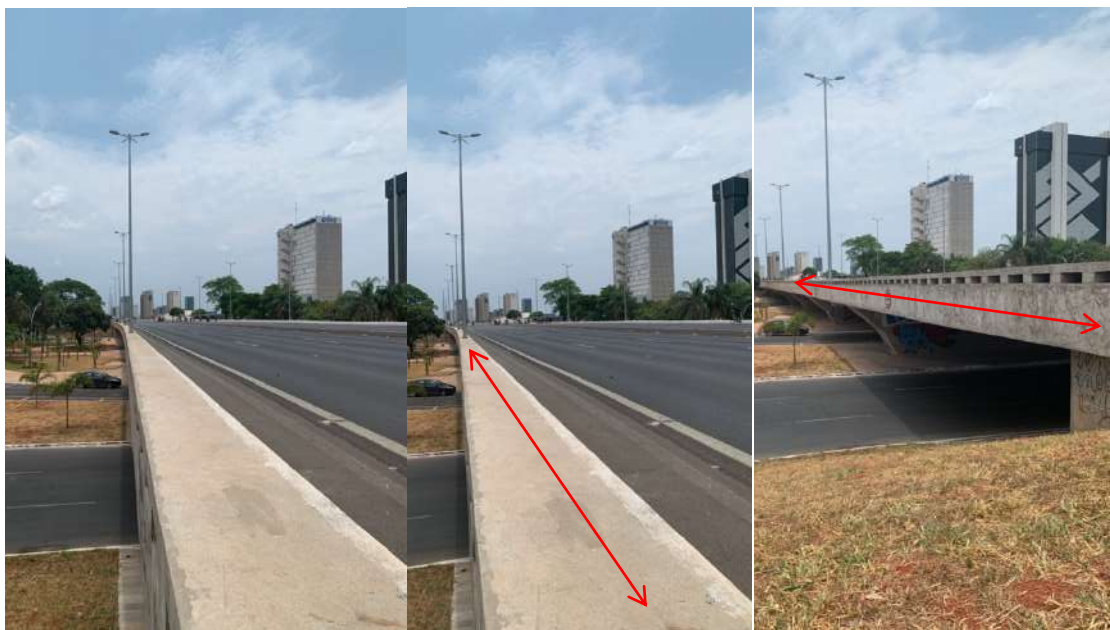
Figura 141 - Vista das galerias de águas pluviais. Fonte: autoral
