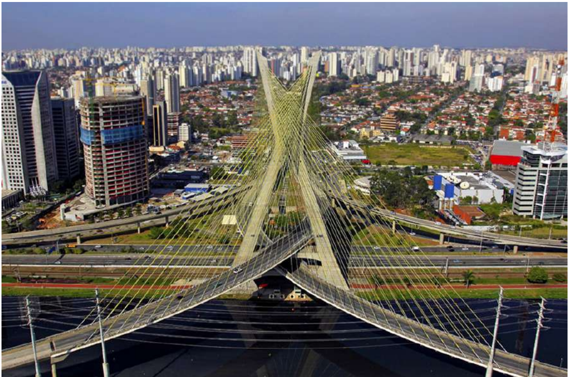
Figura 38 - Ponte Estaiada em “harpa” Octávio Frias de Oliveira sobre o Rio Pinheiros em São Paulo, SP. Fonte: Encontra Brooklin
