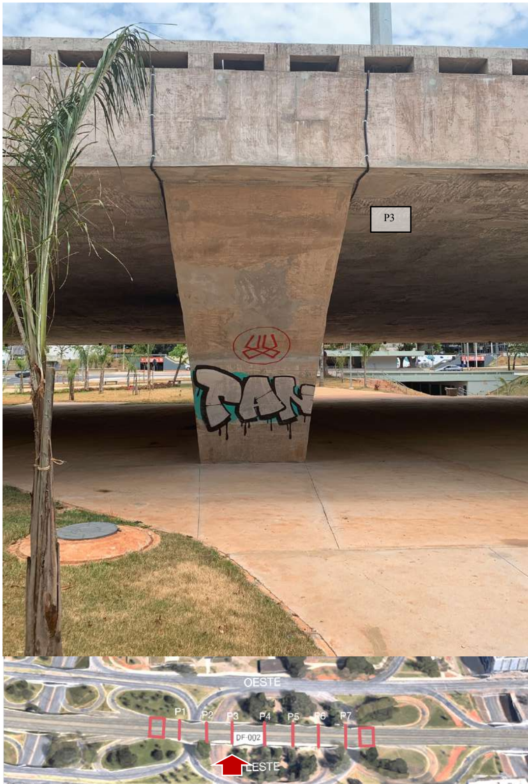
Figura 94 - Pilar 3, Lado Leste, vista frontal. Fonte: autoral / Adaptado de Google Earth
