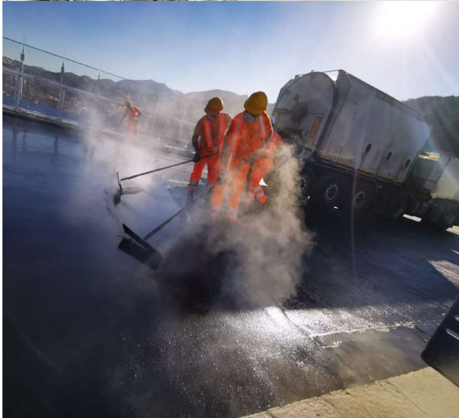
Figura 328 – A. Concretagem do tabuleiro. B. Acabamento final da pista. Fonte: Commissario Ricostruzione Genova
