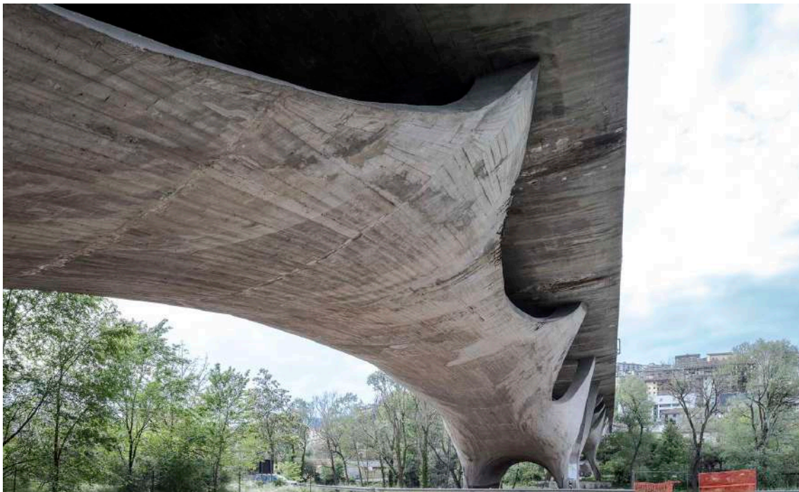
Figura 69 – Apoios de superfície cilíndrica da Ponte Musmeci sobre o rio Basento, Potenza, Itália. Fonte: adaptada de MIBAG, 2018
