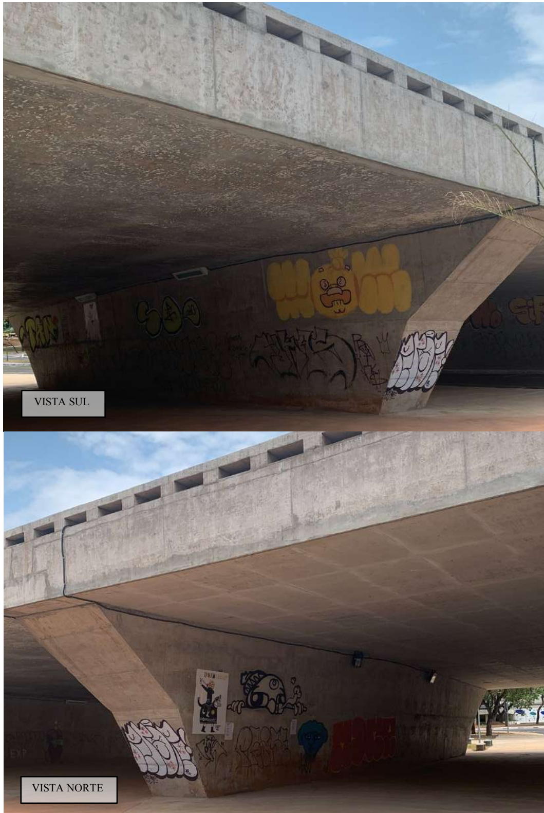
Figura 105 - Pilar 6, vistas sul e norte. Fonte: autoral
