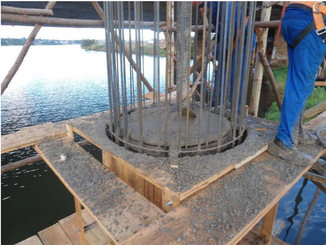
Figura 239 – Fundação da ponte 07, TTN, Brasília, DF. Fonte: autoral
