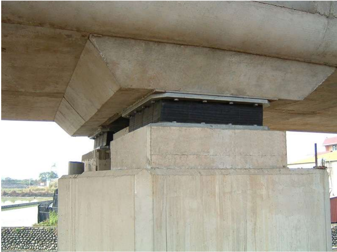
Figura 75 – Apoio em material elastômero, neoprene. Fonte: Diprotec
