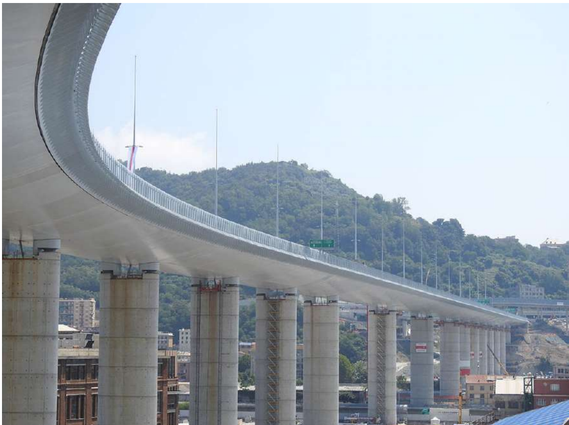
Figura 310 – Vista dos pilares da Ponte San Giorgio, Génova. Fonte: Shunji Ishida
