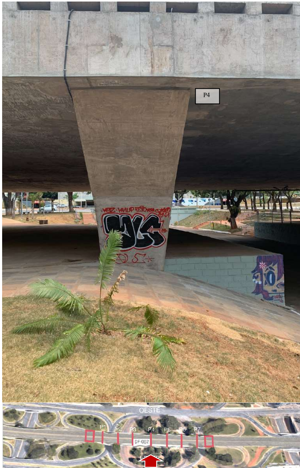
Figura 97 - Pilar 4, Lado Leste, vista frontal. Fonte: autoral / Adaptado de Google Earth
