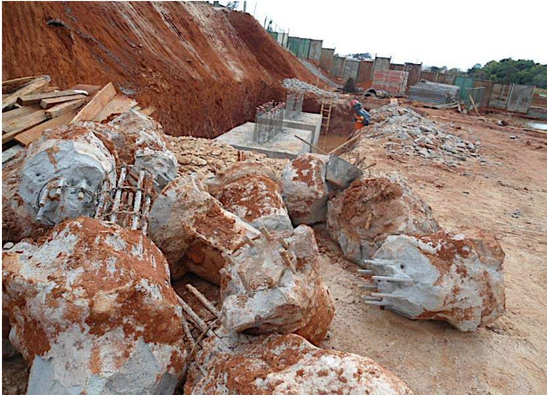
Figura 257 - Estacas da OAE 09L, TTN, Brasília, DF. Fonte: DER/DF, 2018
