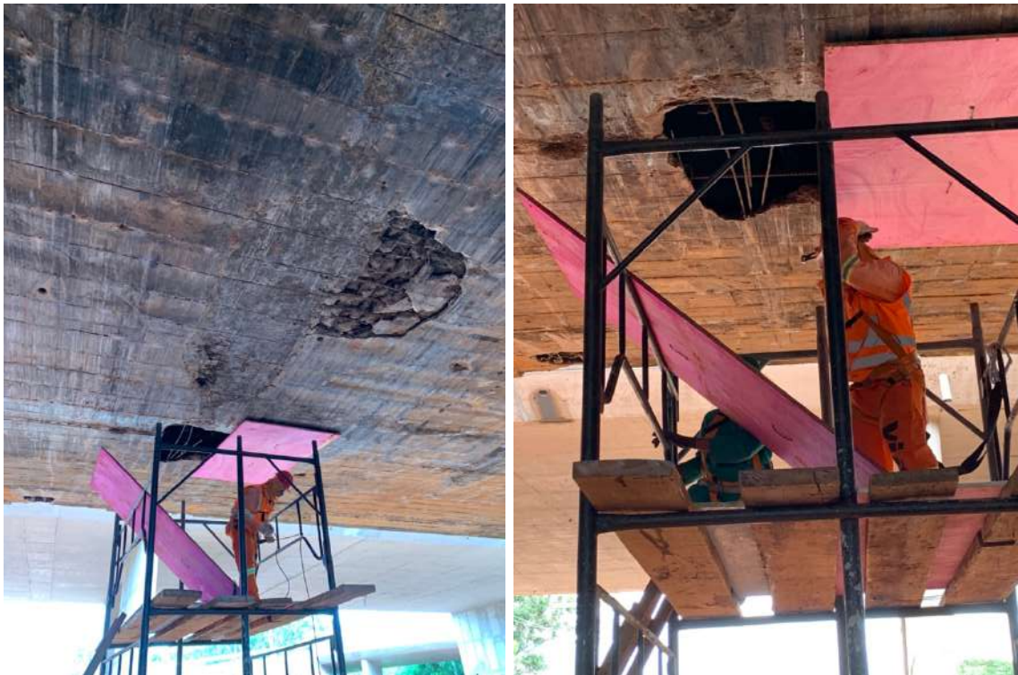
Figura 223 – Recuperação da laje inferior da ponte do Braghetto durante o processo de Retrofit, ambiente externo. Fonte: autoral
