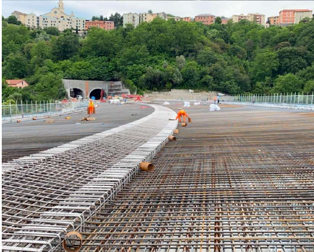
Figura 327 – Concretagem do tabuleiro. Fonte: Shunji Ishida
