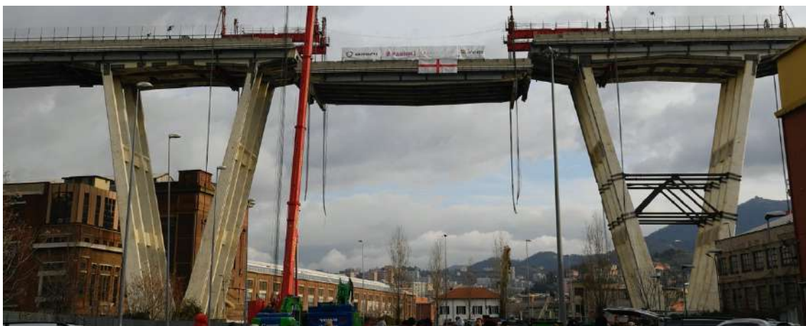
Figura 278 – Pilares em formato “V”, antiga Ponte Morandi.
