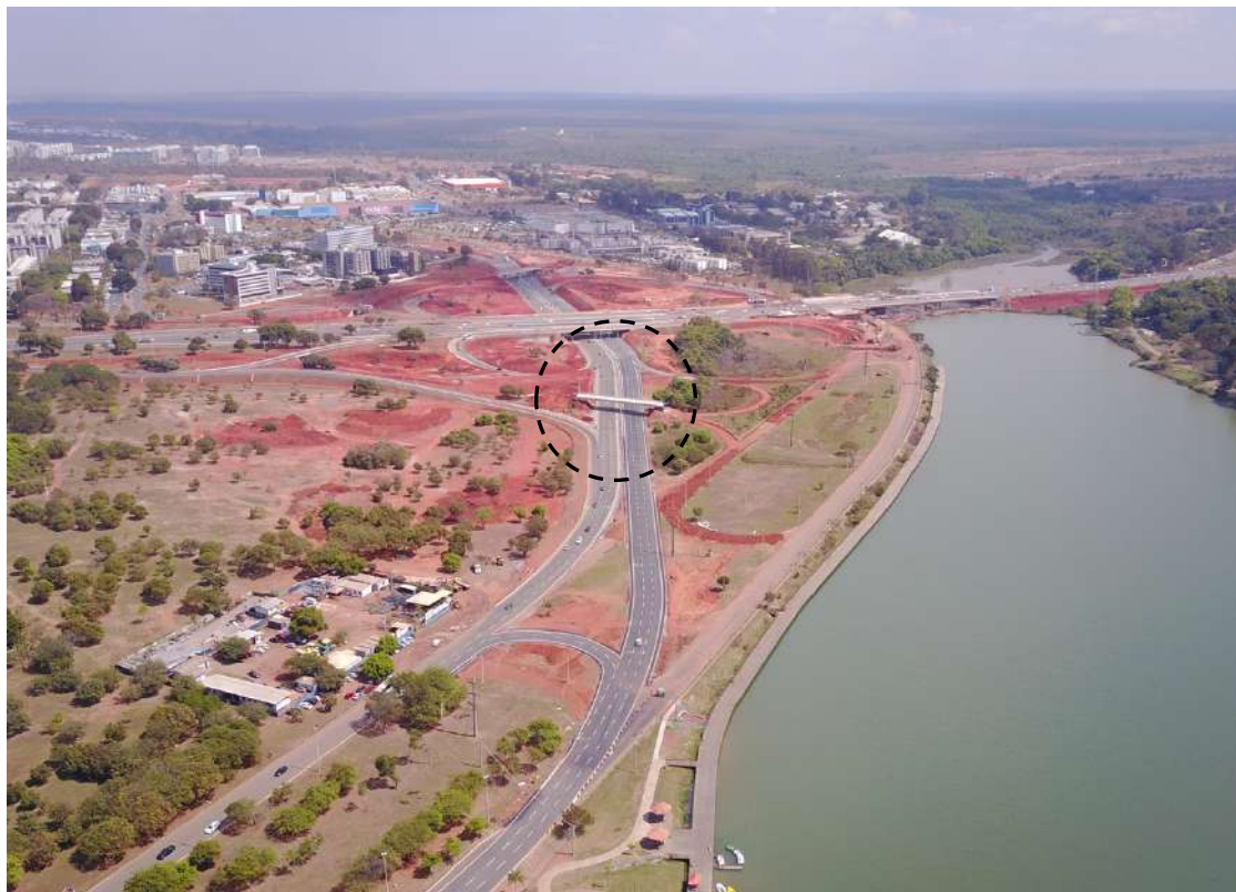
Figura 244 – Vista aérea da construção da área sul do complexo do TTN e da OAE 08. Fonte: DER/DF, 2018
