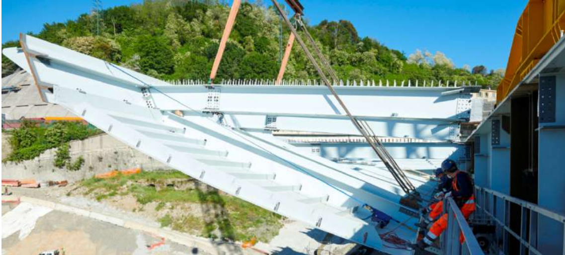
Figura 319 – Estrutura metálica lateral, alças ou remos laterais. Fonte: We Build
