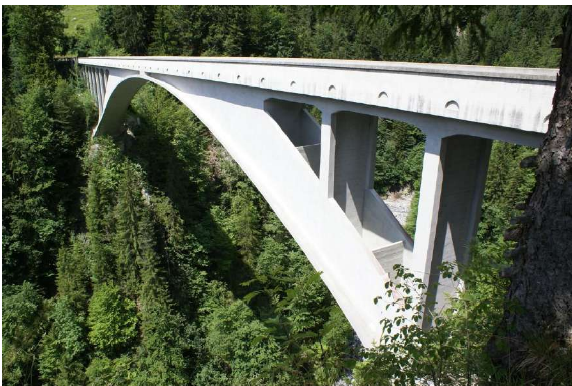
Figura 33 - Ponte em arco triarticulado Salginatobel, Suíça. Fonte: Nicolas Janberg
