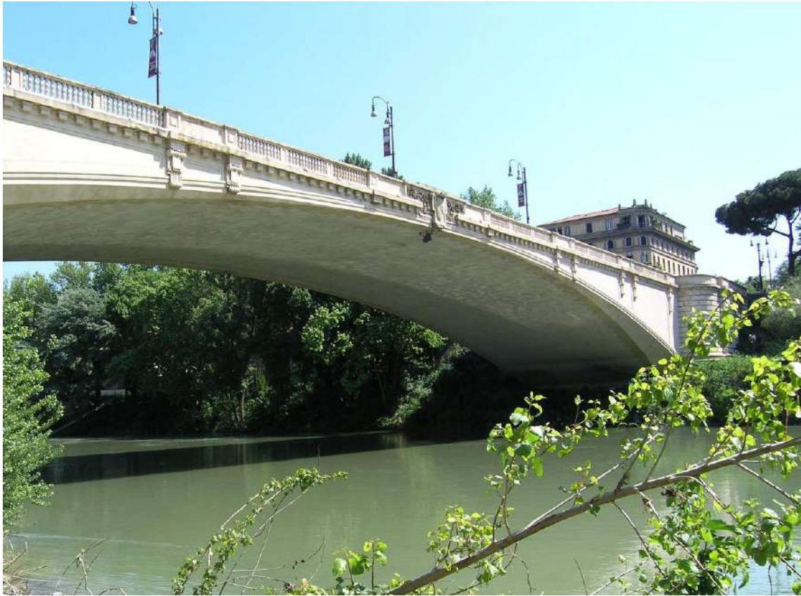
Figura 31 – Ponte do Ressurgimento, Roma, Itália. Fonte: Nicolas Janberg
