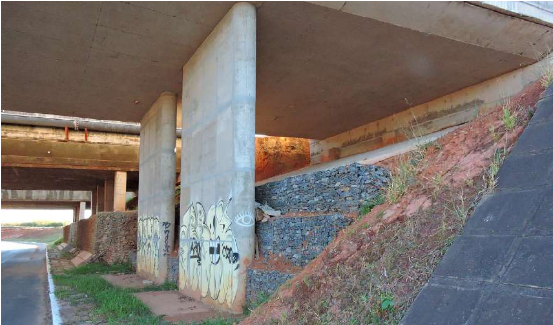
Figura 179 – Contenção em muro de gabião, OAE 01, TTN, Brasília, DF. Fonte: autoral
