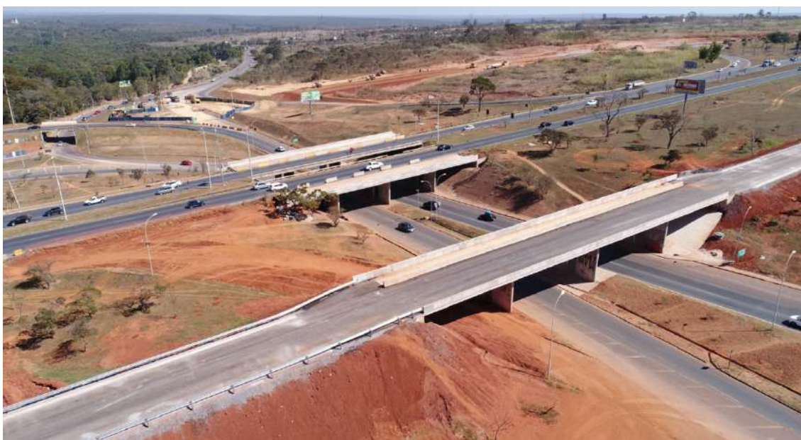
Figura 184 - Implantação da OAE 02, mostrando as OAE's 3 e 4, atrás. Fonte: DER, 2018
