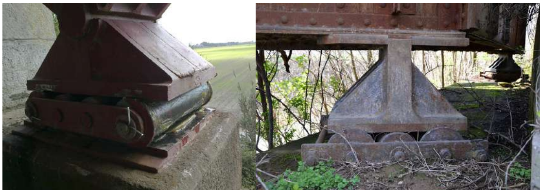
Figura 73 - Apoio para rolamento em rolo múltiplo. Ponte Rainha D. Amélia.
