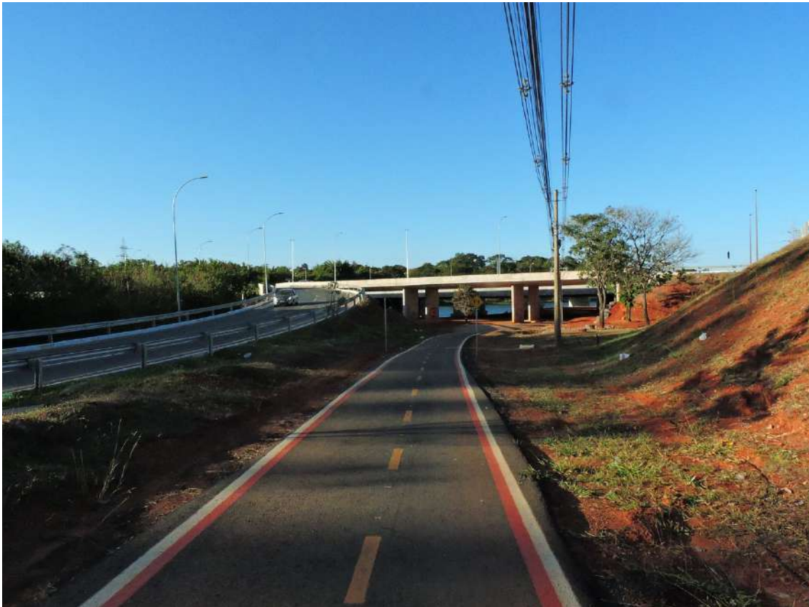
Figura 235 – Vista da ponte 07, complexo do TTN, Brasília, DF. Fonte: autoral
