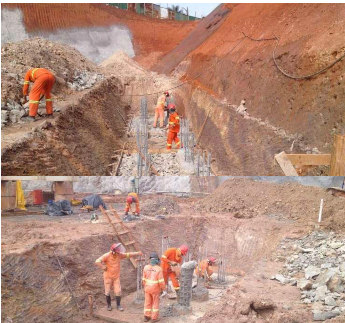
Figura 263 - Fundação com estacas raiz.
