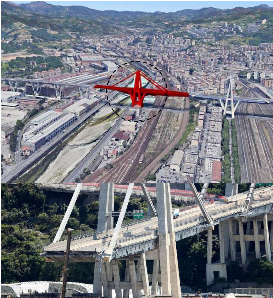
Figura 336 - Trecho do viaduto colapsado. Fonte: Adaptada de ITALFERR e The Guardian.
