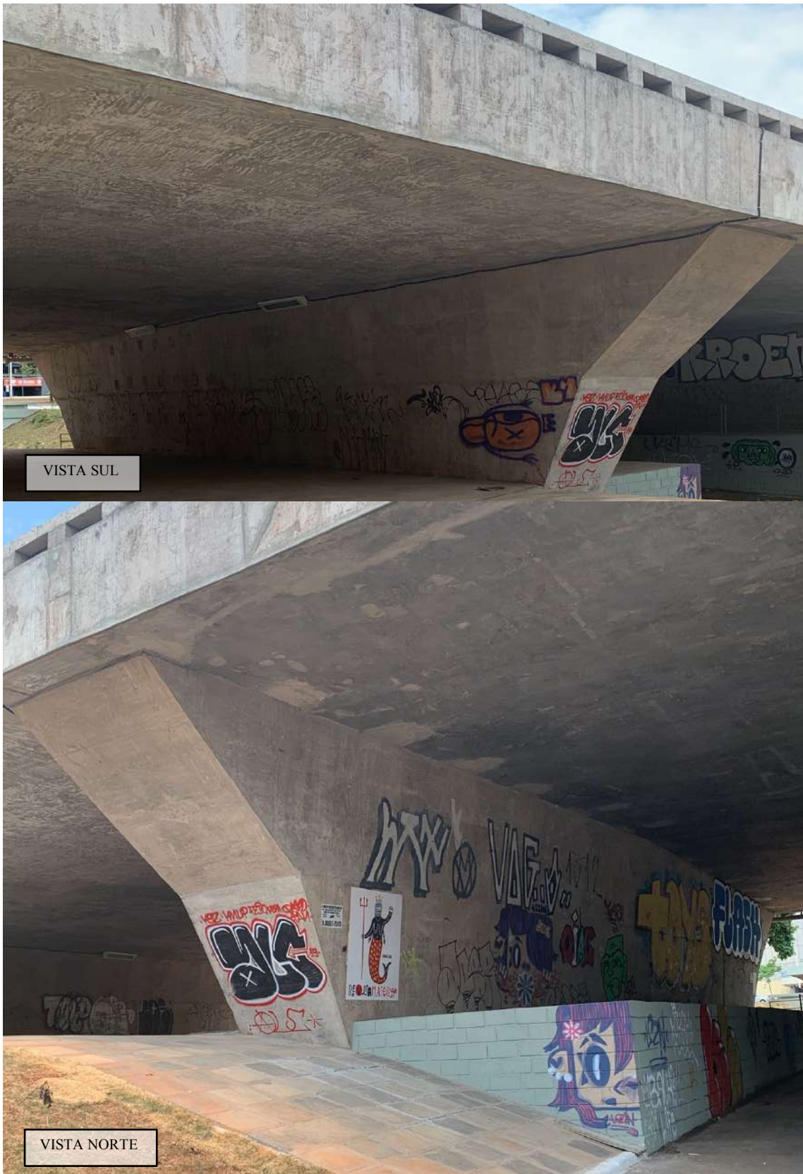
Figura 98 - Pilar4, vistas sul e norte. Fonte: autoral
