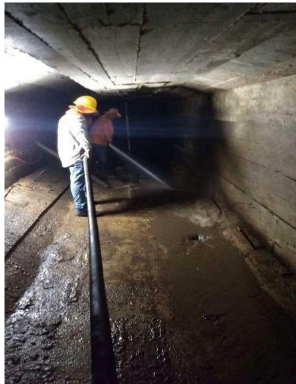
Figura 220 - Limpeza das galerias laterais da ponte do Braghetto. Fonte: DER/DF
