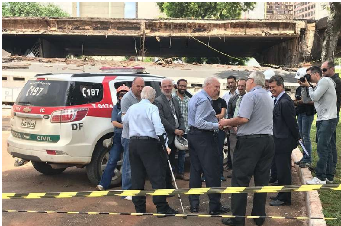
Figura 143 - Engenheiro Contarini no local do desabamento do Viaduto da Galerias sobre os Estados. Fonte: Larissa Batista
