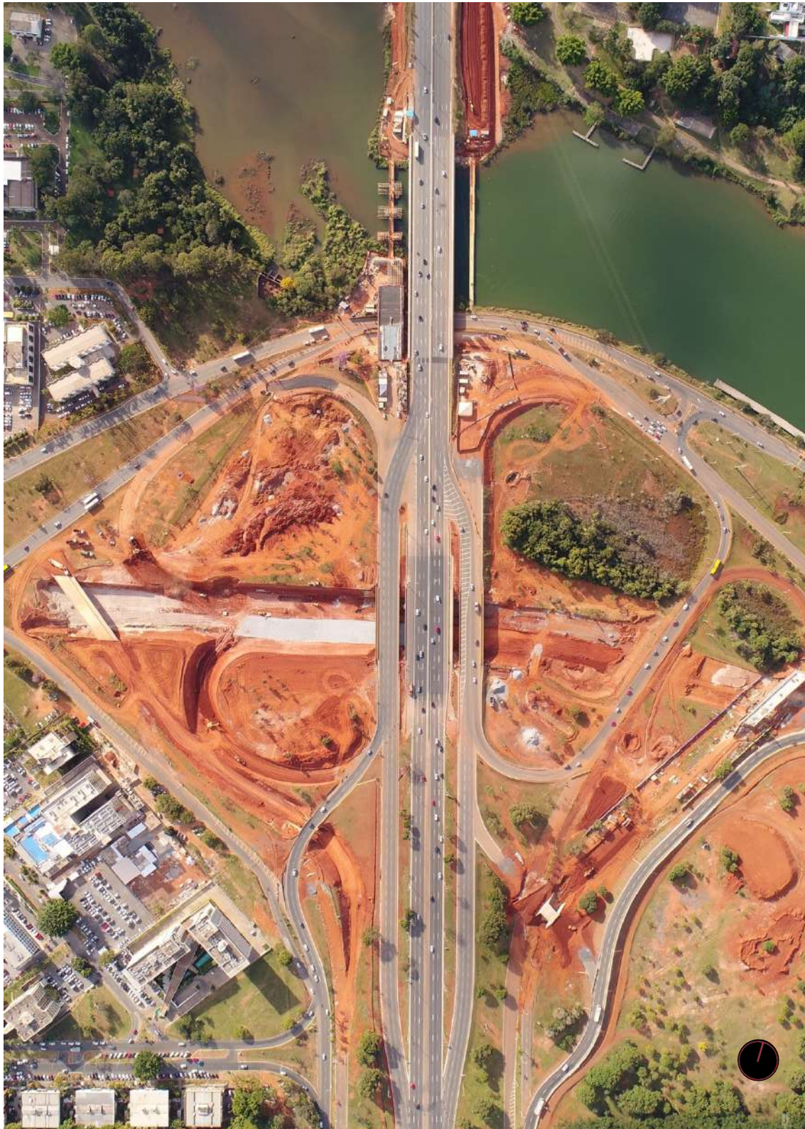
Figura 163 - Vista aérea do trecho norte do Trevo de Triagem Norte, em fase de obra. Fonte: DER/DF
