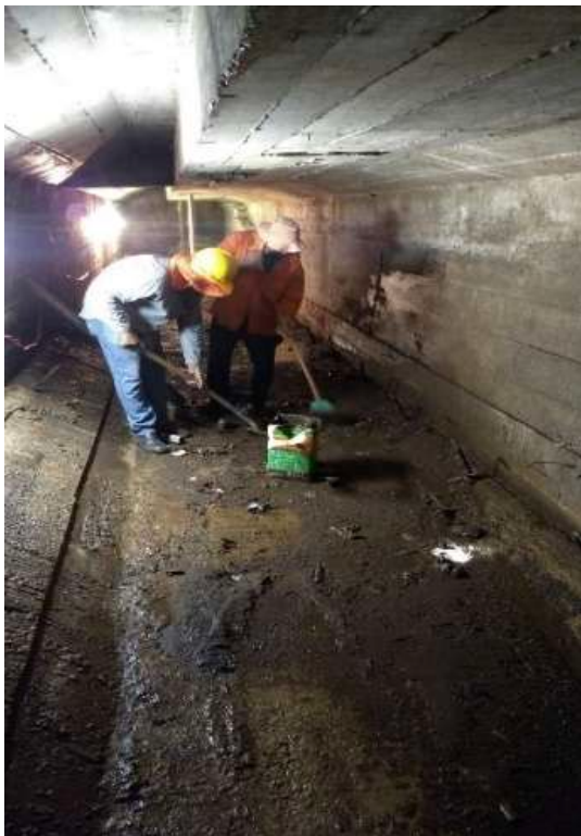
Figura 220 - Limpeza das galerias laterais da ponte do Braghetto. Fonte: DER/DF
