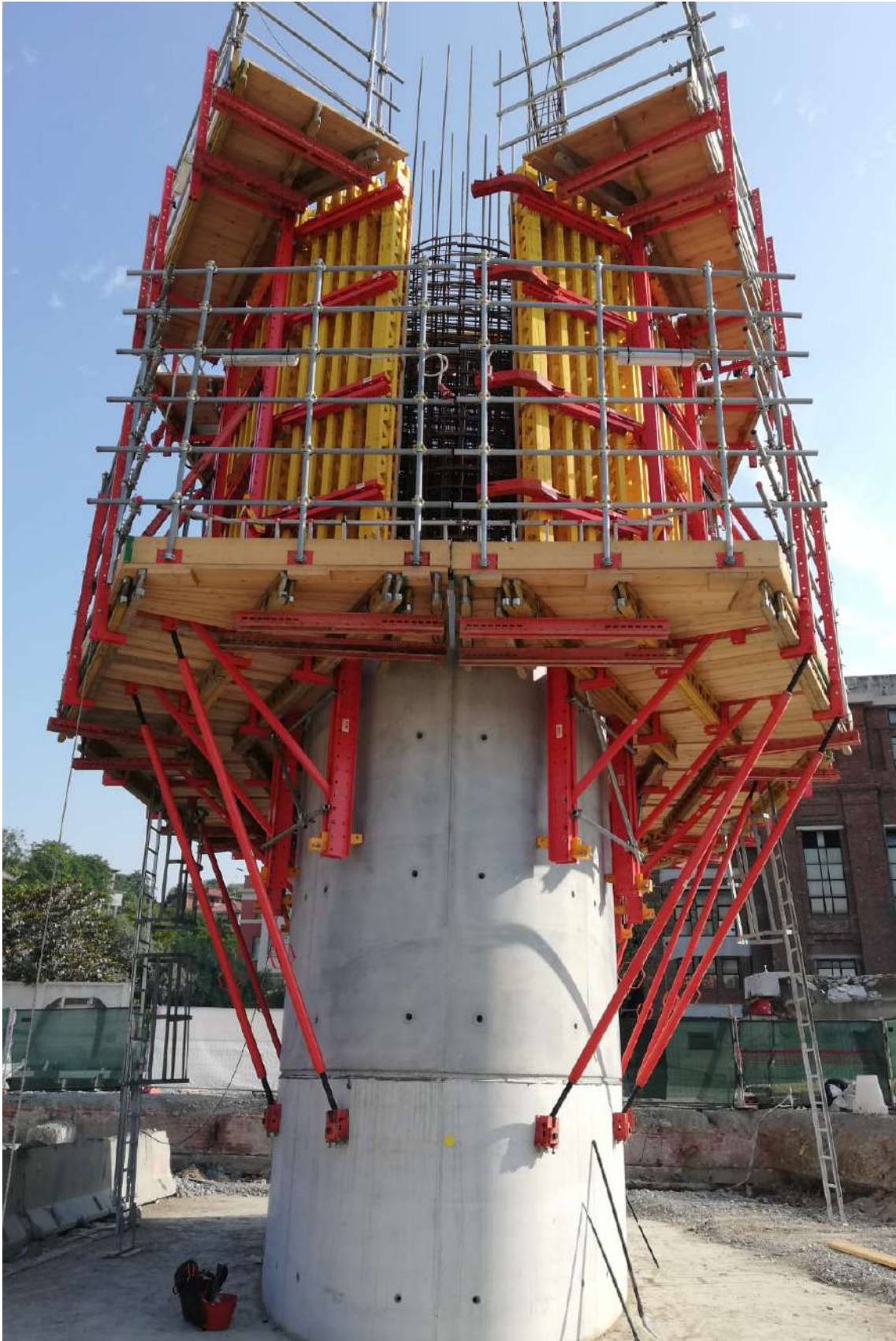
Figura 312 - Sistema de ancoragem das formas para concretagem dos pilares.
