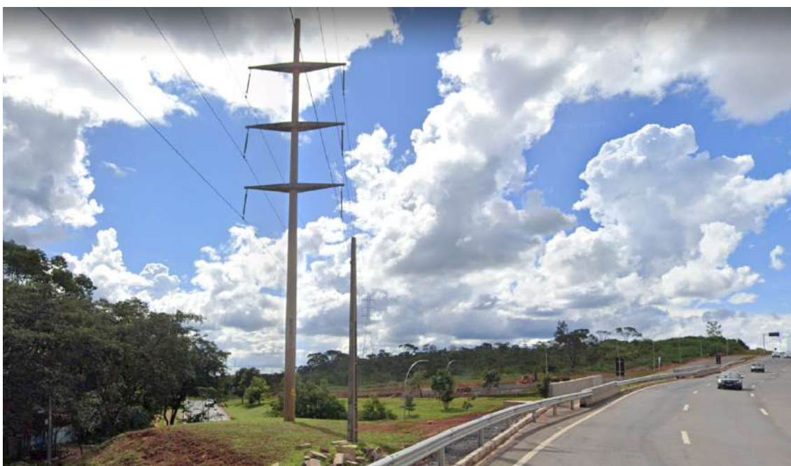
Figura 197 – Torre de alta tensão da CEB próxima à OAE 05A, TTN, Brasília, DF. Fonte: Google Earth
