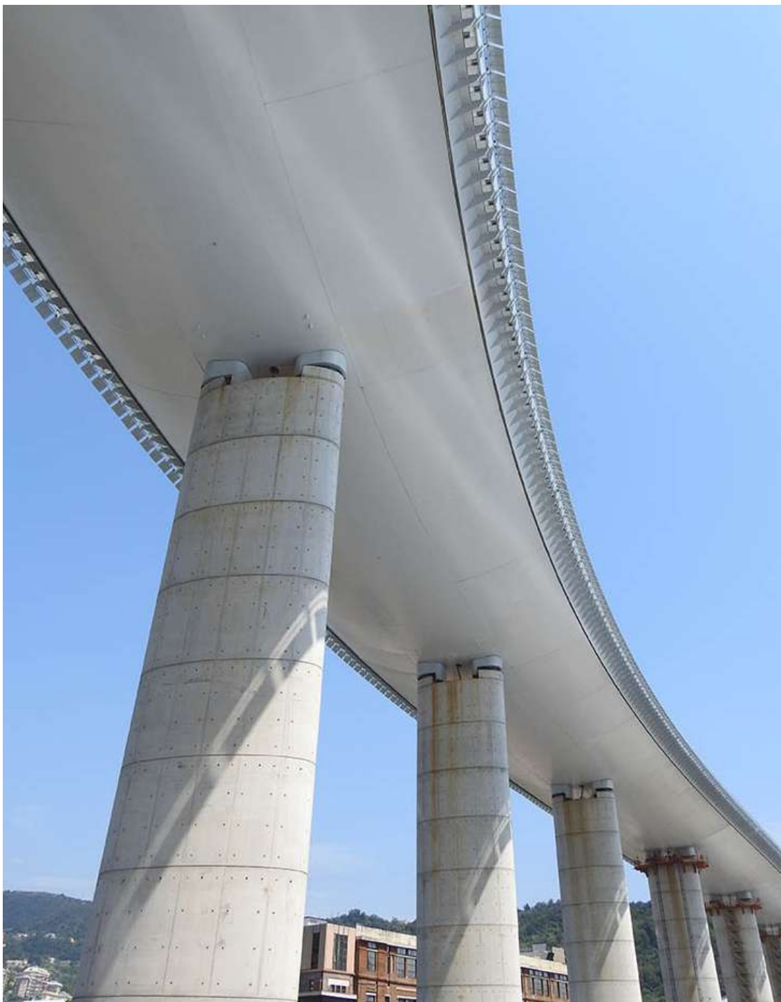
Figura 297 – Pilares em formato de elipse, Ponte San Giorgio. Fonte: Shunji Ishida
