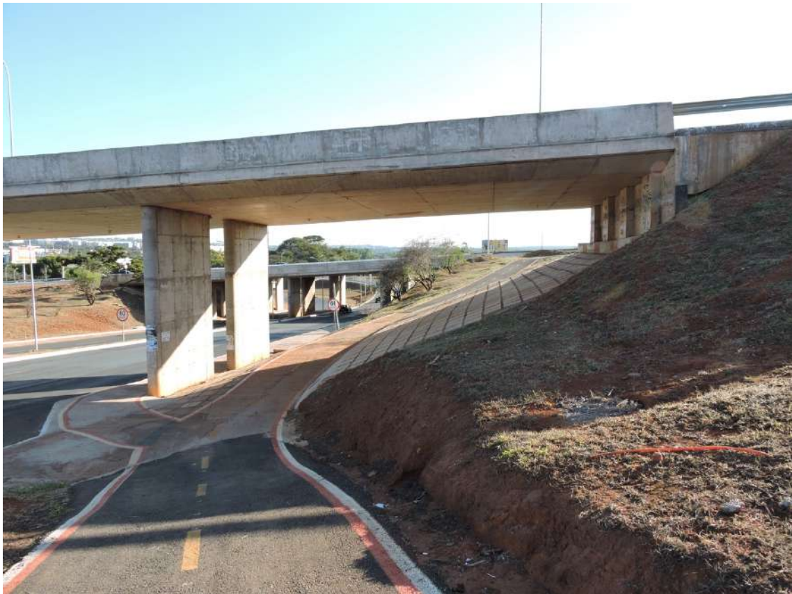
Figura 186 – Ciclovia passando pela OAE 02, cruzando-a em direção leste-oeste. Fonte: autoral
