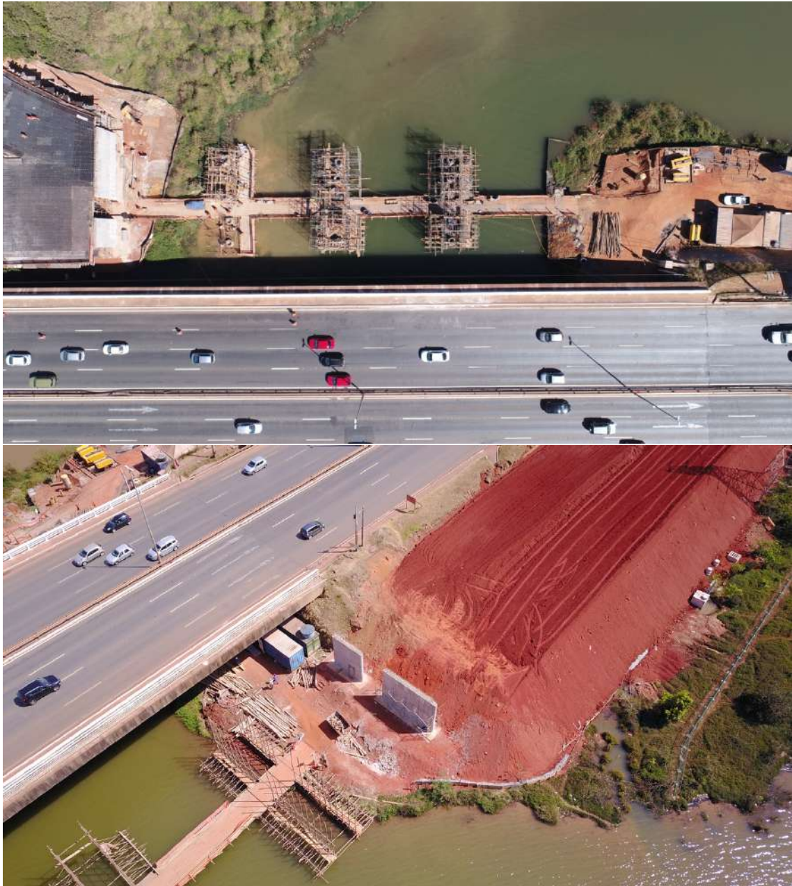
Figura 203 – Vista aérea da construção da OAE 06 do complexo do TTN e dos blocos de fundação 18 e 19, Brasília, DF. Fonte: DER, 2018
