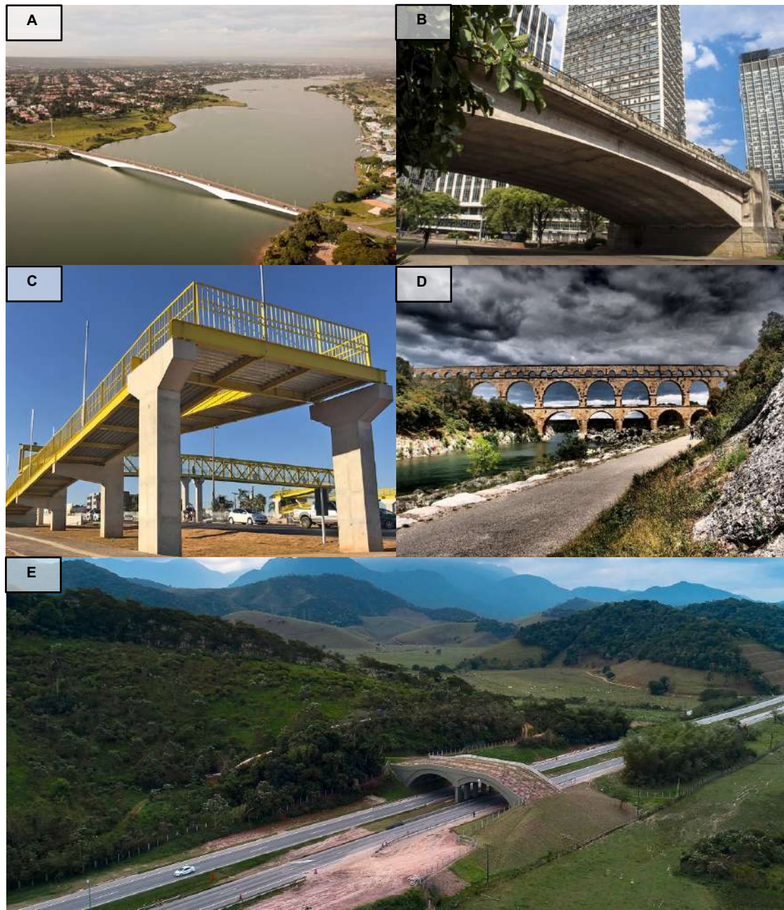
Figura 23 – A. Ponte Costa e Silva sobre o lago Paranoá, Brasília – DF. Foto: Joana França. B. Viaduto do Chá, São Paulo – SP. Fonte: Votorantim. C. Passarela sobre a rodovia BR-040, km0+425, Valparaíso de Goiás – GO. Fonte: Grupo CMP. D. Aqueduto romano Pont du Gard na França. Fonte: Di Filadelfia - Opera própria, CC BY-SA 3.0. E. Ponte Verde sobre a BR-101, Rio de Janeiro – RJ. Fonte: Adaptada de Wanderson Chan/AMLD.
