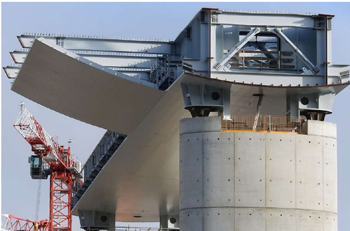
Figura 315 - Conexão do tabuleiro metálico pré-fabricado com a estrutura de sustentação vertical. Fonte: We Build e Marco Pelizza
