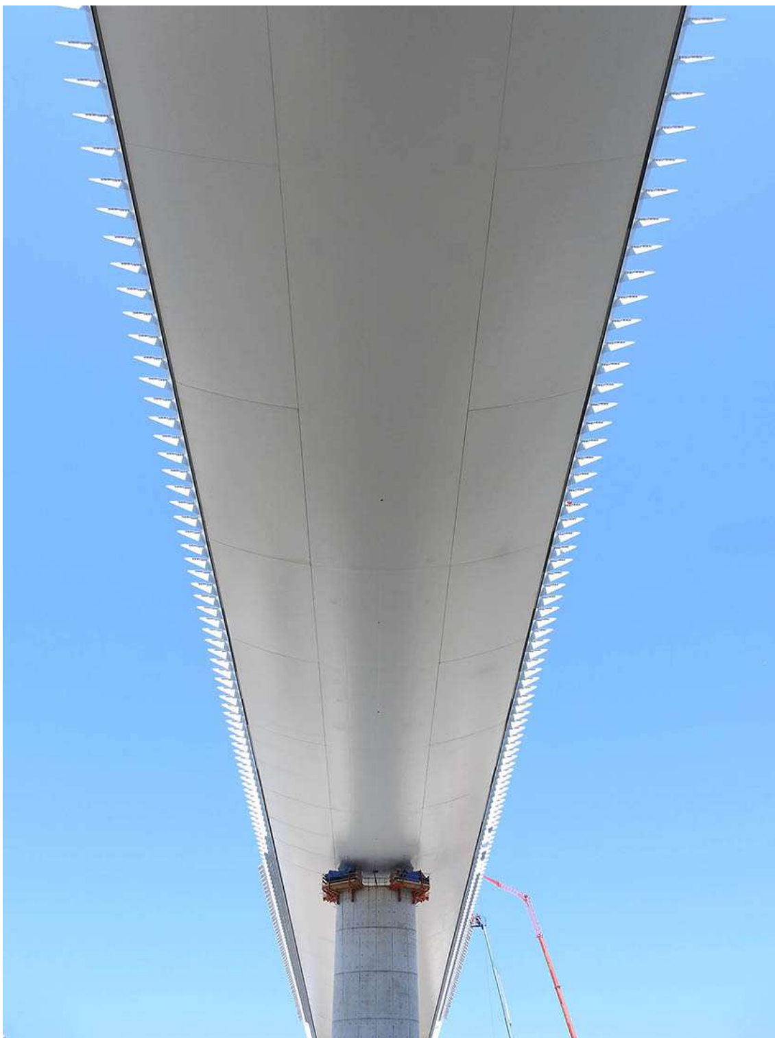
Figura 296 – Vista de baixo do tabuleiro, mostrando o cromatismo utilizado na ponte San Giorgio. Fonte: Shunji Ishida
