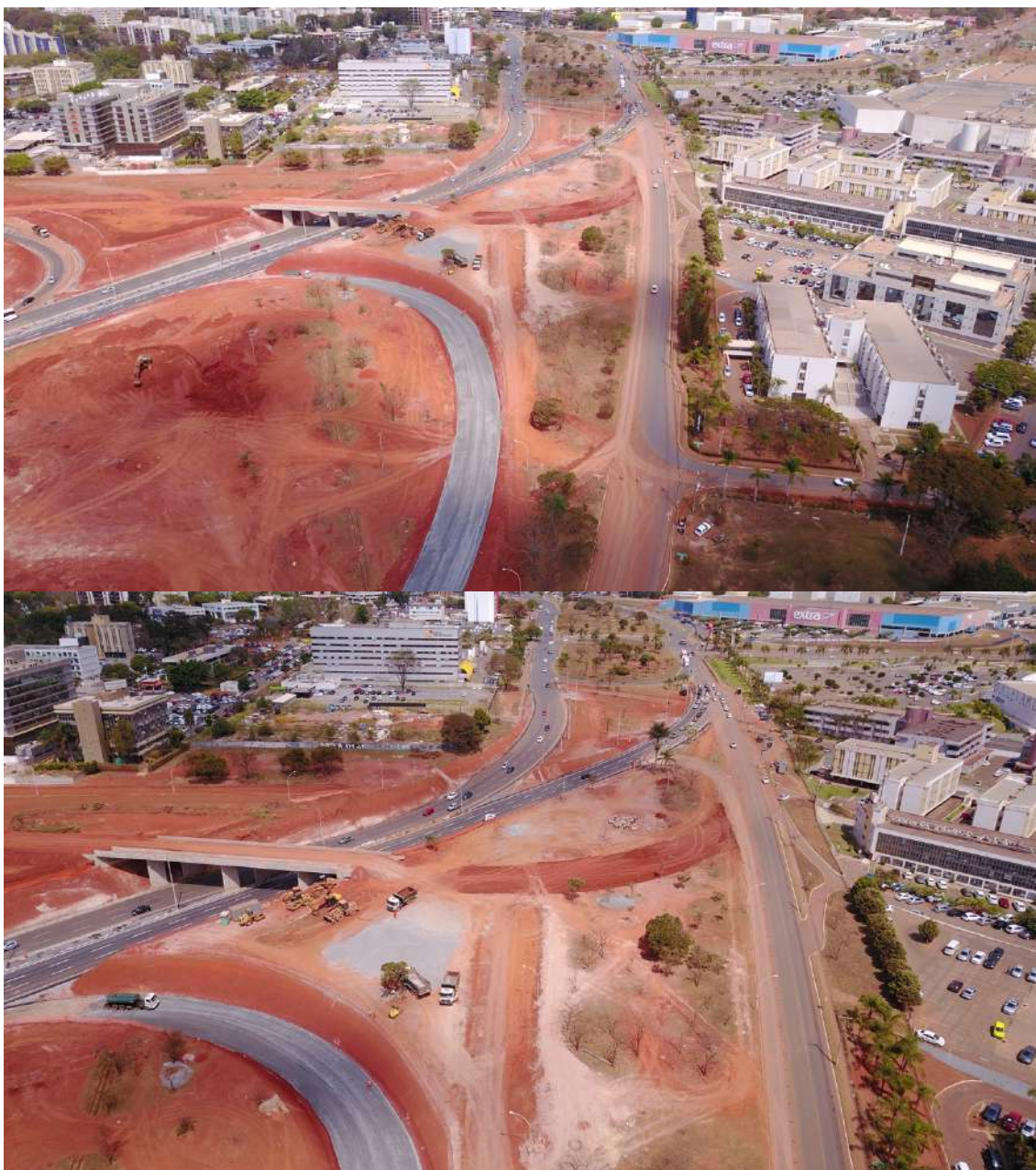
Figura 262 – Vista aérea da construção da OAE 10. Fonte: DER/DF, 2018
