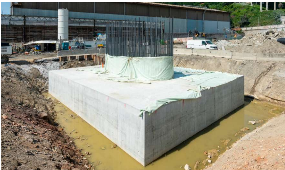
Figura 313 - Blocos de fundação para a nova infraestrutura. Fonte: We Build
