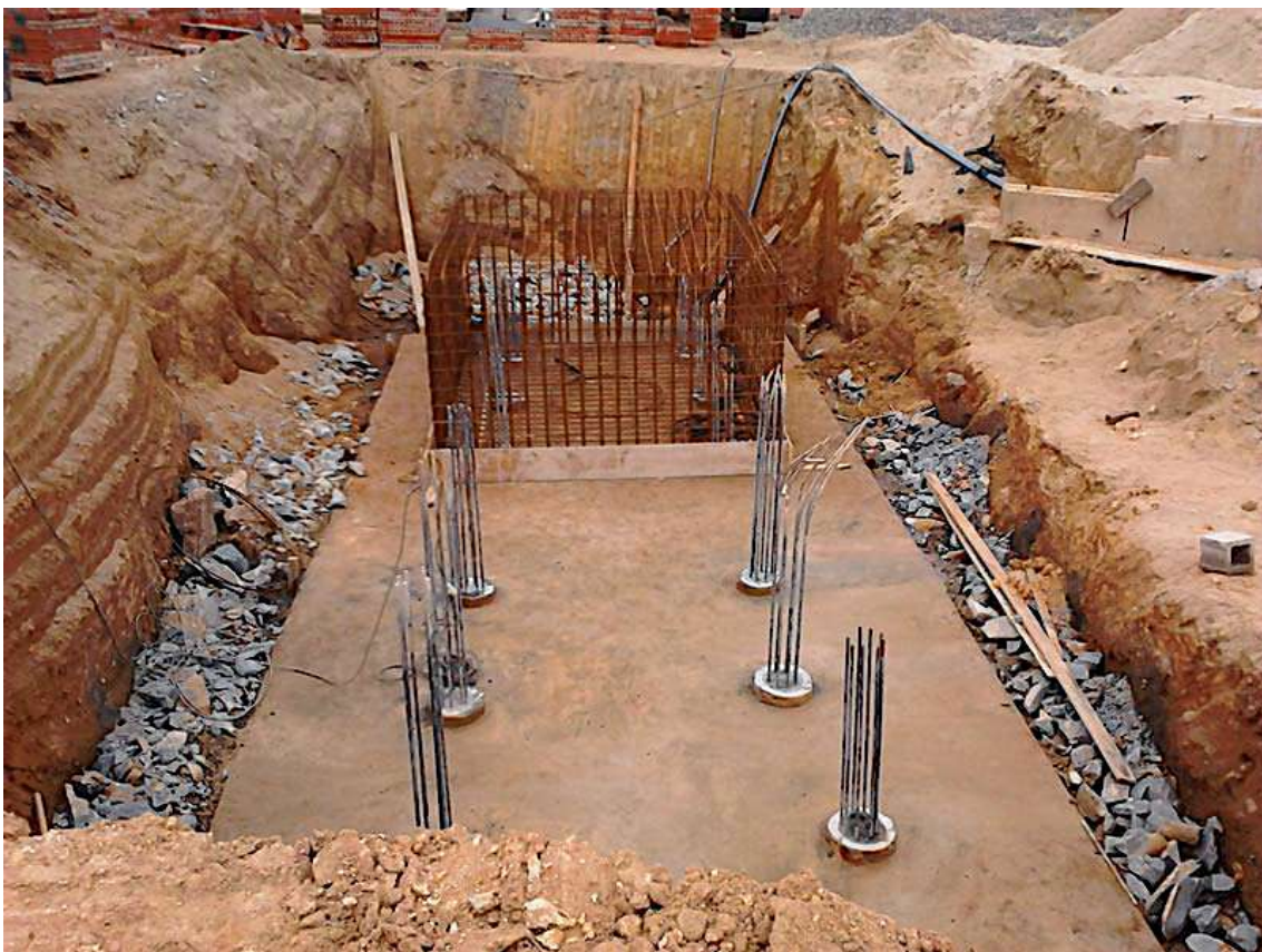
Figura 258 - Estacas com 2,00m para ser arrasada – Nível d'água aflorante. Ao fundo, mangote da bomba para secar a vala do bloco, OAE 09W, TTN, Brasília, DF. Fonte: DER/DF, 2018
