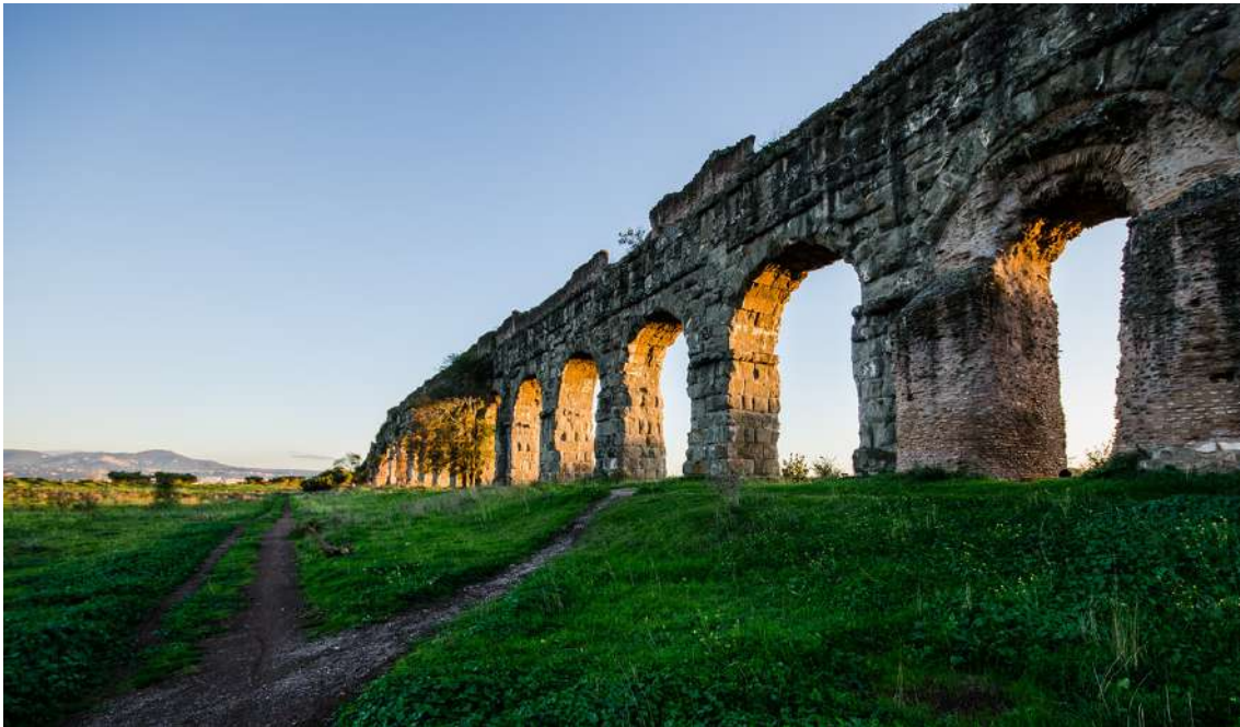
Figura 20 – Parque dos Aquedutos, Roma, Itália. Fonte: Mariaelena Leggieri
