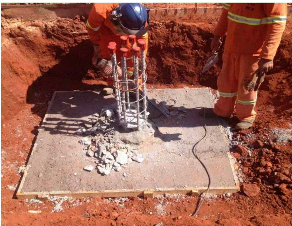
Figura 242 - Arrasamento da estacas da OAE 08, TTN, Brasília, DF. Fonte: DER/DF, 2018
