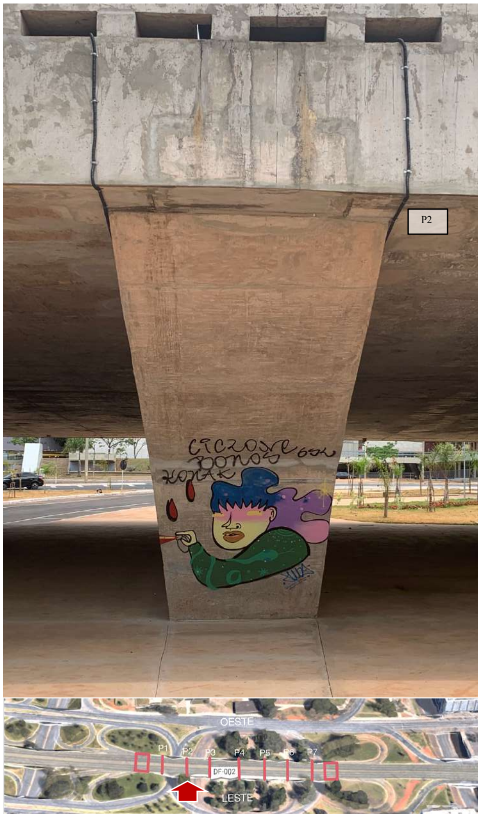
Figura 91 - Pilar 2, Lado Leste, vista frontal. Fonte: autoral / Adaptado de Google Earth
