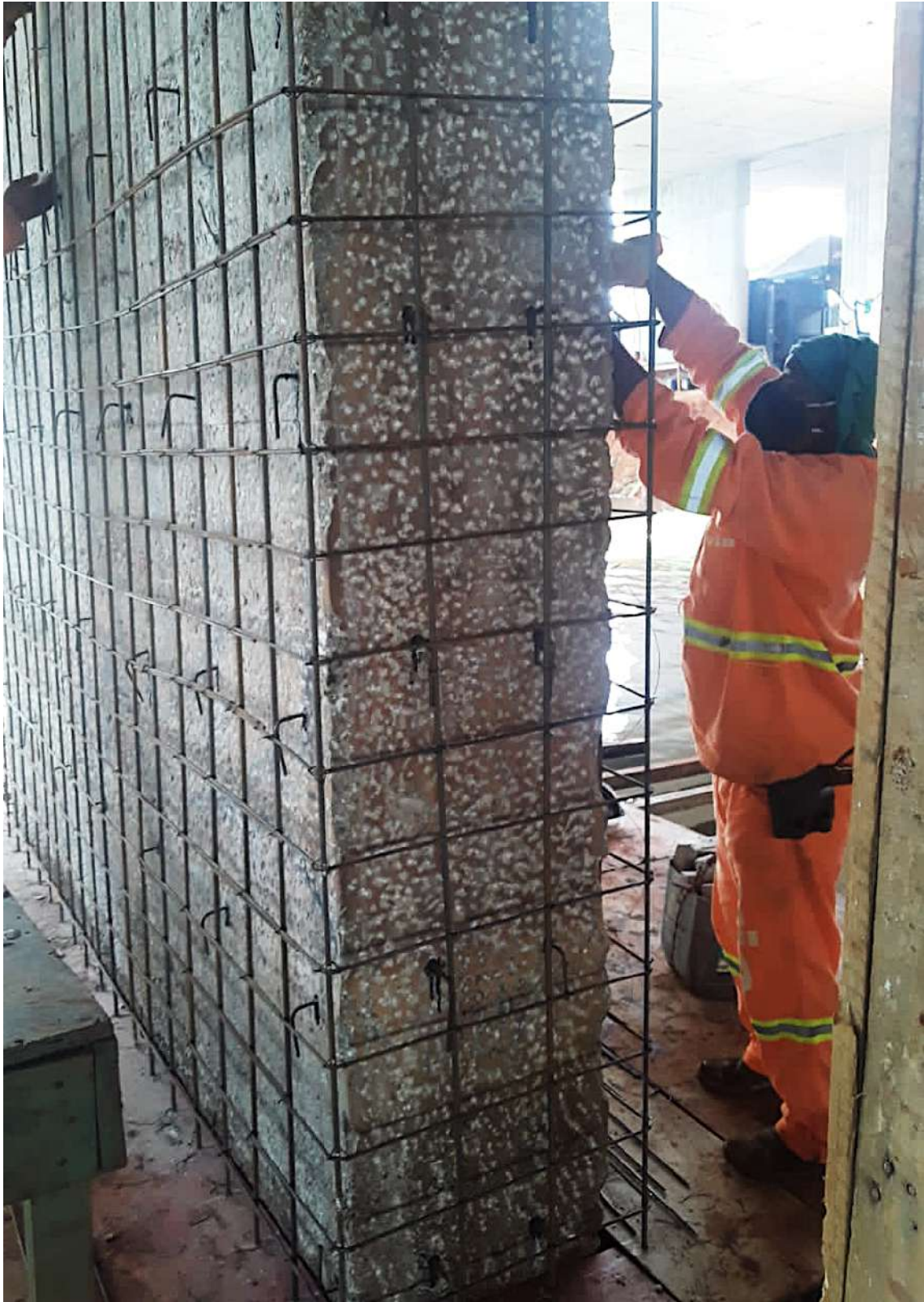
Figura 216– Armação para aumento da seção transversal dos pilares da ponte do Braghetto, Brasília, DF. Fonte: autoral
