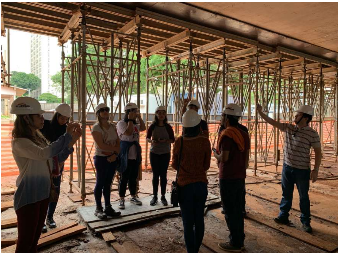
Figura 126 - Escoramento metálico de sustentação. Fonte: autoral
