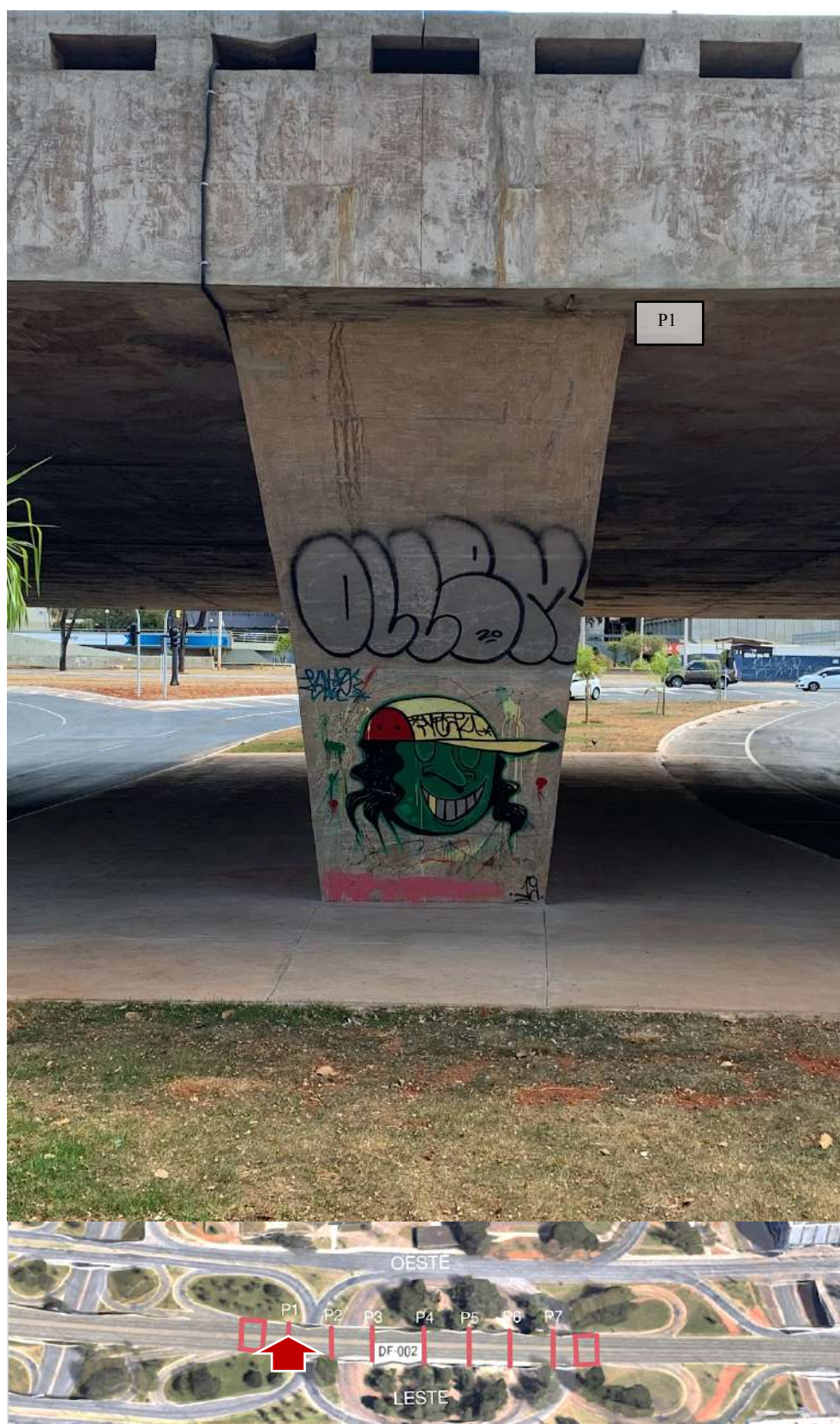
Figura 88 - Pilar 1, Lado Leste, vista frontal. Fonte: autoral / Adaptado de Google Earth
