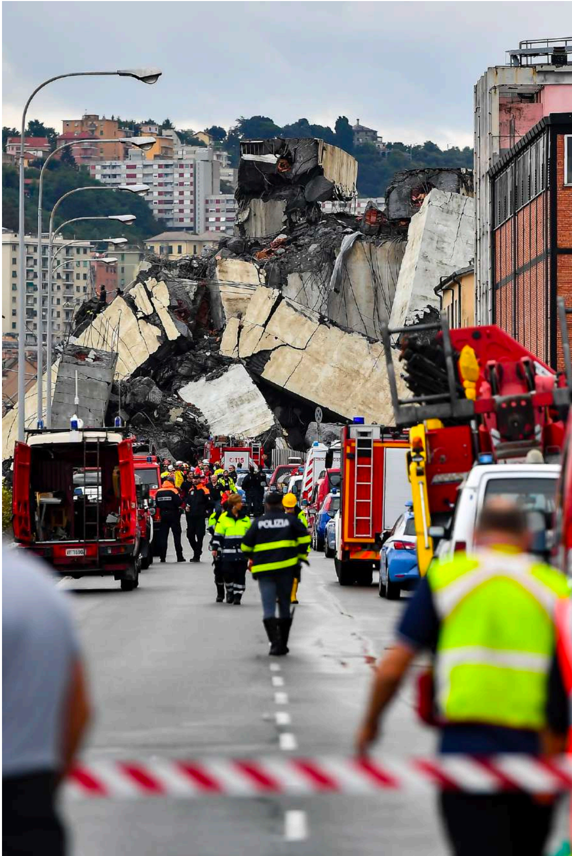
Figura 338 – Infraestrutura em estado de colapso. Fonte: Paolo Rattini/GettyImages
