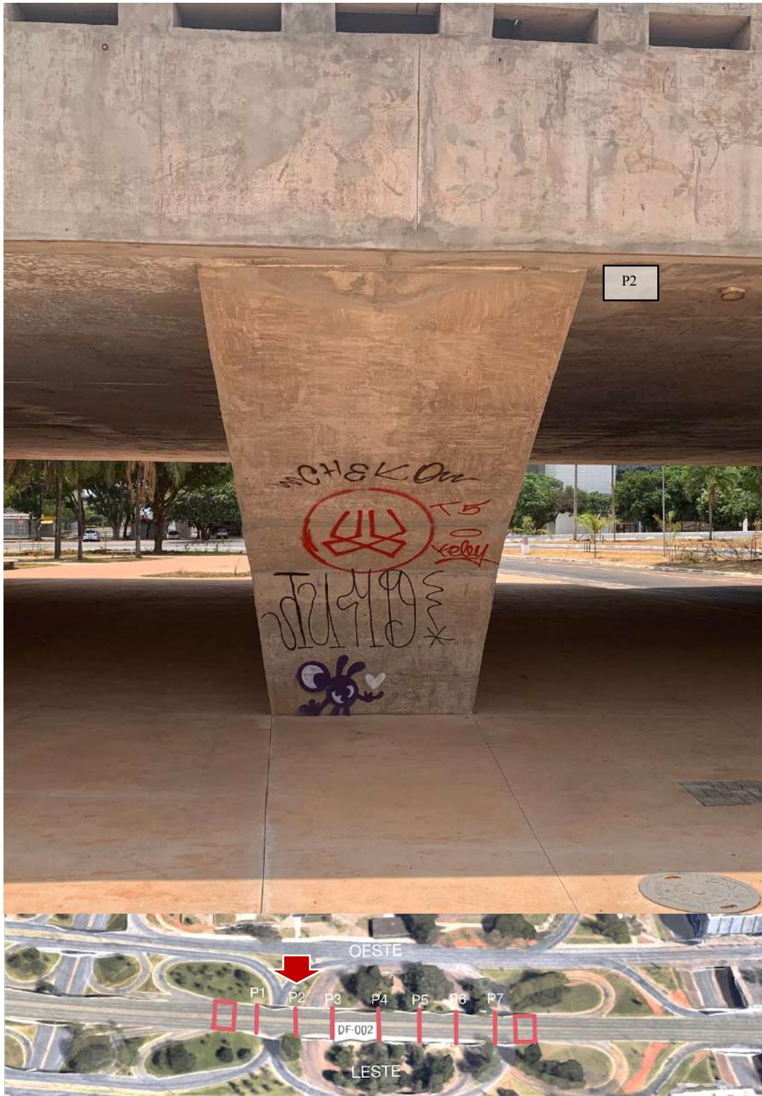
Figura 93 - Pilar 2, Lado Oeste, vista frontal. Fonte: autoral / Adaptado de Google Earth
