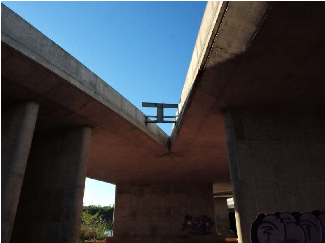
Figura 236 – Vista dos encontros dos trechos dos tabuleiros, OAE 07, TTN, Brasília, DF. Fonte: autoral
