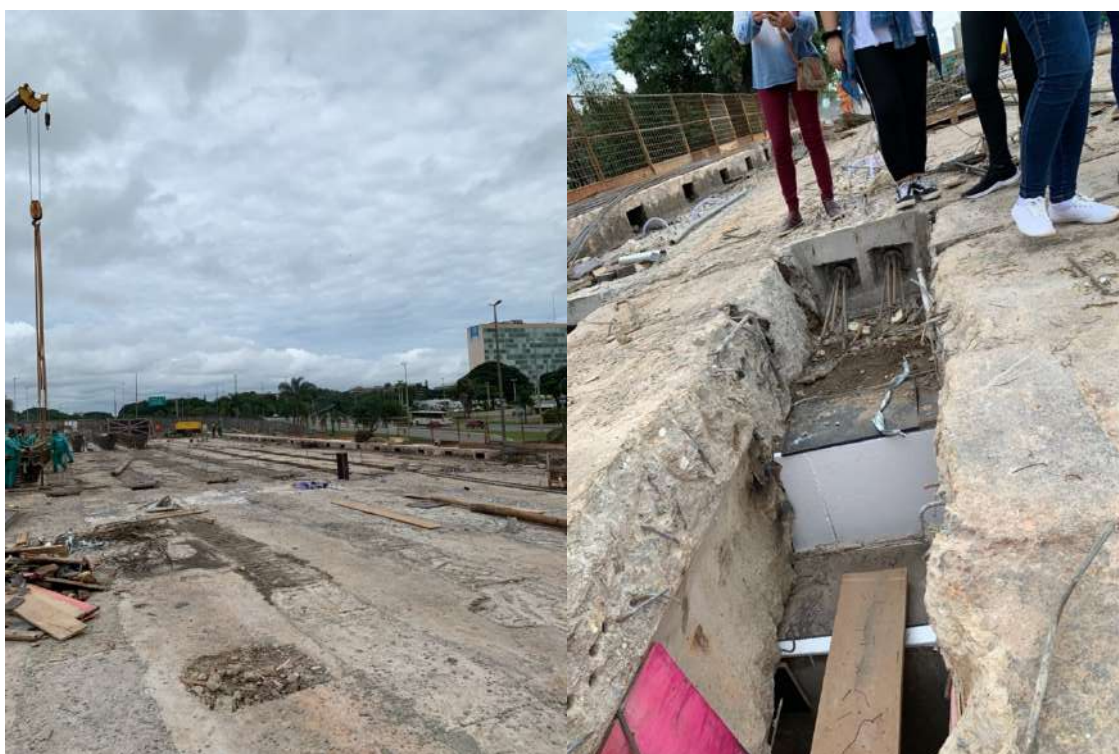
Figura 112 - Longarinas protendidas antes do capeamento da laje elástica. Fonte: autoral
