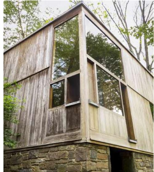
**Figura 37 - Revestimento em madeira da fachada da Fisher House com aspecto desgastado em virtude da exposição intensa às intempéries**
