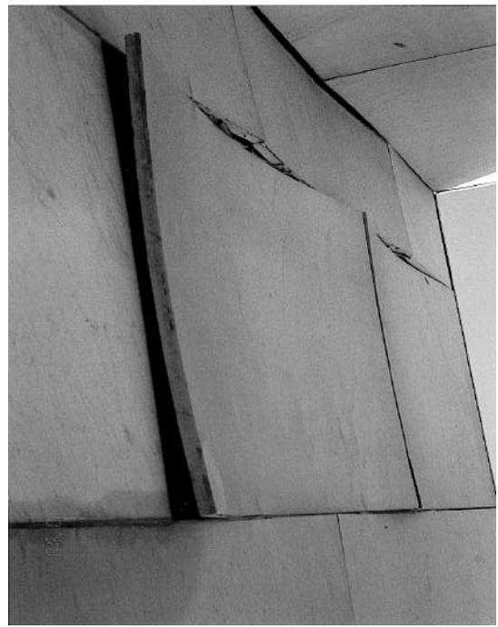
**Figura 35 - Detalhe do arqueamento sofrido pelo revestimento de mármore do Finlândia Hall em virtude da inadequação do uso do material na fachada**
