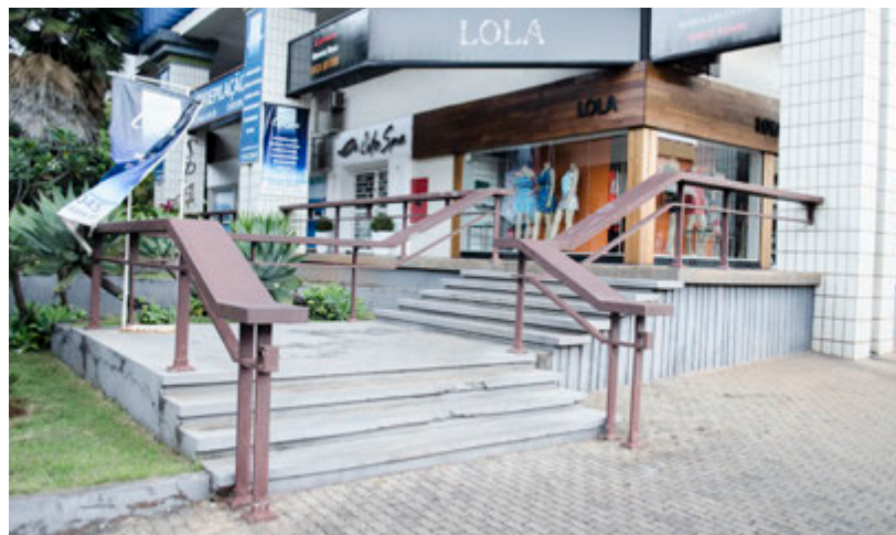
fig 21 Os acessos, tanto por rampas, como pelas escadas são bem desenhados, e articulados com a arquitetura. Valorizando o espaço publico.
