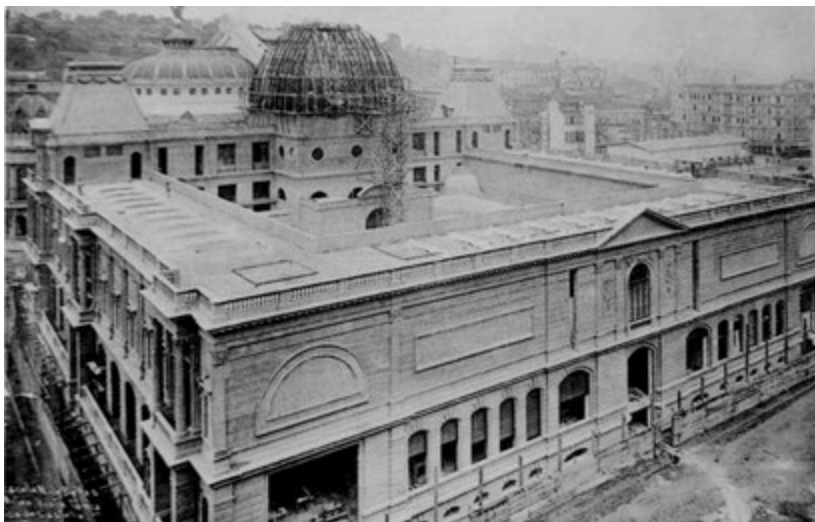
fig. 12 Escola de Belas Artes em construção, fachada voltada para a rua México.
