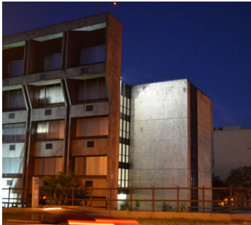
fig. 29: Edifício Bittar; 1977, Elvin Dubras. Brasília.
