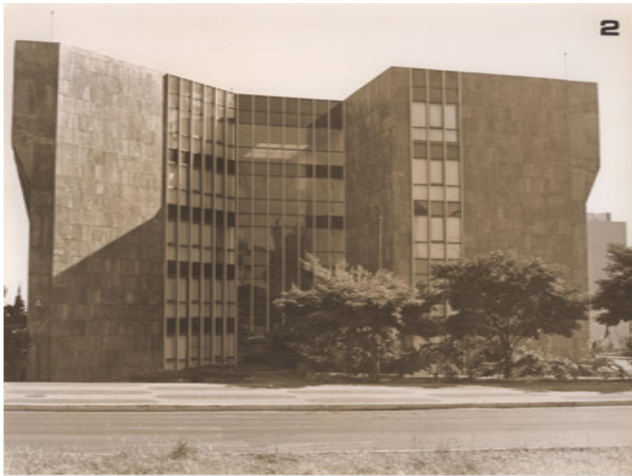
fig. 30: Edifício Bittar, 1977, Elvin Dubras. Brasília.
