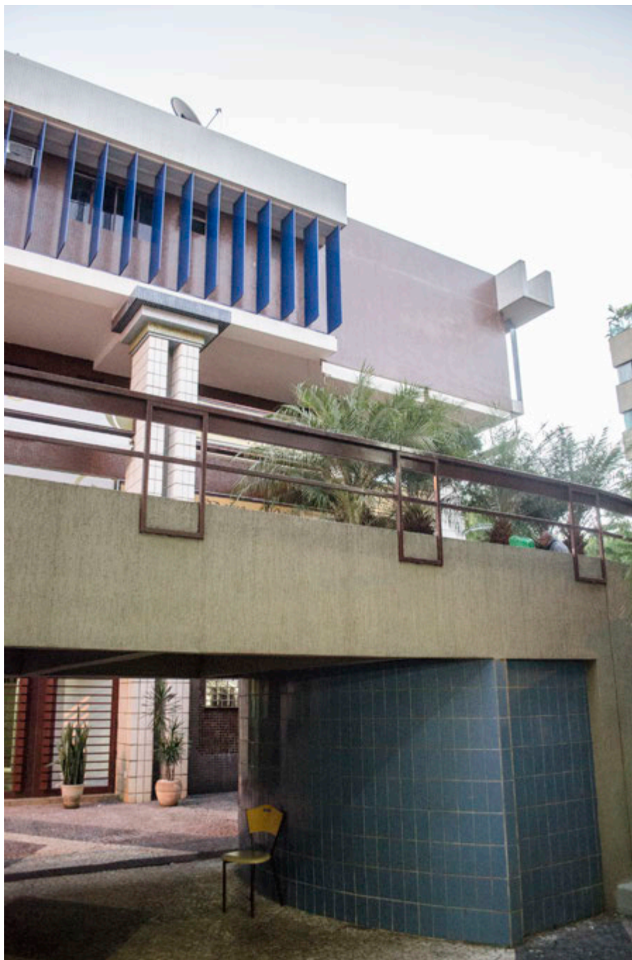
fig 25 No SCLN 309/308, Centro Comercial Boulevard, a cota de soleira possibilitou aflorar o subsolo. O recurso de ponte foi uma solução de garantir a mobilidade. Imagem da ponte e do módulo de um dos banheiros, em cerâmica azul, que fazem parte do conjunto.
