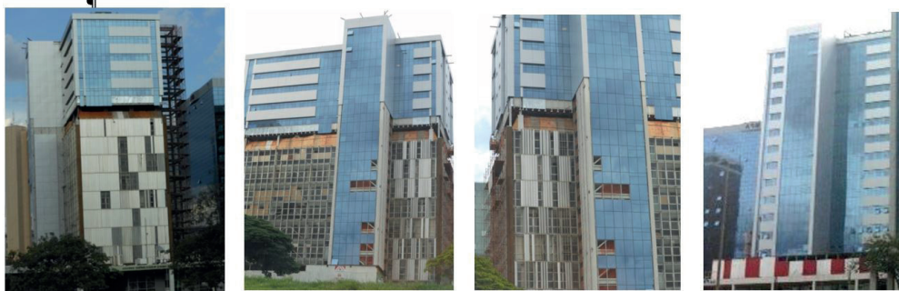
Figura 1. Imagens da cronologia da intervenção na fachada de edifício localizado no Setor Bancário Sul: substituição dos brises por vidros reflexivos.
