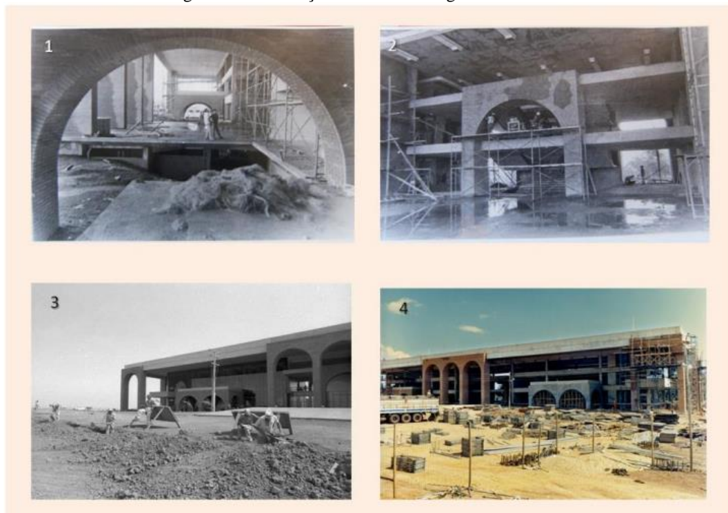
Figura 12: Construção do Palácio Araguaia 1990-1991
