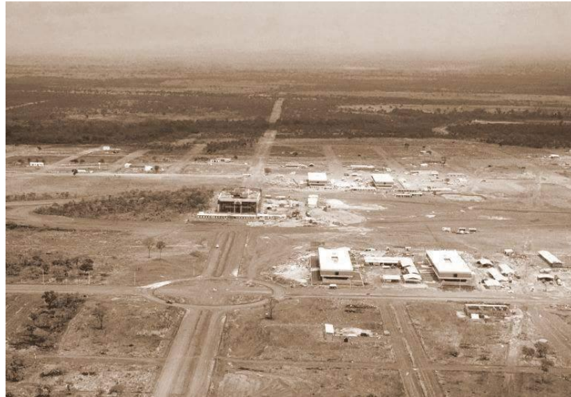
Figura 11: Início da construção do Palácio Araguaia
