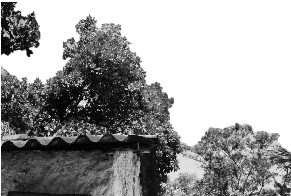
Imagem 40 - Telhado do barracão. Queda em duas águas.
