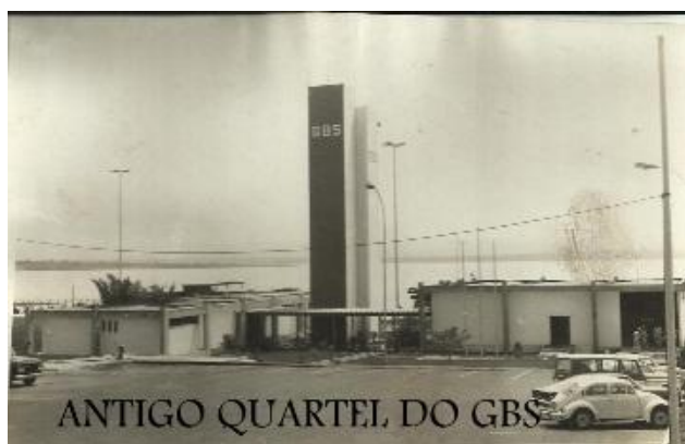
Figura 1- Foto do Quartel do GBS quando de sua construção, em 1969. Fonte: Site oficial do CBMDF67.
