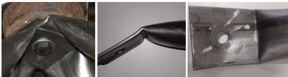
(d) Extremidade da ligação da LTDA2 com a barra da diagonal comprimida
