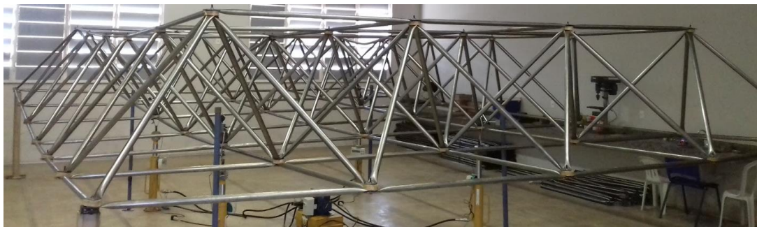
(b) Vista da ruptura do protótipo LTDFS1
