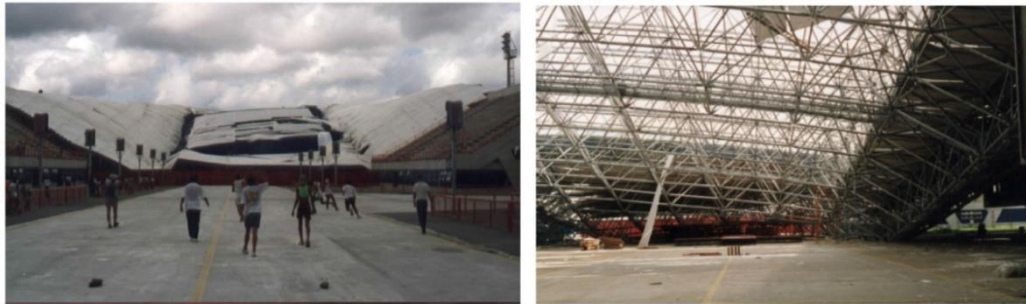
Figura 1.27 – Colapso da cobertura do centro de Convenções de Manaus (Sampaio, 2004)
