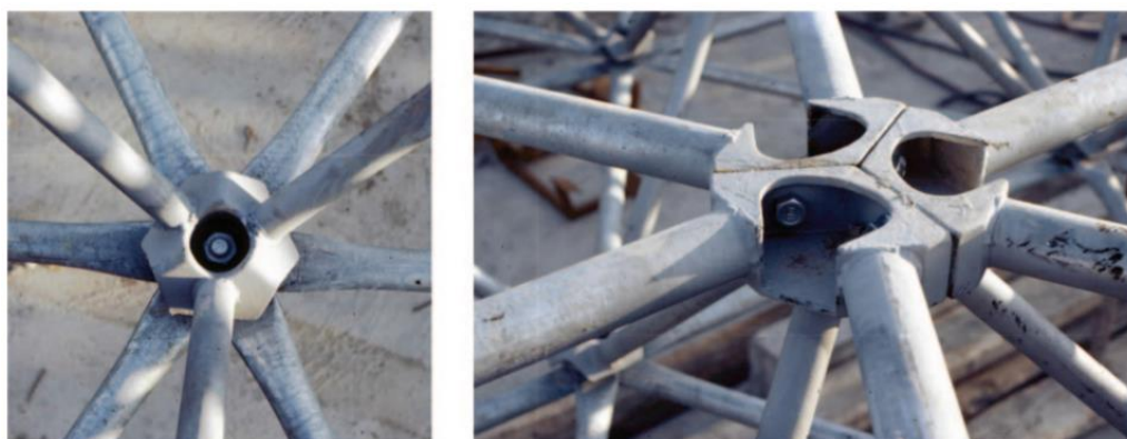
Figura 2.22 – Treliça tridimensional nó da camada inferior (esquerda) e nó da camada superior (direita) (Tarczewski e Motro, 2015)
