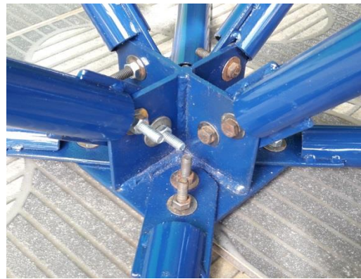
(k) Ligação com Ponteira usando dispositivo de chapa de aço - Modelo 1 - Sistema c 1
