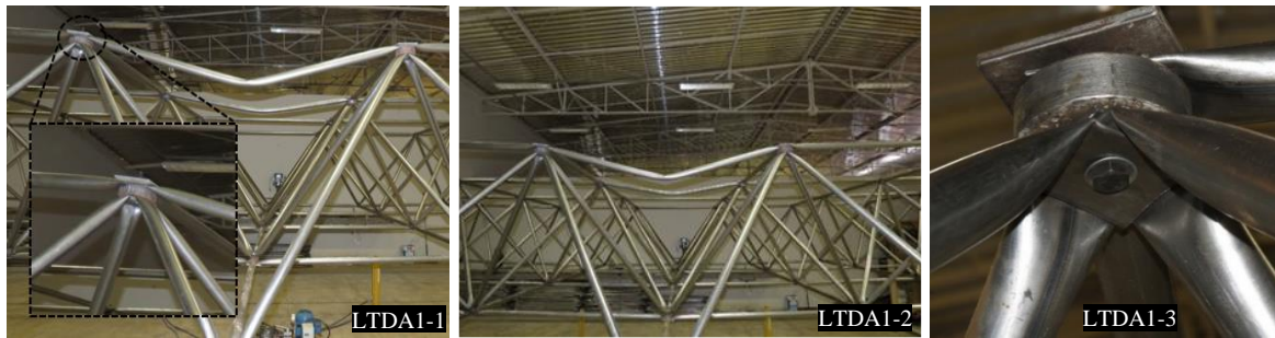
(a) Detalhe do modo de colapso do protótipo LTDA1
