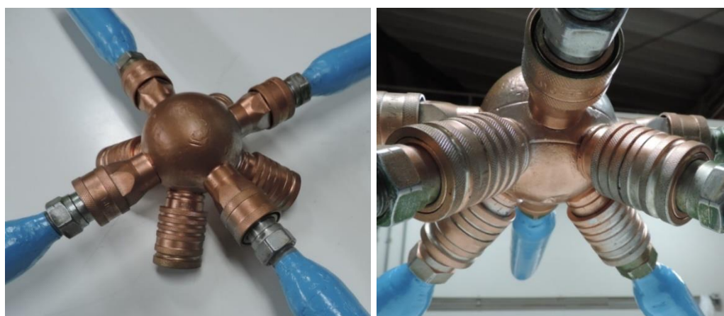
(b) Detalhe da ligação com a ligação do banzo e do encaixe da barra na esfera
