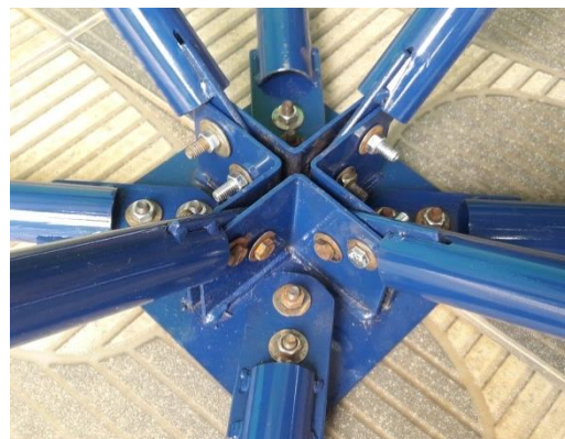
(l) Ligação com Ponteira usando dispositivo de chapa de aço - Modelo 2 - Sistema c 2
