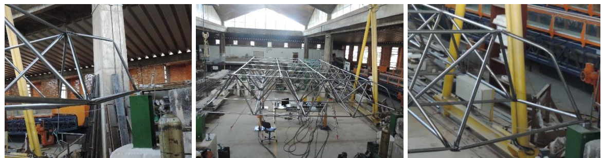
(d) Visão geral sobre o colapso da ligação típica LTCR1
