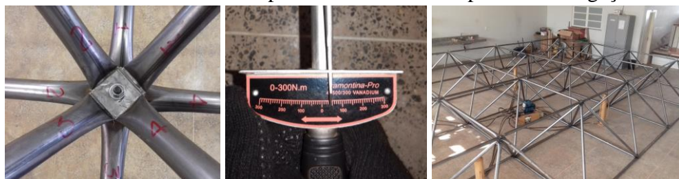
(d) Convenção para montagem dos protótipos (e) Torque de 50 N.m em todos parafusos da treliça (f) Treliça tridimensional pronta para içamento
