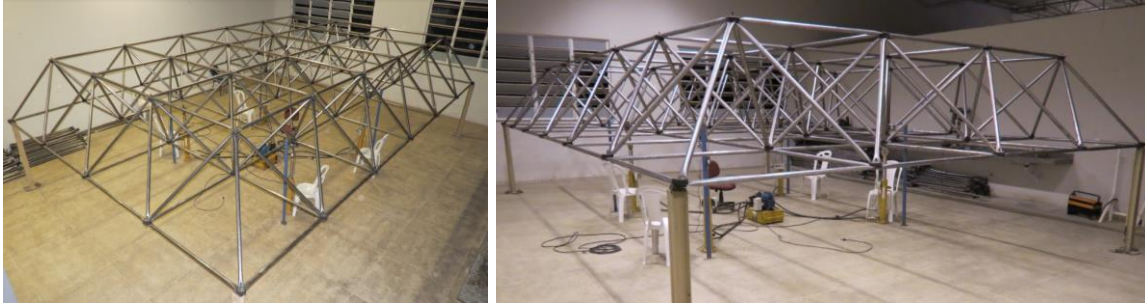
(a) Protótipo LTDP antes do colapso
