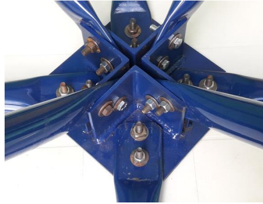
(i) Ligação Típica com dispositivo de chapa de aço Modelo 3- Combinação Sistema b 3
