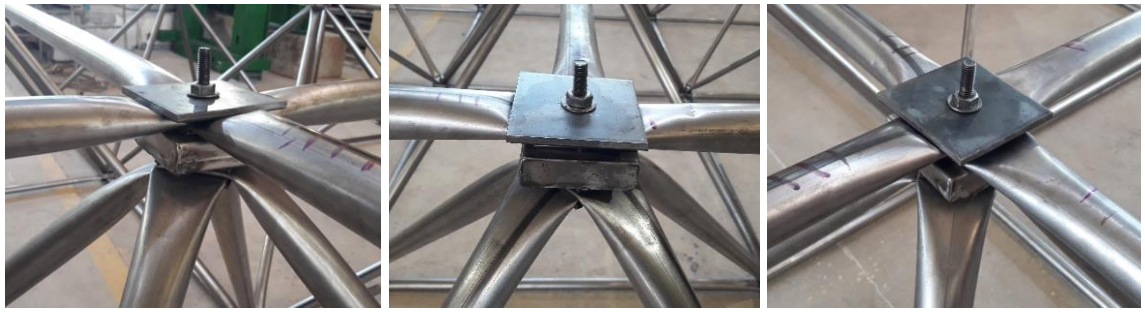
(c) Detalhe das ligações com LTDCEA
