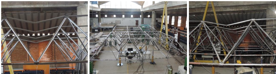
(c) Vistas do colapso da LTDCEA1 com detalhe do banzo comprimido que rompeu
