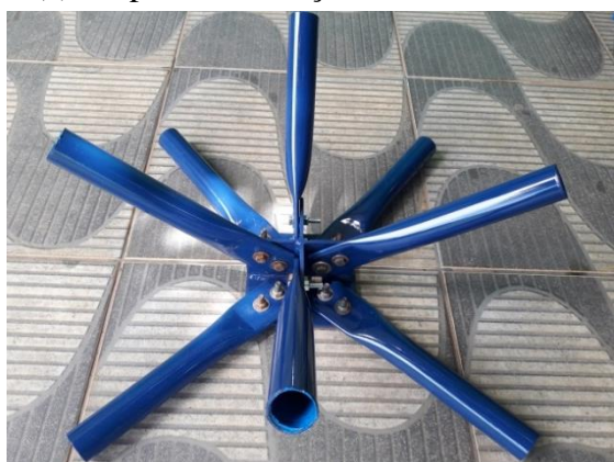
(g) Ligação Típica com dispositivo de chapa de aço Modelo 1- Combinação Sistema b_1
