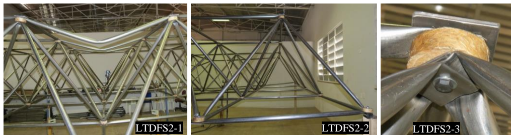
(b) Modos de colapso do protótipo LTDFS2
