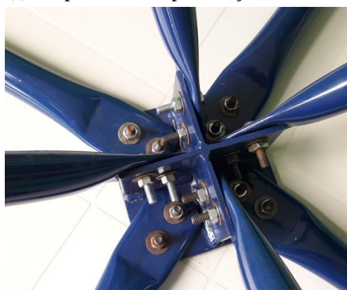
(g) Ligação Típica com dispositivo de chapa de aço Modelo 1- Combinação Sistema b_1
