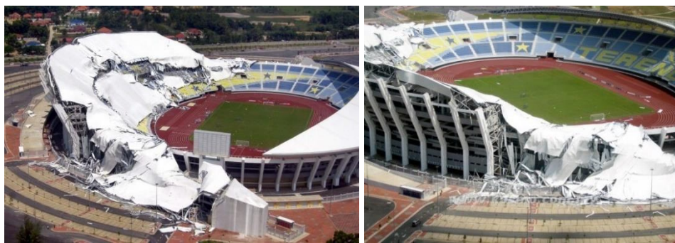
Figura 1.19 – Detalhe do colapso da cobertura do “ Shah Alam Stadium ” na Malásia. (Michael e Razak, 2013) e (Hamid, 2015)
