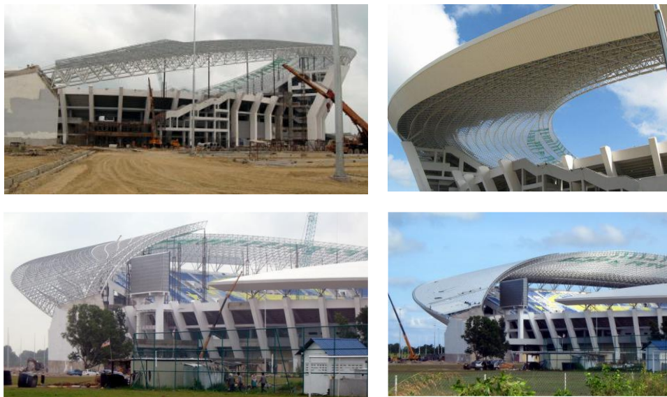
Figura 1.18 – Detalhes da construção Shah Alam Stadium na Malásia. (CL.Chiang, 2010)
