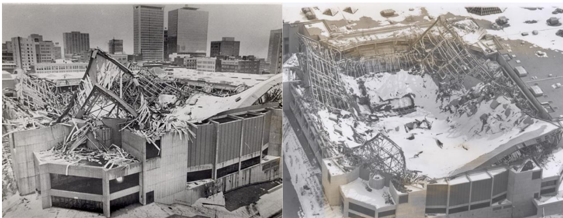
Figura 1.9 – Detalhes do colapso do Coliseu Centro Cívico de Hartford (ENR, 1978)
