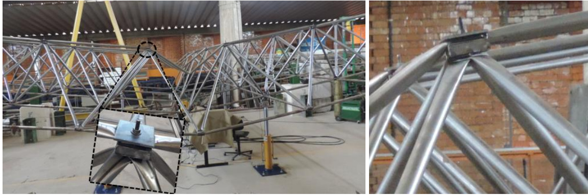
(i) Vista dos distanciadores no segundo ensaio com os protótipos LTDCEA2
