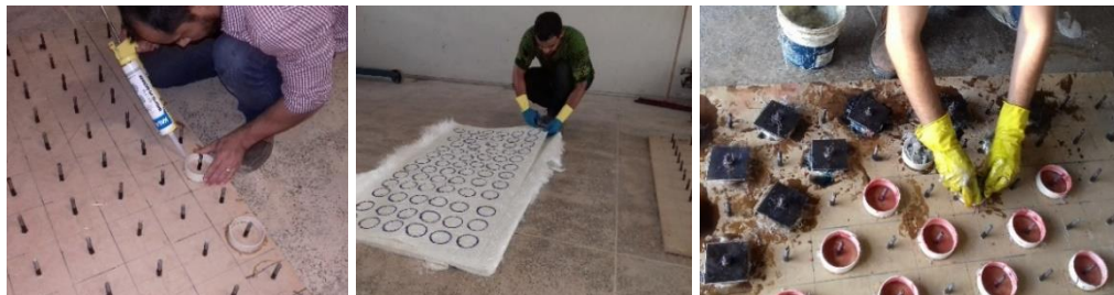
(a) Construção da forma na placa compensada (b) Detalhe do corte da fibra de vidro (c) Construção do distanciador com fibra de vidro
