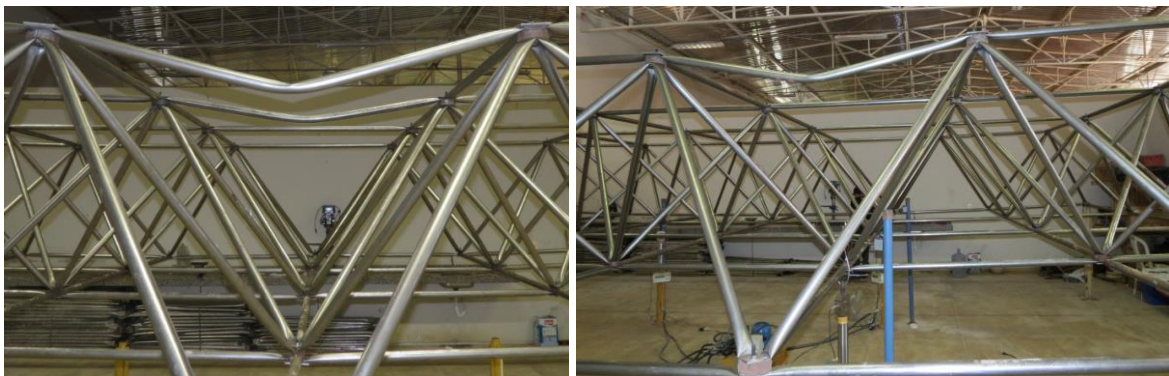
(b) Detalhe do colapso do protótipo LTDA1 e LTDA2
