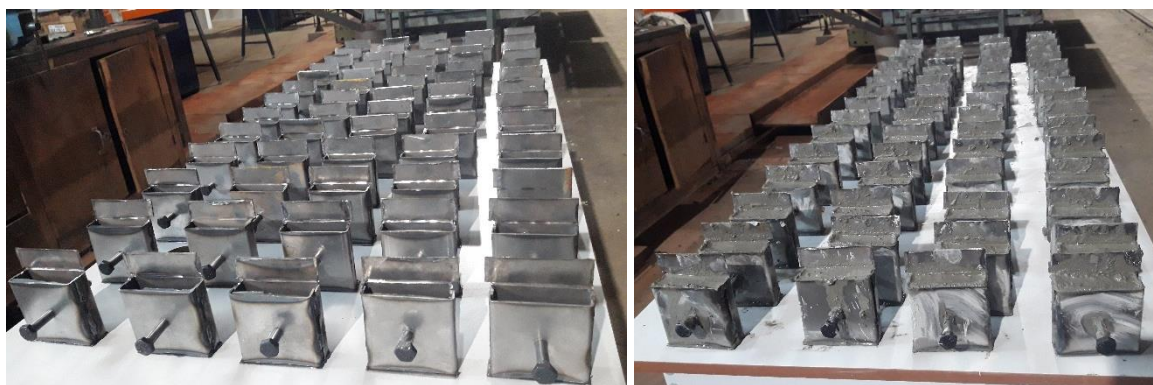
(b) 56 formas dos Distanciadores com parafuso central e na sequência concretagem
