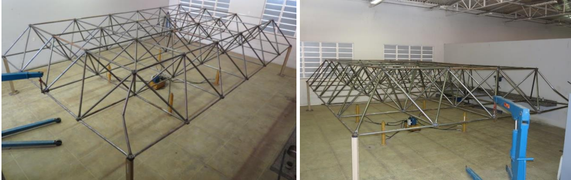
(a) Colapso do protótipo LTDFV1
