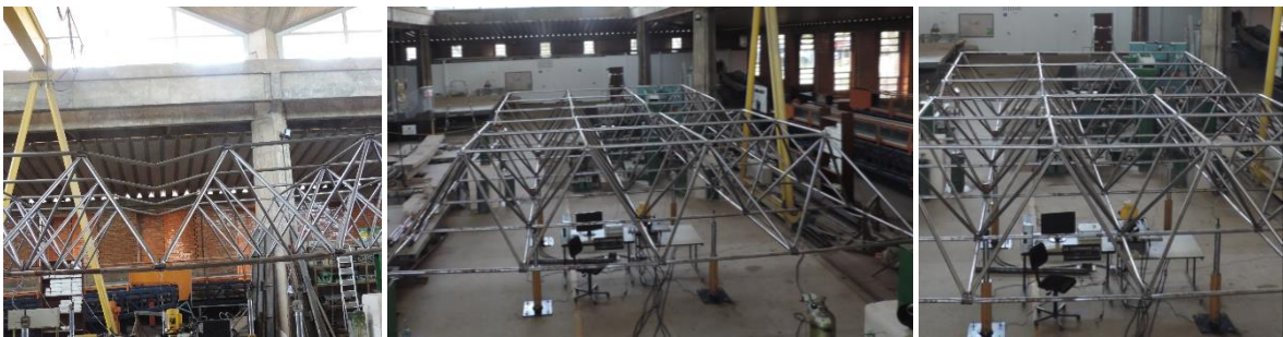
(b) Vistas do colapso da LTDCEA1
