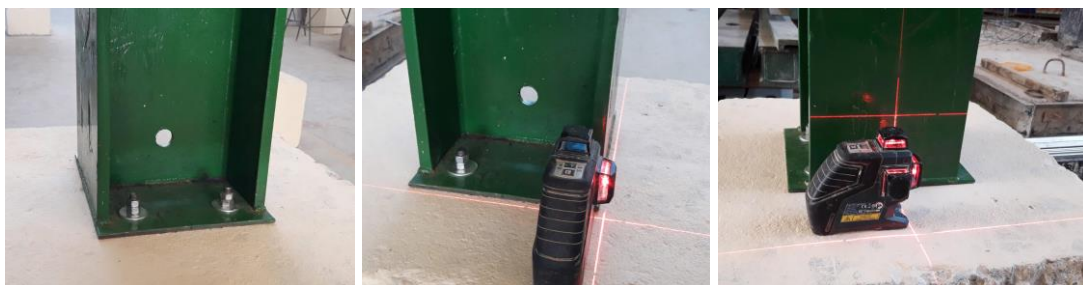
(c) Perfis W 250x73,0 fixados dos nos blocos de concreto com a conferência do nível
