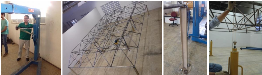
(a) Içamento da treliça
