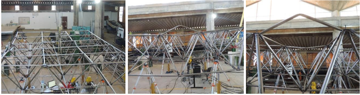
(f) Vista dos banzos superiores da LTCR2 com ruptura por instabilidade
