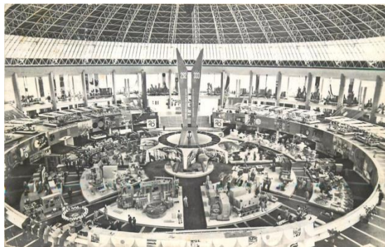
Vista interna antes do colapso
