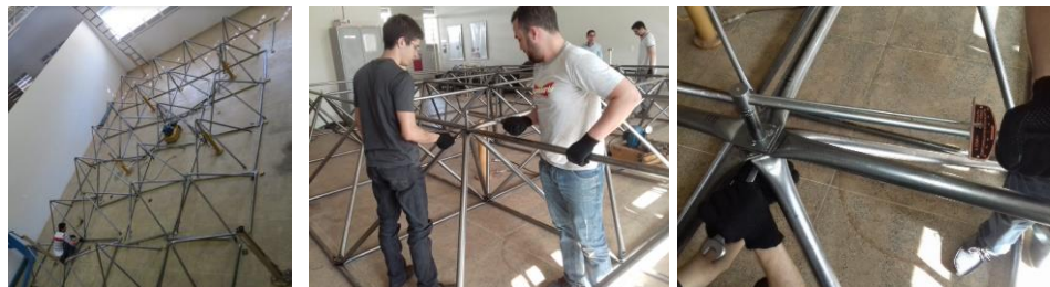
(a) Montagem dos módulos no piso do laboratório (b) Torque prévio dos parafusos (c) Execução do torque no parafuso da ligação
