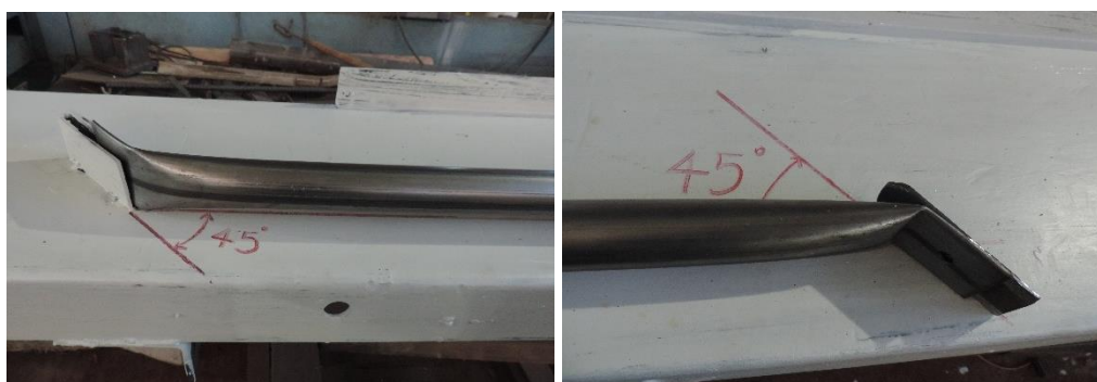
(d) Execução da inclinação de 45^\circ nas barras das diagonais
