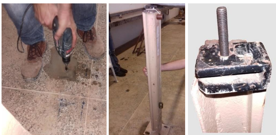
Figura 5.24 – Perfuração, prumo e fixação dos chumbadores de expansão.
