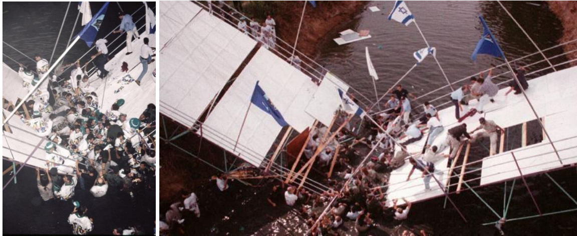
Figura 1.13 – Colapso da passarela Maccabiah em Israel (Trounson, 1997) e (Beck, 1998)
