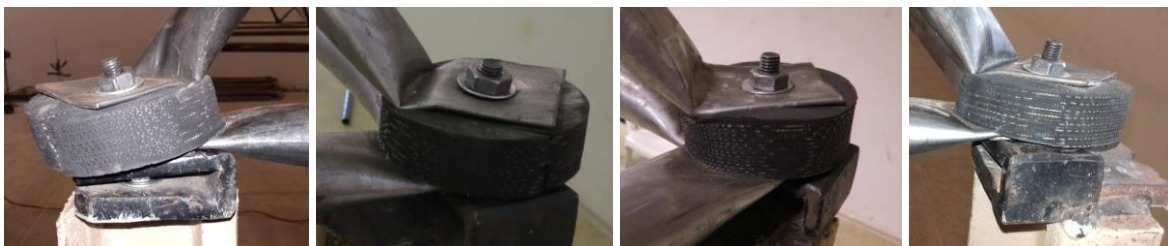
(d) Distanciadores no apoio dos protótipos na coluna metálica
