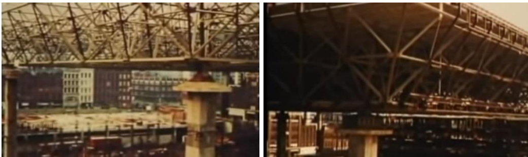
(a) Vista da estrutura sendo construída
