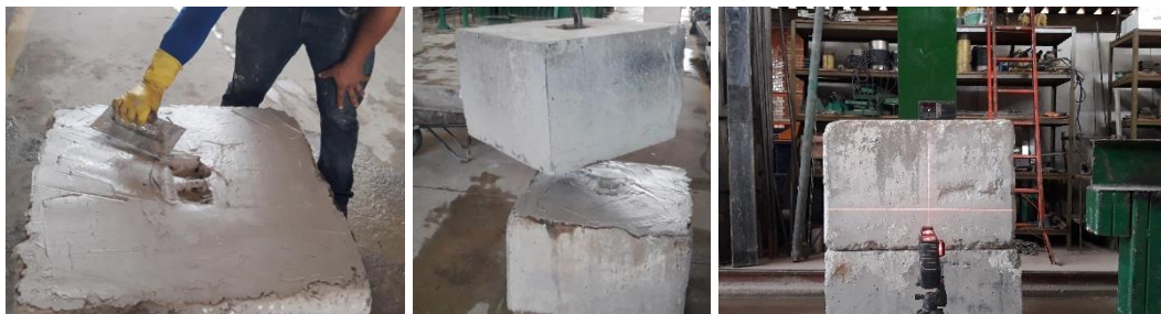
(b) Assentamento dos blocos de concreto com cal hidratada
