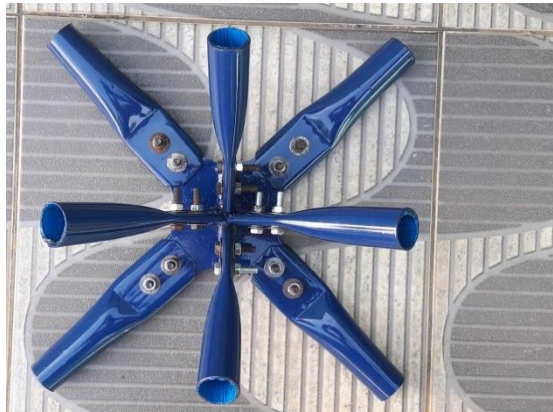
(j) Ligação Típica com dispositivo de chapa de aço Modelo 4- Combinação Sistema b 4
