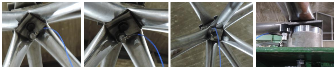
(b) Posição dos acelerômetros nas ligações dos banzos superiores e no apoio da treliça
