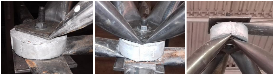
(b) Distanciadores de concreto na ligação típica: extremidade; central e canto da diagonal
