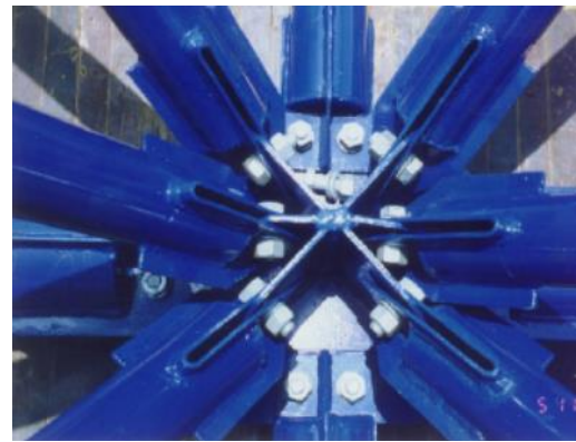
(o) Ligação típica com Ponteiras proposto por (Sampaio, 2004)
