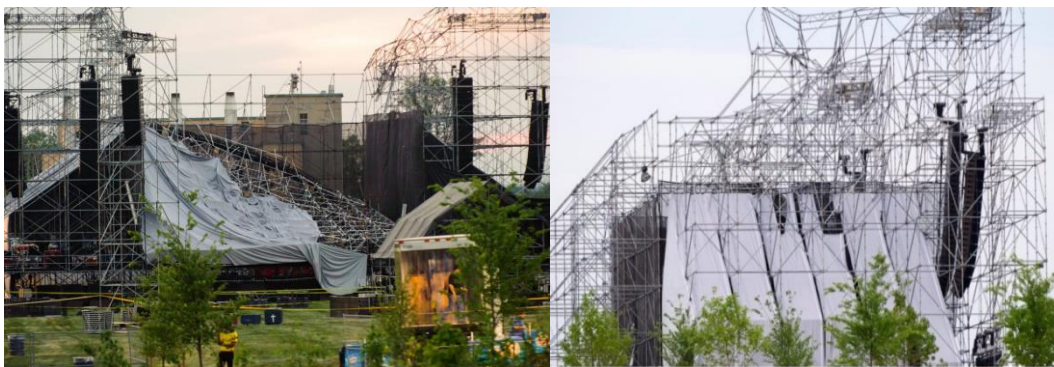
Figura 1.25 – Detalhes do colapso no “ Downsview Park ” no Canadá (Nicholson, 2012)
