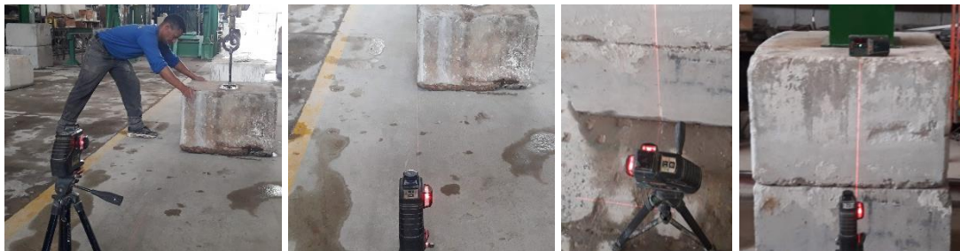
(a) Locação dos blocos de concreto
