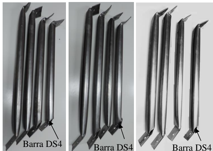
(c) Colapso das diagonais da LTE com maior variação de esmagamento entre barras
