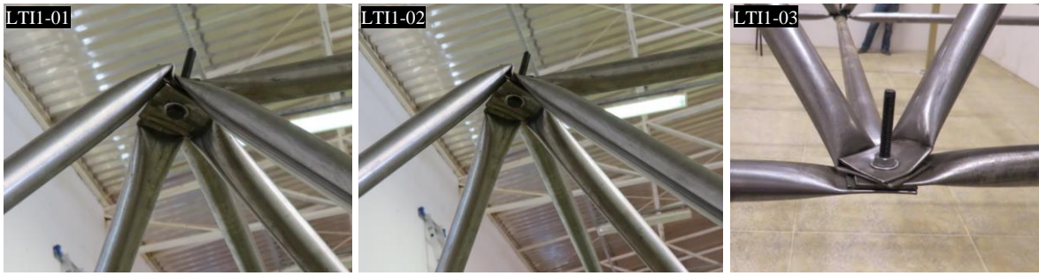
(a) Colapso do protótipo LTI1 com detalhe da ruptura na ligação típica
