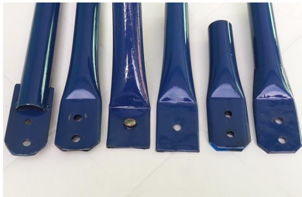
(n) Extremidade das barras de Ligação Típica usadas no Brasil
