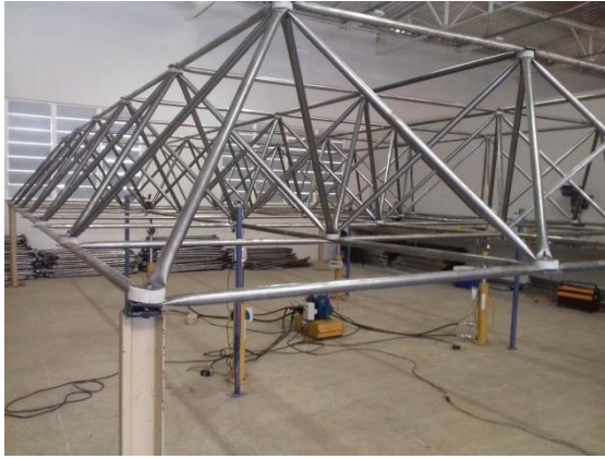
(d) Estrutura posicionada para o ensaio
