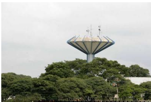
Figura 19: imagem do reservatório elevado da Ceilândia (Fonte: Patrick Grosner/DA Press 26 )
