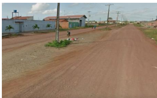
Figura 6 - Av. Das Oliveiras antes do asfaltamento
