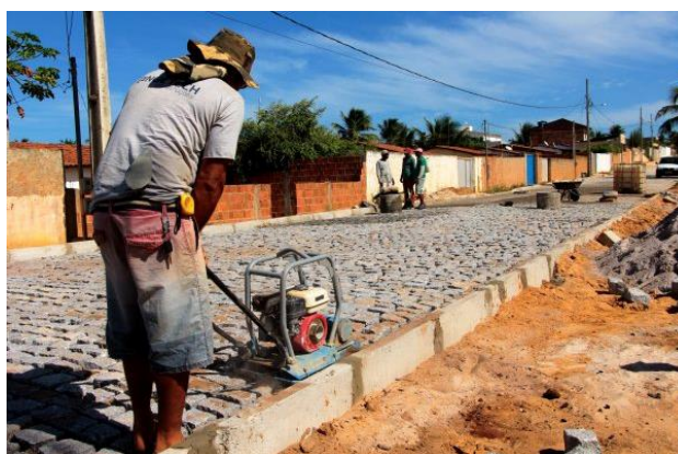
Figura 4 - Imagem da obra do GCCA
