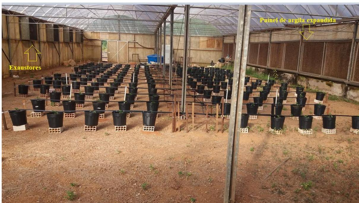
**Figura 6-1.** Vista interna da casa de vegetação e componentes de arrefecimento evaporativo do ar.
