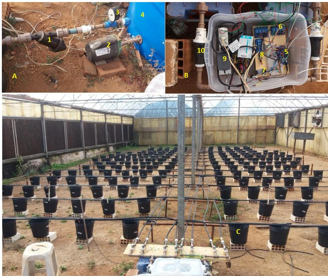
**Figura 5-4.** Sistema de bombeamento (A) com filtro de discos de 130 micra (1) Motobomba monofásica, 1/3 CV, afogada (2), manômetro com glicerina para medir pressão na saída da bomba (3) e reservatório de 1000 L (4). Componentes do sistema de automação da irrigação (B) com placa Arduino (5), módulos relés (6), módulo data logger (7), módulo RTC (8), fonte reguladora de tensão (9), regulador de pressão (10). Visão geral do sistema de irrigação e cultivo (C).
