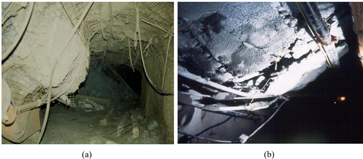
Figura 2.15 – Ruptura de sistema de suporte causado por bulking : (a) sistema de suporte composto por chumbadores e tela metálica (b) sistema de suporte composto por chumbadores, tela metálica e concreto projetado (Kaiser & Cai, 2013).
