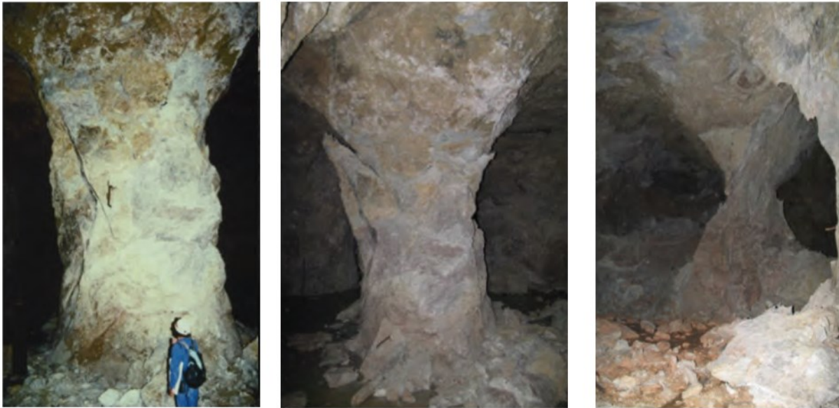
Figura 2.10 – Processo de ruptura registrado em um pilar de mina subterrânea (Sorgi & Gennaro, 2011).
