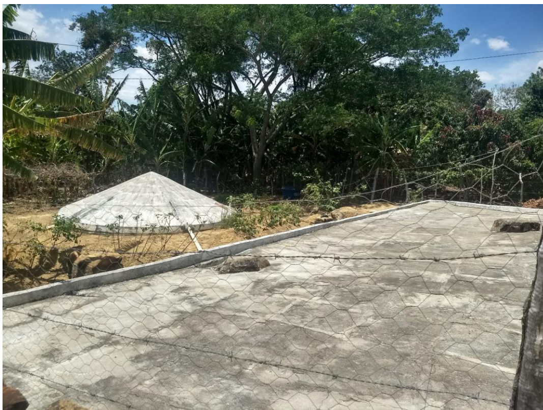
Figura 6. Estrutura para captação de água de chuva na comunidade Santo Antonio de Coroas
