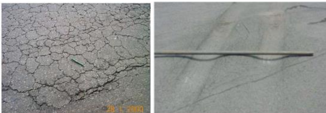
Figura 2.9 – Do lado esquerdo uma trinca por fadiga do tipo couro de jacaré e do lado direito um exemplo de deformação permanente (Franco, 2007)
