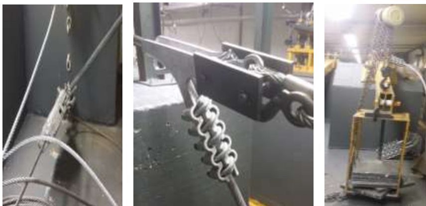
Figura 3.16: Tracionamento: (a) Talha de alavanca, (b) grampo de ancoragem e (c) alavanca de pesos.
