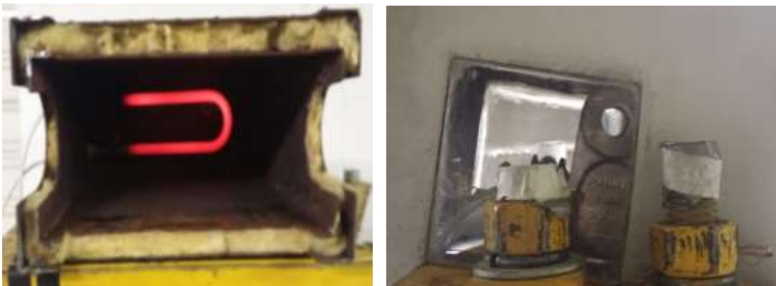
Figura 3.2: Sistema de retenção e inspeção visual. (a) Manta de lã de vidro e (b) Visor para inspeção do sistema.
