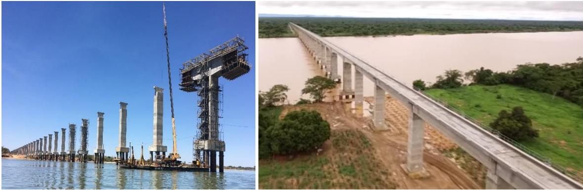
Fig. 64 Vista da ponte fase de construção e após conclusão
