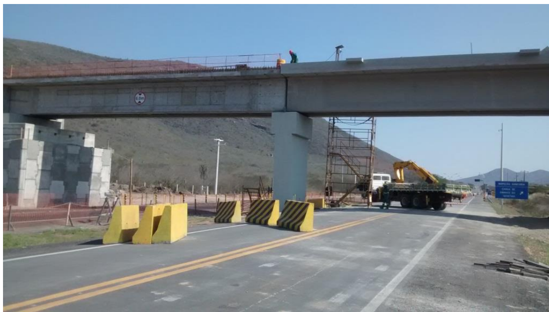
Fig. 69 Viaduto BR 116 - concluído
