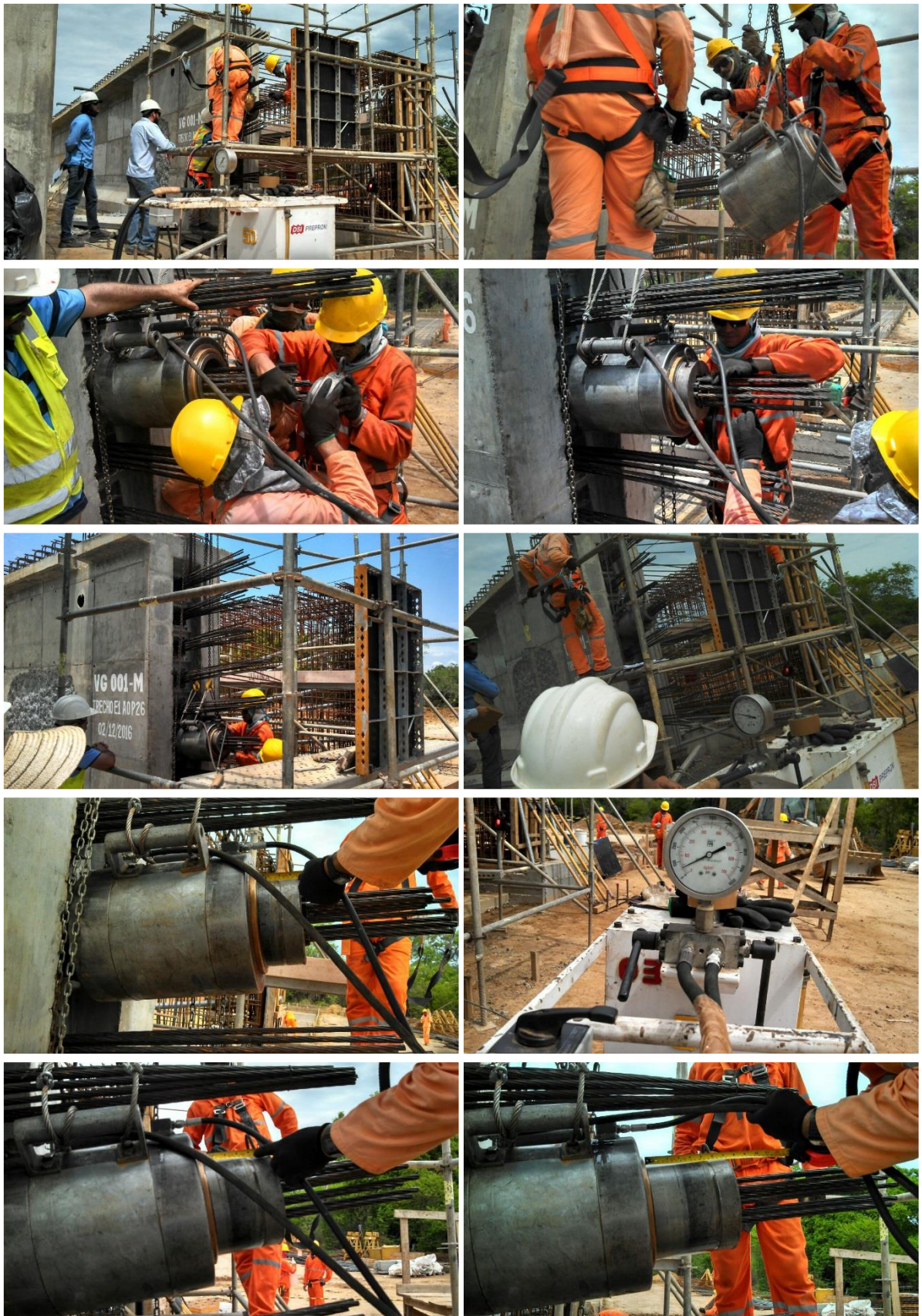
Fig. 9 Detalhes das etapas de protensão com macaco hidráulico (posicionamento do macaco, ajuste da placa e das cunhas, tensionamento e medição dos alongamentos e tensões)
