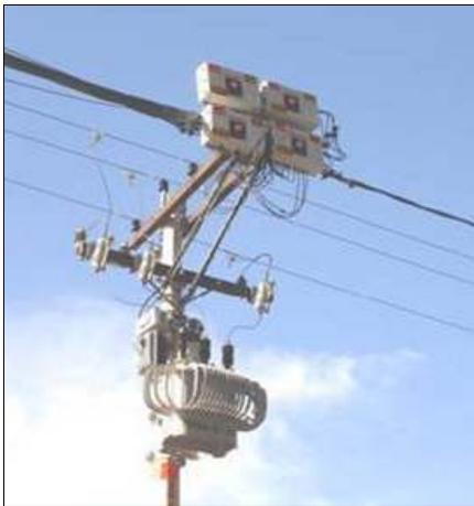
Figura 2.3- Sistema de medição centralizada instalado na área de concessão da Ampla (Ampla, 2008).
