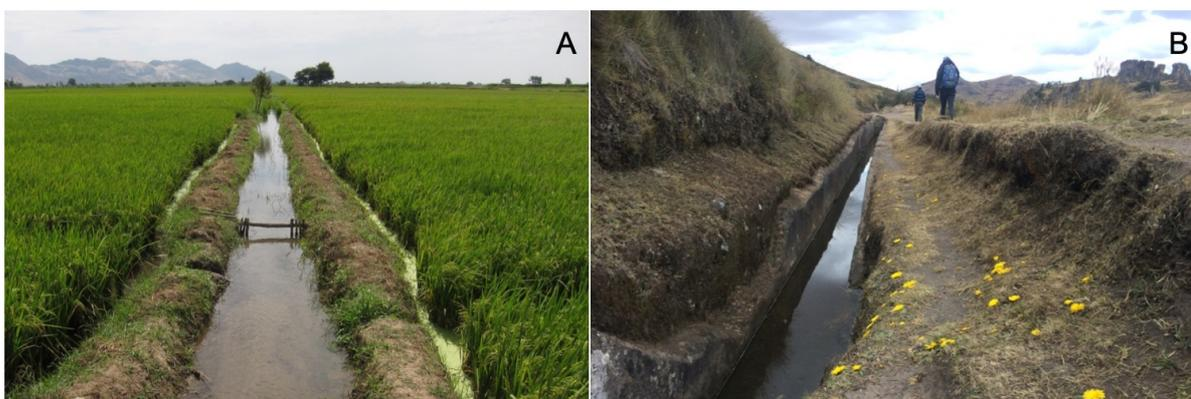
Figura 16. Modelos de canais de irrigação da costa norte do Peru: em baixa altitude para irrigação de campos de arroz no Vale do Jequetepeque (A); e em altitude, esculpido na rocha para transportar água dos terrenos altos para os vales, no departamento de Cajamarca (B). Fonte: Fotografias da autora (julho/2016).
