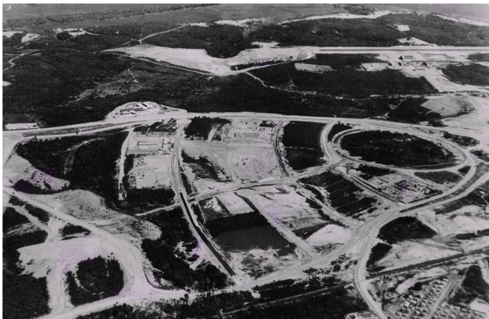
Figura 102: Distrito Industrial da Zona Franca de Manaus em construção - 1971 Fonte: (LIMA, [197?])
