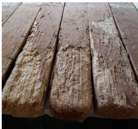
Figura 35. Aspecto esponjoso adquirido pela madeira de marupá devido ao processo de biodeterioração.
