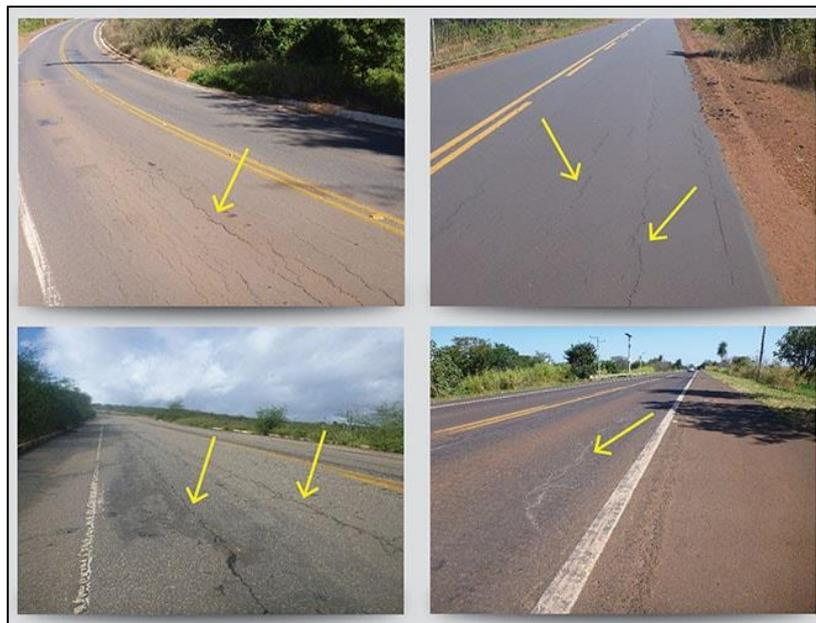
Figura 1.3 – Trincas em pavimentos flexíveis
