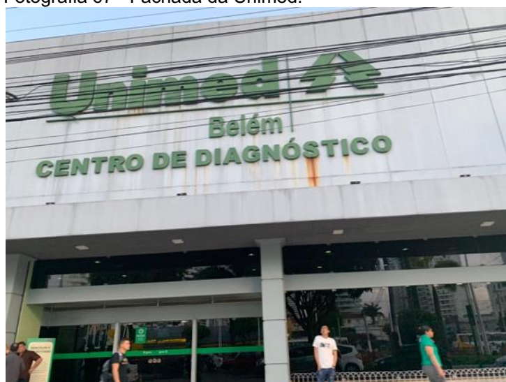
Fotografia 67 - Fachada da Unimed.
