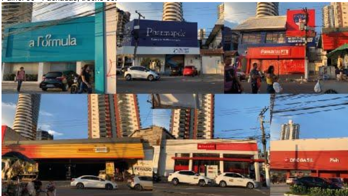
Painel 80 - Fachadas, trecho 03.
