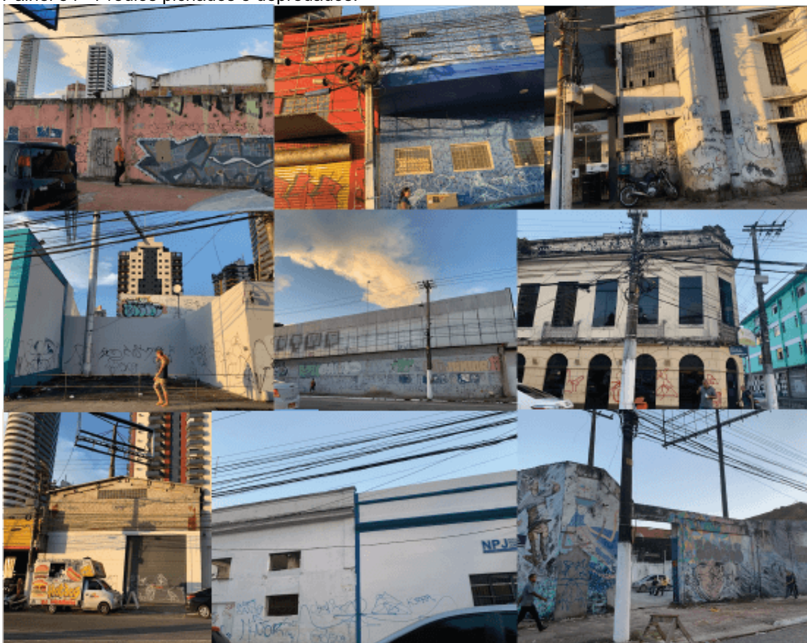
Painel 84 - Prédios pichados e depredados.
