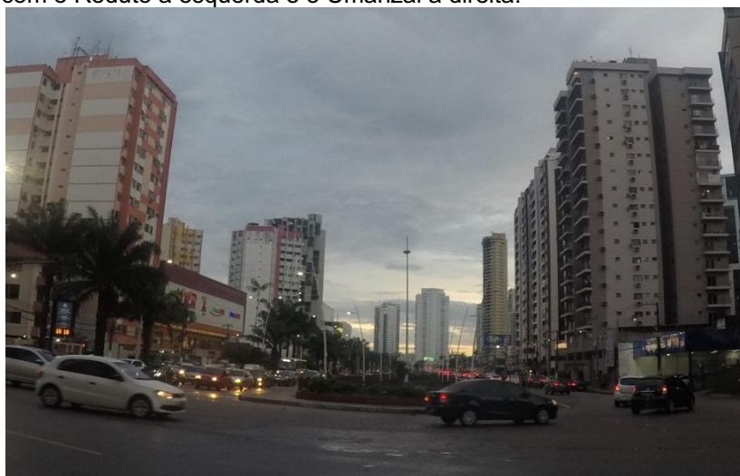
Fotografia 56 - Vista da Avenida Visconde de Sousa Franco com o Reduto à esquerda e o Umarizal à direita.
