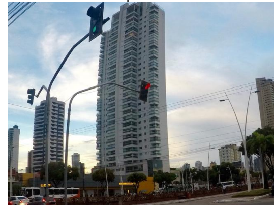
Fotografia 34- Av.Visconde de Sousa Franco e Rua e Rua Municipalidade.
