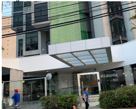
Fotografia 79 - Fachada do edifício Atalanta.
