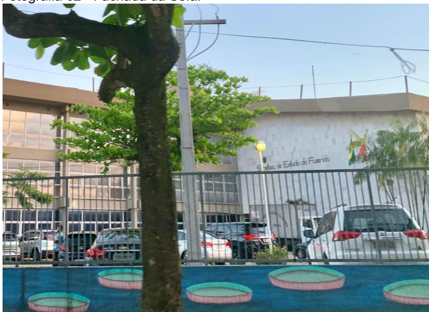
Fotografia 62 - Fachada da Sefa.
