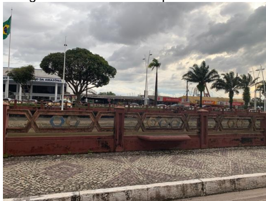
Fotografia 50 - Guarda-corpo do canal.
