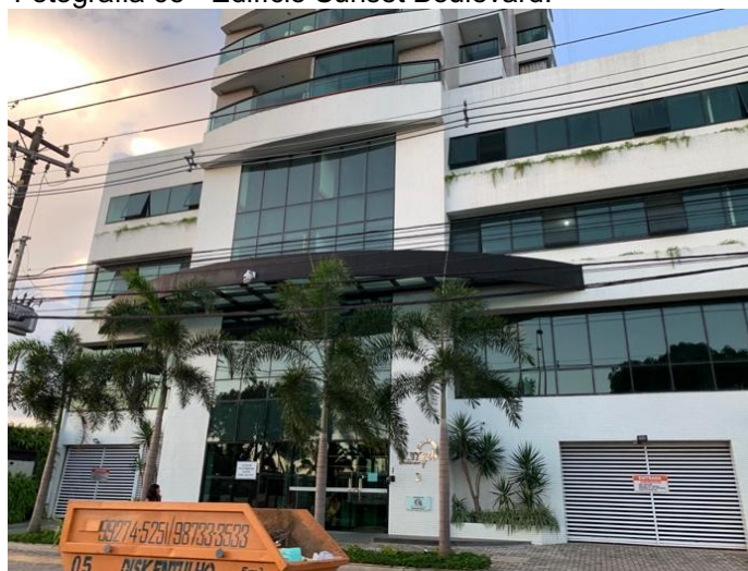
Fotografia 65 - Edifício Sunset Boulevard.
