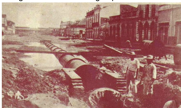
Fotografia 17 - Obras do Igarapé das Almas.
