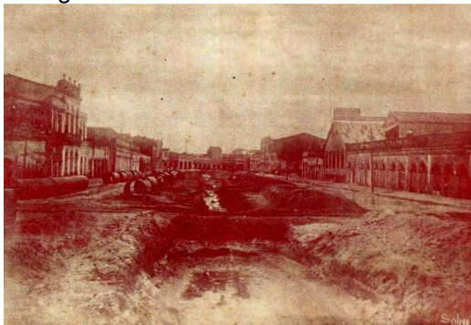
Fotografia 18 – Obra na rua 28 de Setembro
