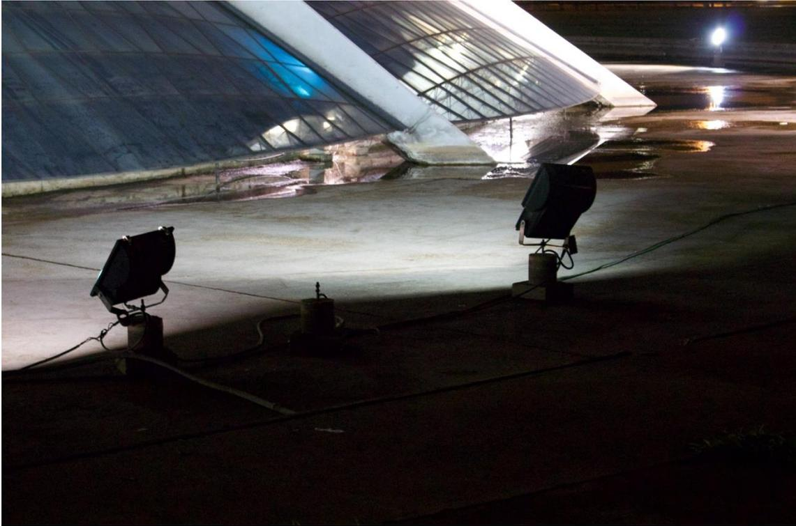
Figura 70 – Cabeamentos dos refletores, que deveriam estar protegidos, se encontram dentro da água<sup>139</sup>
